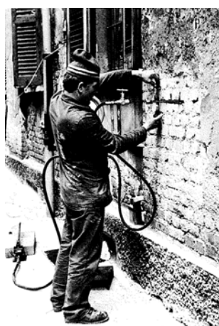
Fig. 2.14: Medida del estado de sollicitación en uno de los muros del edificio ubicado en Piazzale Dateo, Milán (Rossi et al. 1982b)
