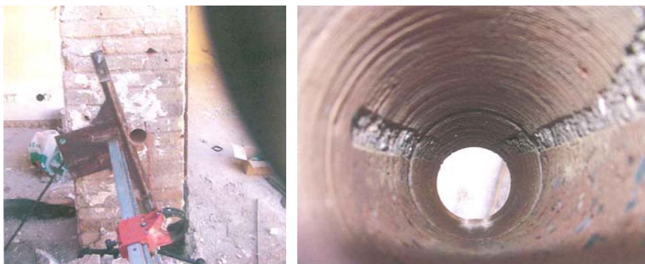
Fig. 2.304 y 2.305: Sonda para la ejecución de un ensayo presiométrico sobre una pilastra de ladrillo (Griera 2007).
