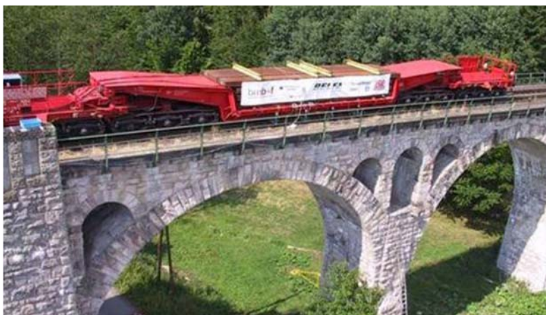
Fig. 2.310: Prueba de carga sobre un arco de fábrica empleando BELFA-DB (Gutermann y Knaack 2008).
