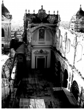
Fig. 2.125: Catedral de Noto después del colapso
