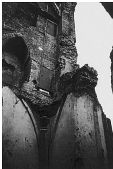
Fig. 2.95: Iglesia de S a . M a Magdalena en Goch-Alemania tras su colapso en 1993 (Binda 2008c).
