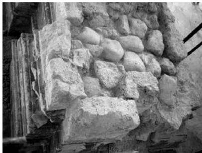
Fig. 2.126: Detalle de uno de los pilares de la Catedral (Binda et al. 2003c)
