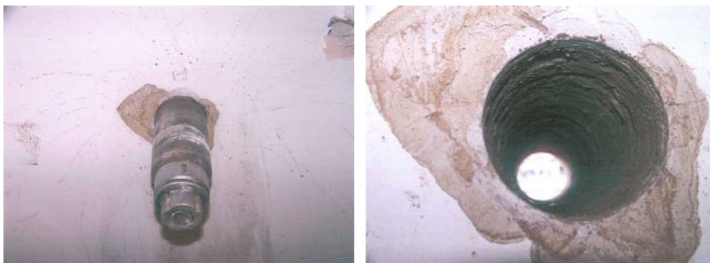
Fig. 2.295: Detalle de la sonda dentro de un muro de tapia (Griera 2007).
