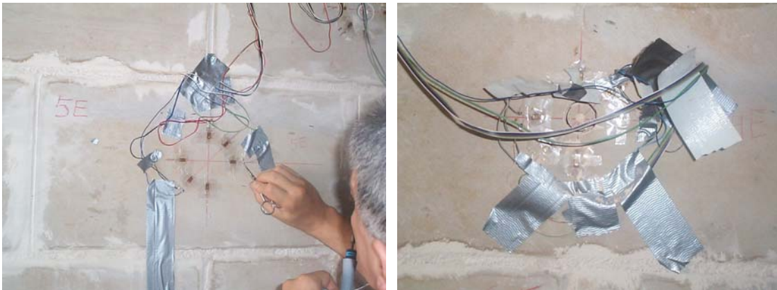
Fig. 2.222: Instante durante la instalación de las galgas extensométricas en un sillar para la ejecución de un ensayo de hole drilling (Proyecto SICEXPAR, cortesía GEOCISA).
