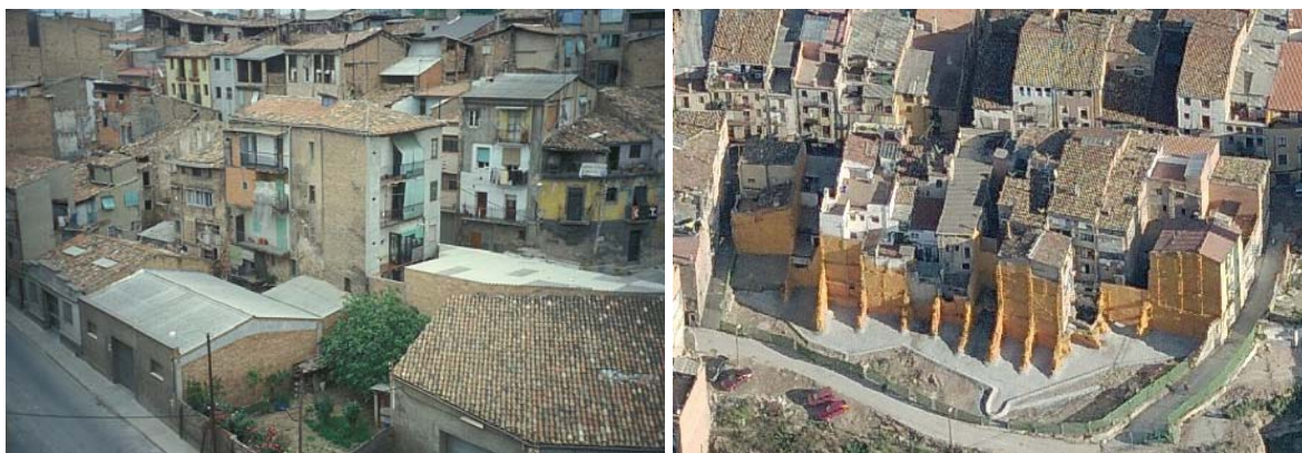
Fig. 2.291 y 2.292. Fotografías antes y después del derribo (Díaz et al. 2009). Los edificios que constituyen el objeto del estudio se sitúan en la manzana limitada por las calles Escodines, Montserrat y Sant Antoni del casco histórico de Manresa.
