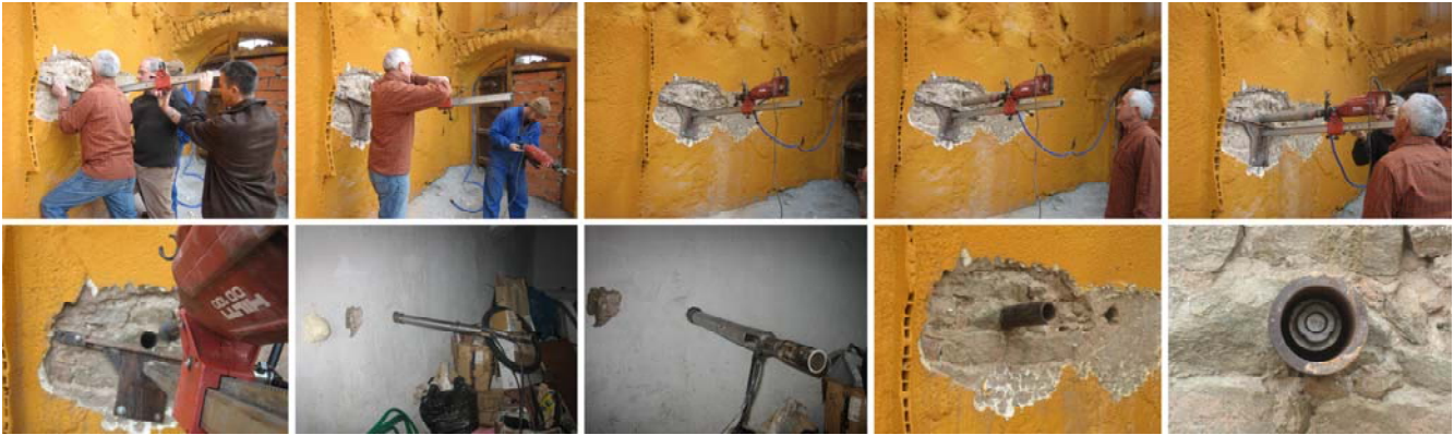
Fig. 2.294: En las imágenes se observa, tanto desde el interior como del exterior de un inmueble, el proceso de la instalación de la sonda en un muro de mampostería ordinaria (Díaz et al. 2009).
