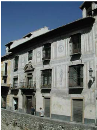
Fig. 2.250: Vista del edificio de Carrera del Darro 25 (Granada) sobre el callejón, paralelo al río Darro, que se encuentra cerrado al público.
