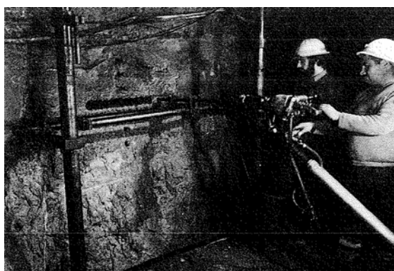
Fig. 2.18: Ejecución del corte de la roza horizontal (Faiella et al. 1983).
