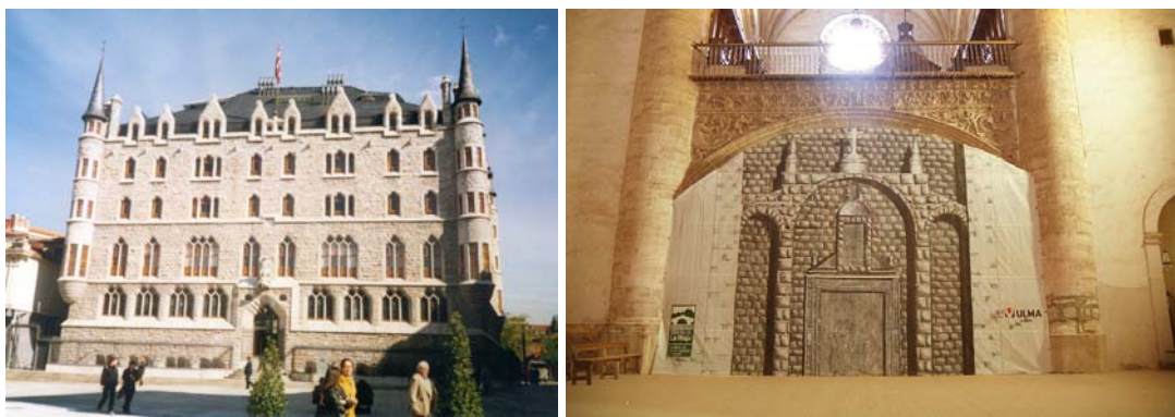
Fig. 2.227: Vista general de la Casa Botines (León, España).
