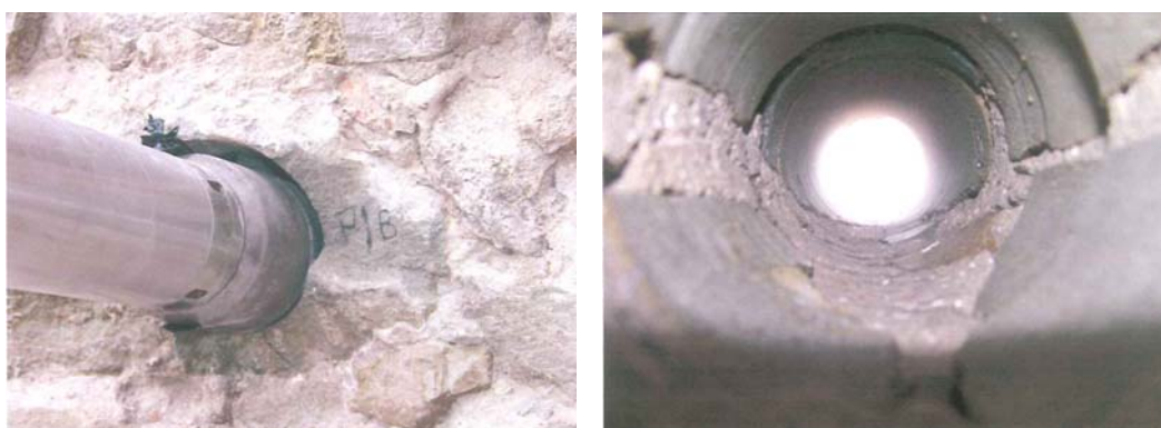
Fig. 2.301: Detalle de la sonda dentro de un muro de mampostería (Griera 2007).
