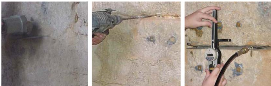
Fig. 2.106: Ensayo de gatos planos: Ejecución de la roza con sierra y taladro. Instante durante la medición (Lourenco et al. 2008).
