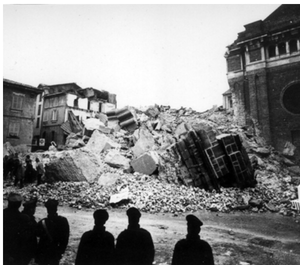
Fig. 2.44: Colapso de la Torre Cívica de Pavia 1989 (Binda et al. 2000a)
