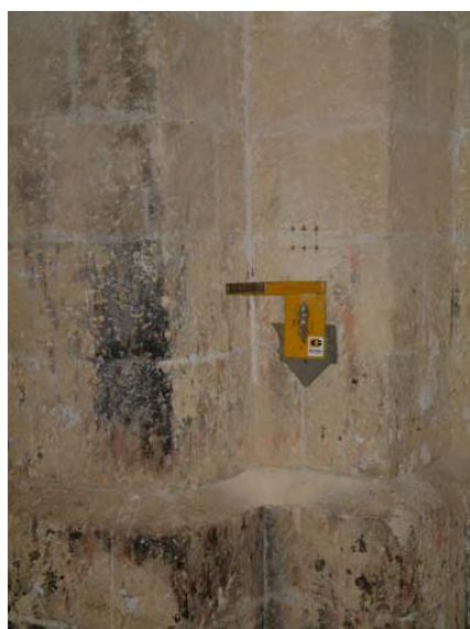
Fig. 2.182: Ensayo de gato plano simple en el Pilar 1 de la iglesia de Turégano, España (Fuente ONSITEFORMASONRY)
