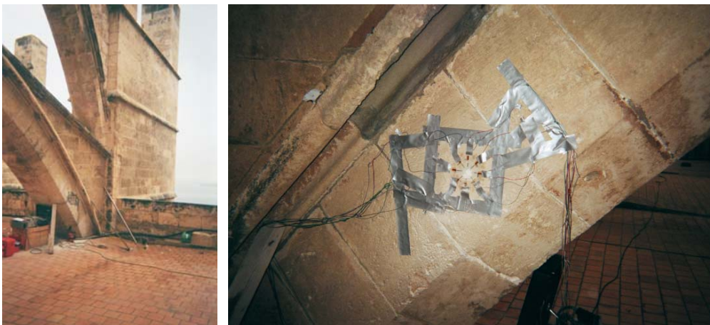
Fig. 2.259: Aspecto general de la zona de ensayo (Roca 2009a).
