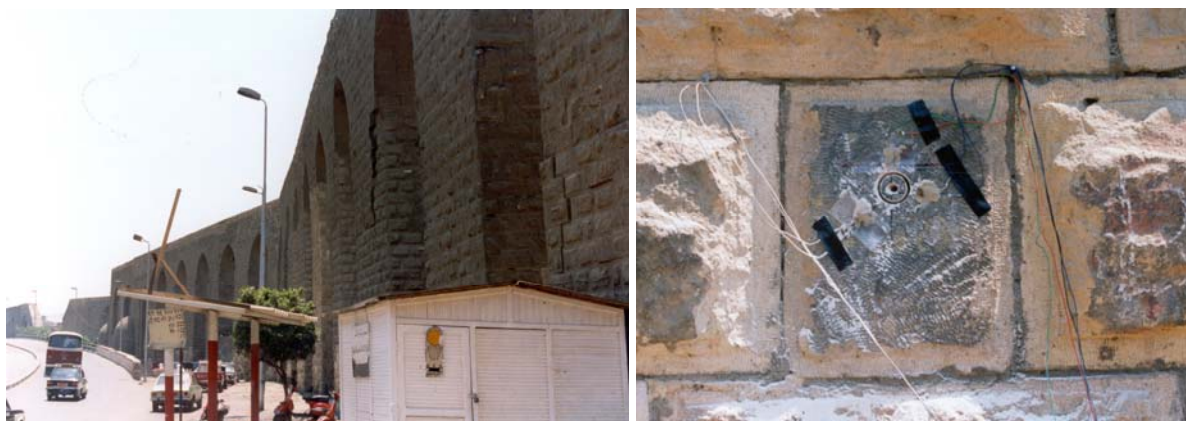
Fig. 2.231: Aspecto general del Acueducto del Sultán El Ghouri (El Cairo, Egipto).
