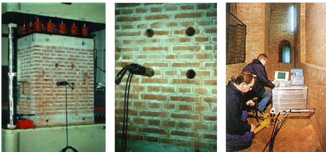
Fig. 2.271 y 2.272: Ensayos dilatométricos de calibración ejecutados en muros de fábrica de ladrillo (Spera G., recurso electrónico consultado en marzo de 2010).
