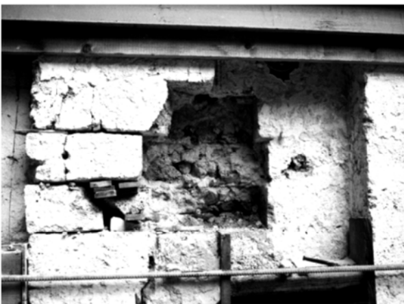
Fig. 2.128: Núcleo interno del pilar A', visible tras remover parte de su hoja externa.
