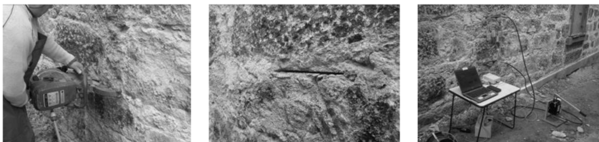
Fig. 2.158: Ensayo de gato plano doble: Ejecución del corte, aspecto de una de las rozas y equipamiento utilizado en el ensayo (Miranda et al. 2009)
