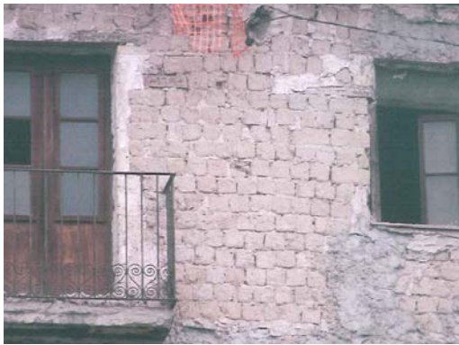
Fig. 2.298: Detalle general de uno de los muros de adobe (Griera 2007).
