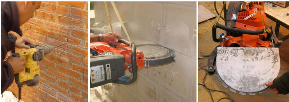
Fig. 3.19: Ejecución de la roza mediante taladrado en una fábrica de ladrillo ensayada en el Laboratorio de Estructuras de la Universidad de Cantabria.
