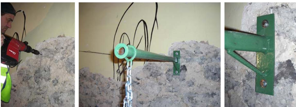
Fig. 3.24-3.26: Proceso de taladrado y empotrado del bastidor metálico de izado de la sierra de disco orbital marca Husqvarna K-950.
