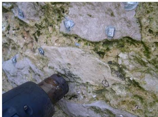
Fig. 3.7: Operación de secado previamente a la adhesión de los puntos de control. Palacio de Riva-Herrera, Santander (Cantabria, España).
