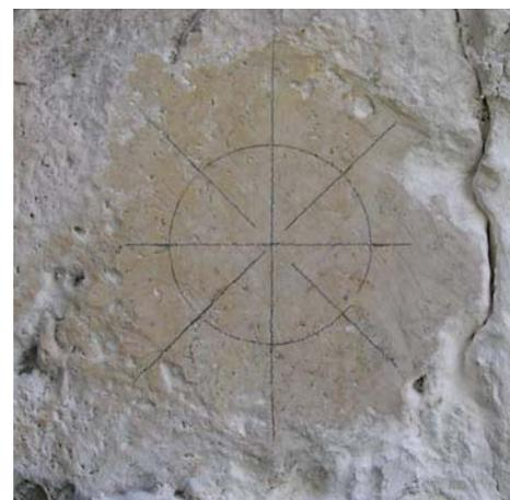
Fig. 3.82: Obtención de la alineación vertical mediante nivel de burbuja.
