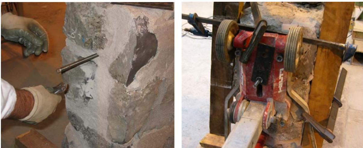
Fig. 3.118: Detalle del proceso de introducción del anclaje mecánico para izado del perforador en una mampostería caliza.
