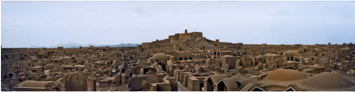
Fig. 4.5.18: La bimilenaria ciudadela de Arg-é-Bam (en Irán) la mayor estructura en tierra del mundo.
