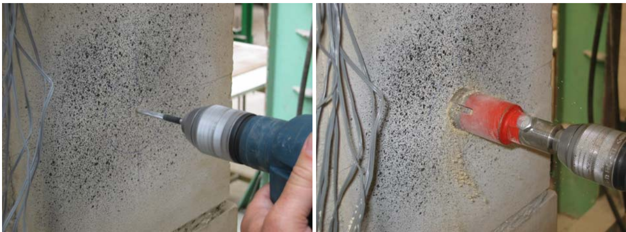
Fig. 4.1.120 y 4.1.121: Diferentes instantes durante la perforación del orificio.
