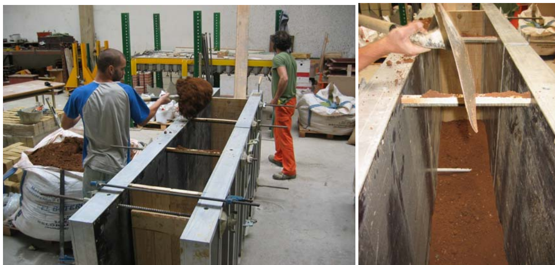
Fig. 4.5.35 y 4.5.36: Vertido de tierra dentro del encofrado (Junio 2009).
