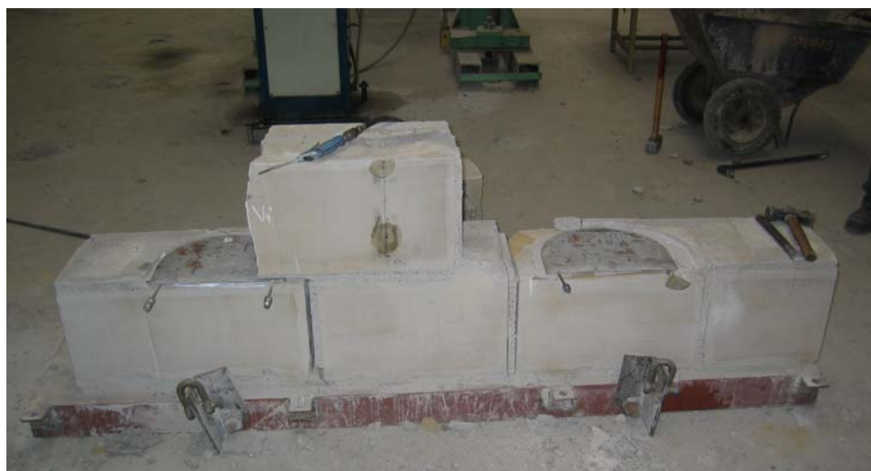
Fig. 4.1.255: Detalle de la posición de los gatos planos GPS-A Inferior (izquierda) y GPS-B Inferior (derecha) en una fase avanzada del proceso de demolición.
