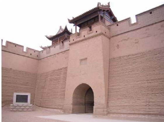
Fig. 4.5.7: Muralla parcialmente construida con tapial (el nivel superior está rematado con ladrillo) ubicada en Jiayuguan, China, edificada durante la dinastía Ming (1368–1644).
