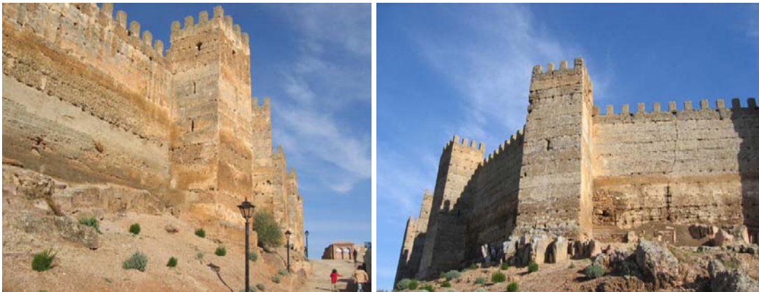
Fig. 4.5.12 y 4.5.13: Buena parte del castillo Califal de Burgalimar, en Baños de la Encina (Jaén), está materializado por tapial compuesto a base de arcilla, arena, cal y piedras pequeñas colocadas en cajas superpuestas.
