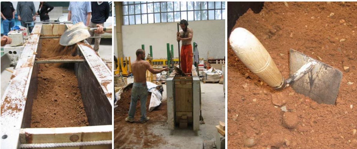
Fig. 4.5.39 y 4.5.40: Vertido progresivo de tierra.
