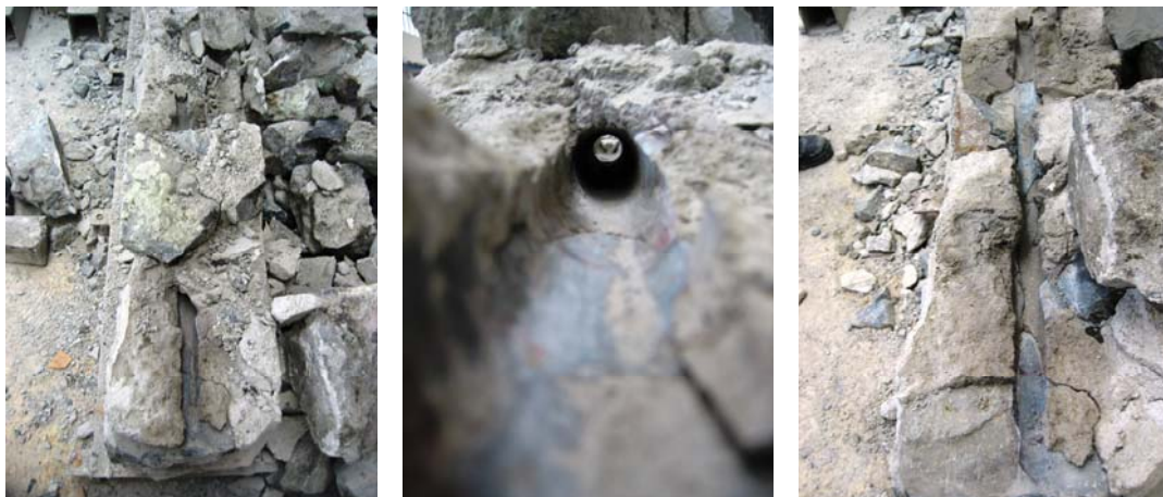
Fig. 4.2.123: Perspectiva general de la localización de los mini-presurómetros.
