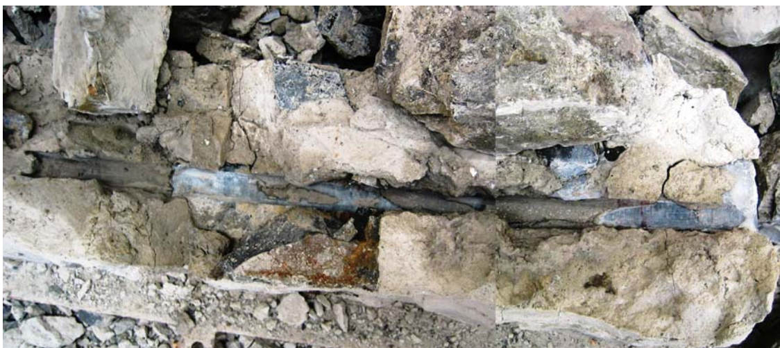
Fig. 4.2.126: Montaje fotográfico en el que puede apreciarse una vista en planta de la localización de los ensayos mini-presurométricos realizados en el muro de mampostería.
