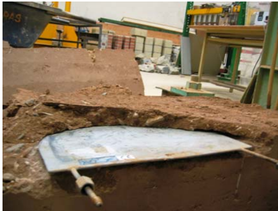
Fig. 4.5.178 y 4.5.179: Detalles de la posición del gato plano GPTap-Doble-Inferior en fase de demolición del tapial.
