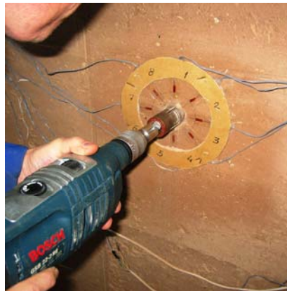
Fig. 4.5.145 y 4.5.146: Instante durante la perforación realizada en el ensayo HDTap1. La profundidad del taladro fue de 36.69 cm.
