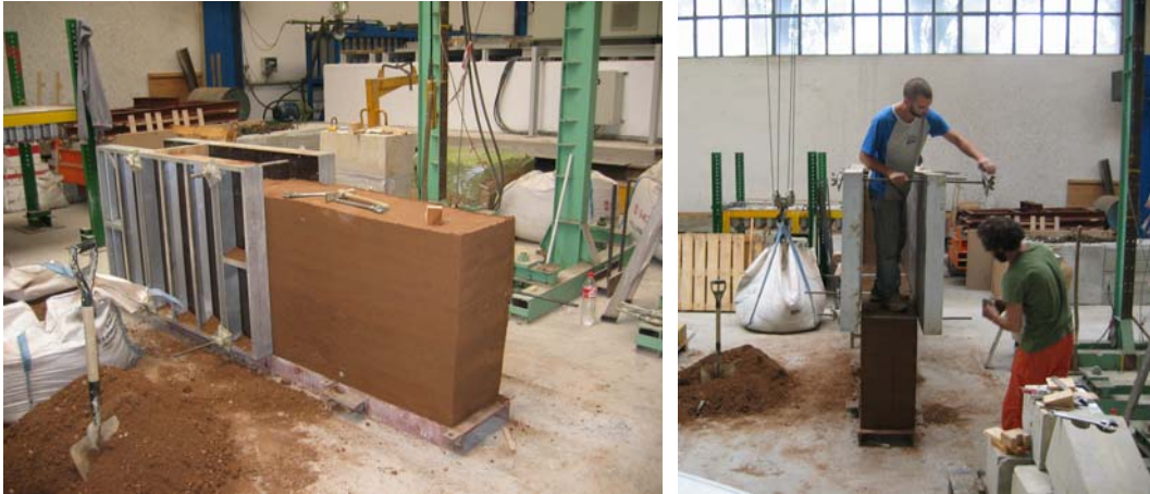
Fig. 4.5.45 y 4.5.46: Proceso de desmontaje del encofrado y disposición del mismo en la parte superior para continuar con el alzado del muro.
