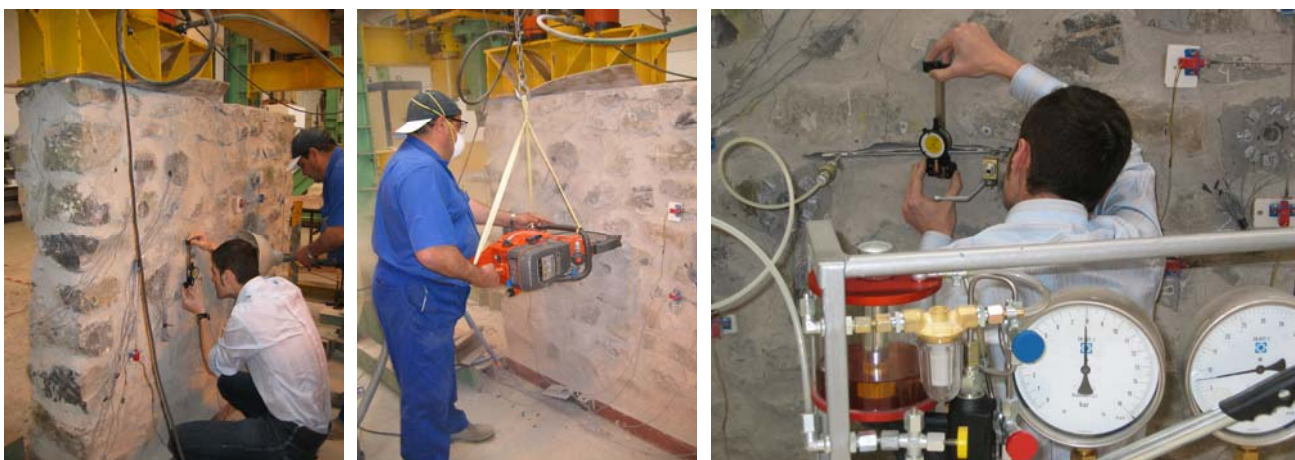
Fig. 4.2.62: Medida de la distancia de control previamente al corte.
