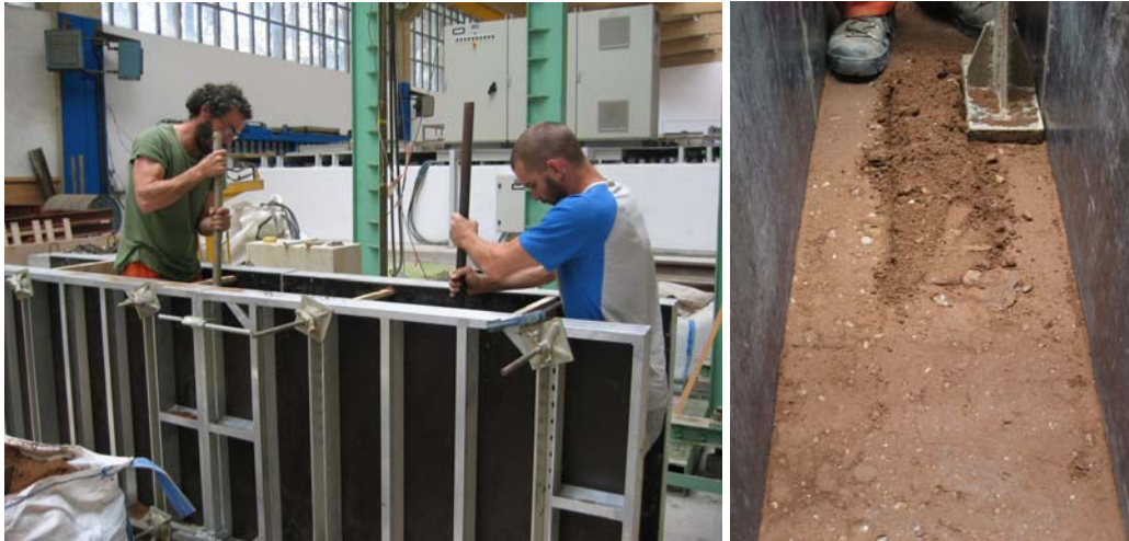
Fig. 4.5.37 y 4.5.38: Compactación de la tierra vertida mediante apisonado.
