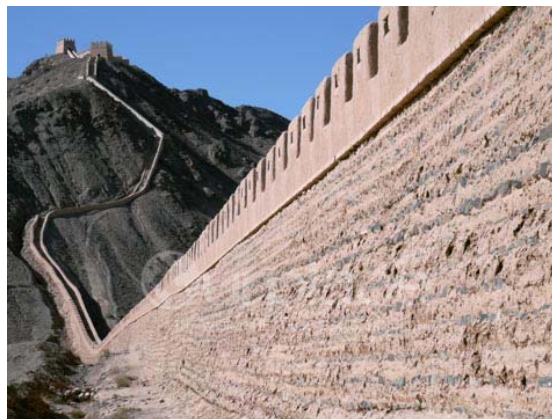
Fig. 4.5.7: Muralla parcialmente construida con tapial (el nivel superior está rematado con ladrillo) ubicada en Jiayuguan, China, edificada durante la dinastía Ming (1368–1644).
