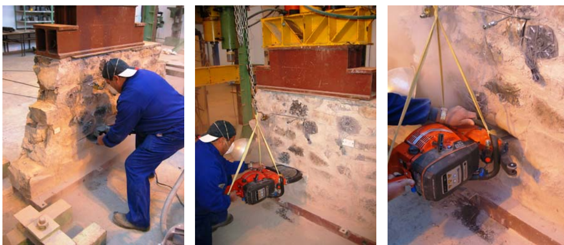
Fig. 4.2.79: Ejecución, mediante sierra de disco, de una roza para guiado de la sierra orbital.
