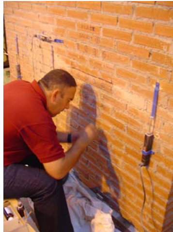
Fig. 4.3.66: Disposición de los puntos de control para el ensayo de doble gato plano.
