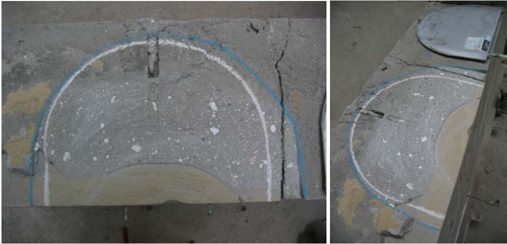
Fig. 4.1.249 y 4.1.250: Contornos de la roza y del gato plano GPS-A Superior.
