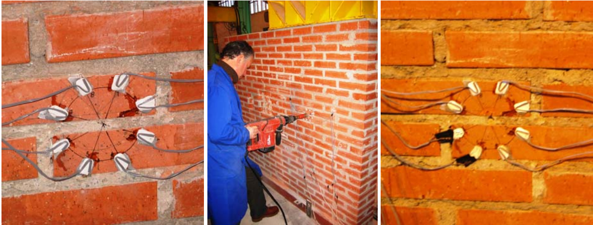
Fig. 4.3.33: Instante antes de la perforación del orificio.
