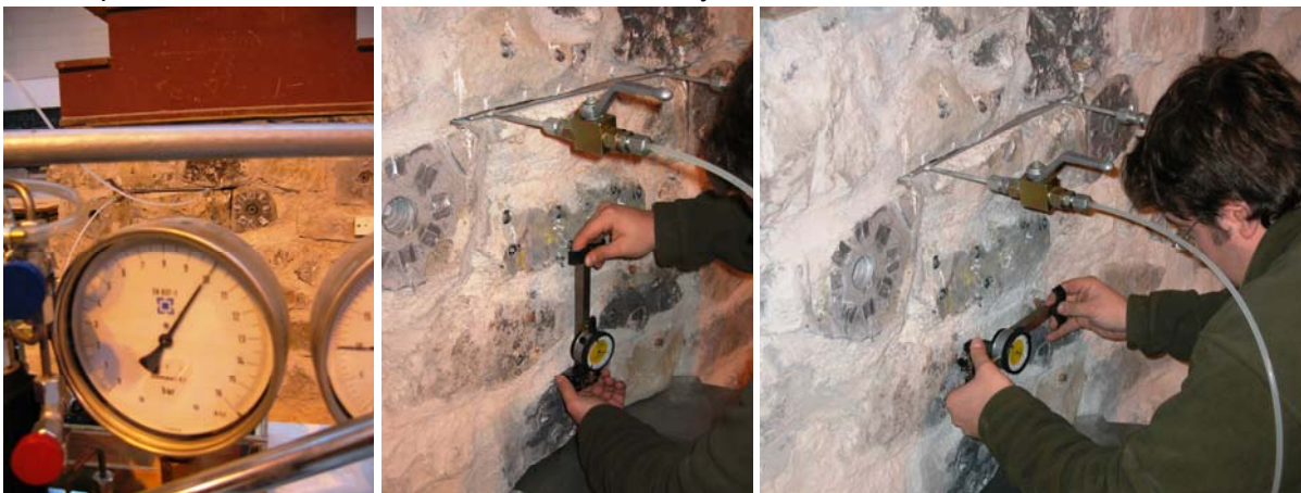
Fig. 4.2.85: Instante captado durante uno de los ciclos de presurizado, concretamente a 10 bar de presión instalada en los gatos planos.
