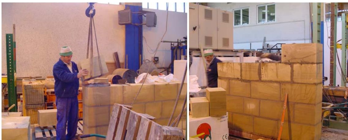
Fig. 4.1.2 y 4.1.3: Instantes tomados durante la construcción del muro de sillería armado a base de roca arenisca y mortero bastardo tipo M-20b, 1:2:10 (cemento:cal:arena, proporciones en volumen).
