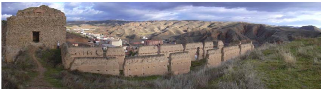
Fig. 4.5.16: Muestras de construcciones en tapial en la localidad aragonesa de Daroca.
