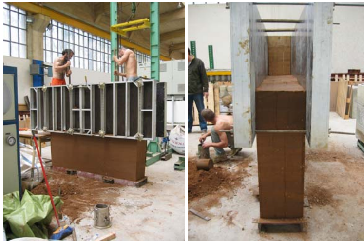
Fig. 4.5.47: Continuación del proceso de compactación.
