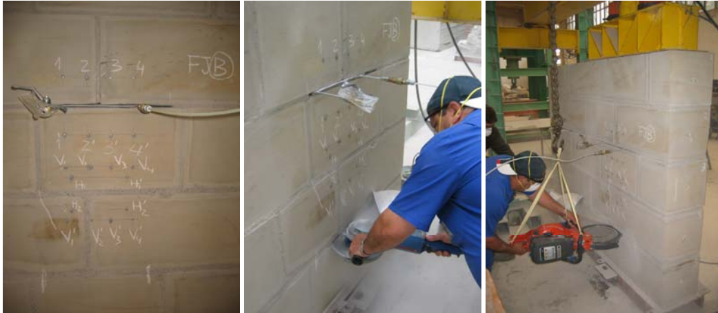
Fig. 4.1.168: Detalle de los puntos de control del ensayo GPS-B Doble, previamente a la ejecución de la roza.
