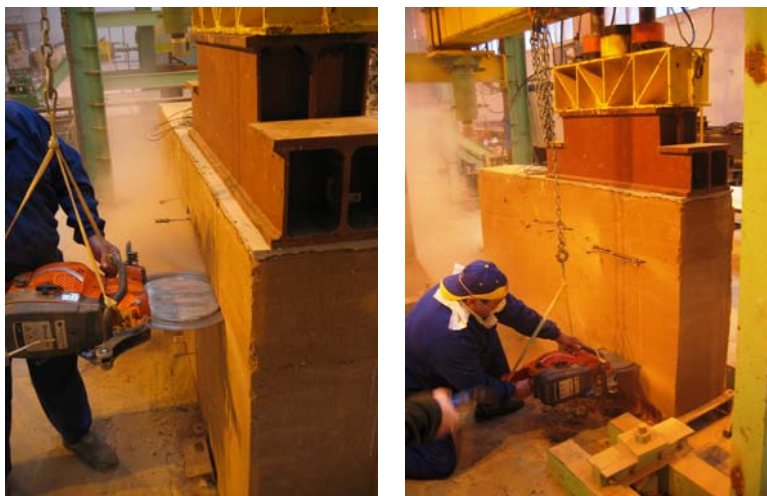
Fig. 4.5.125 y 4.5.126: Instantes captados durante la ejecución respectiva de las rozas superior e inferior movilizadas en el ensayo GPTap-Doble.
