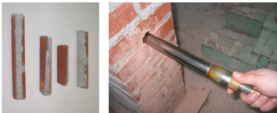
Fig. 4.3.114: Detalle de los materiales obtenidos fruto de la perforación. Puede apreciarse que en la misma se ha movilizado tanto ladrillo como mortero.
