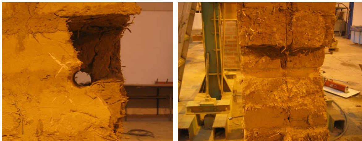
Fig. 4.6.115: Vista frontal de la perforación. Pueden apreciarse las grietas radiales remanentes del ensayo en los adobes circundantes a dicha perforación y uno de los planos de colapso, en primer término.
