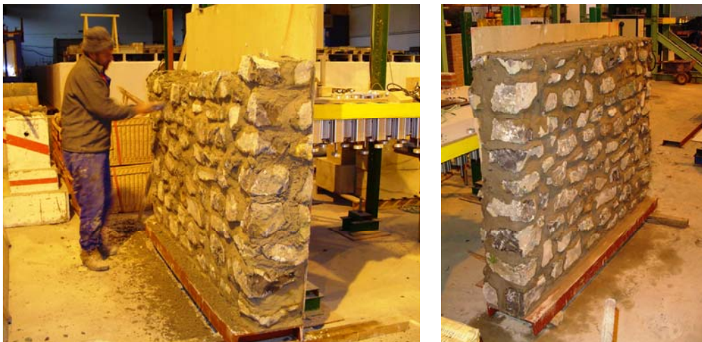
Fig. 4.2.4 y 4.2.5: Instantes tomados durante la construcción del muro de mampostería armado a base de roca caliza y mortero bastardo tipo M-20b, 1:2:10 (cemento:cal:arena, proporciones en volumen).
