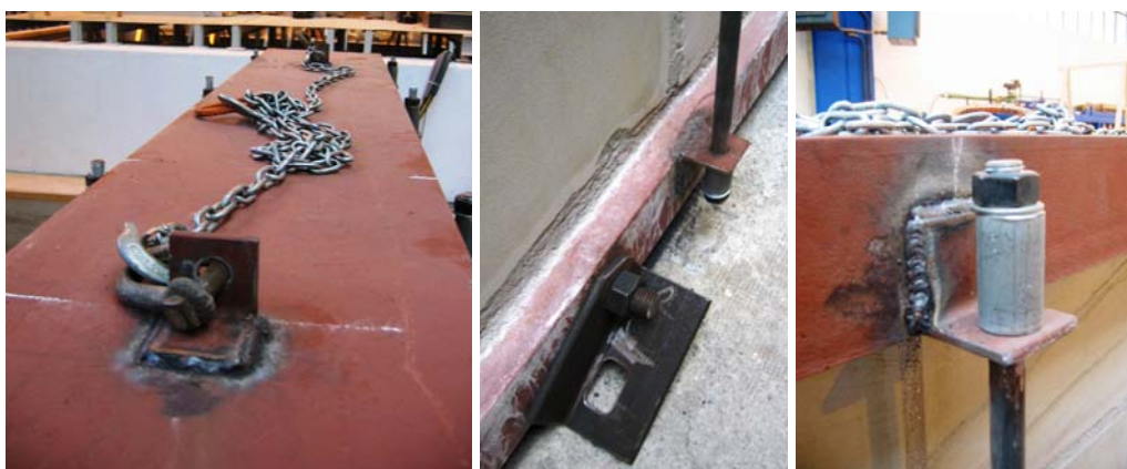
Fig. 4.1.6: Detalle del UPN superior a modo de capucha. Los elementos de anclaje que figuran en la imagen tienen la finalidad, única y exclusivamente, de permitir el izado y colocación de esta pieza en coronación del muro.
