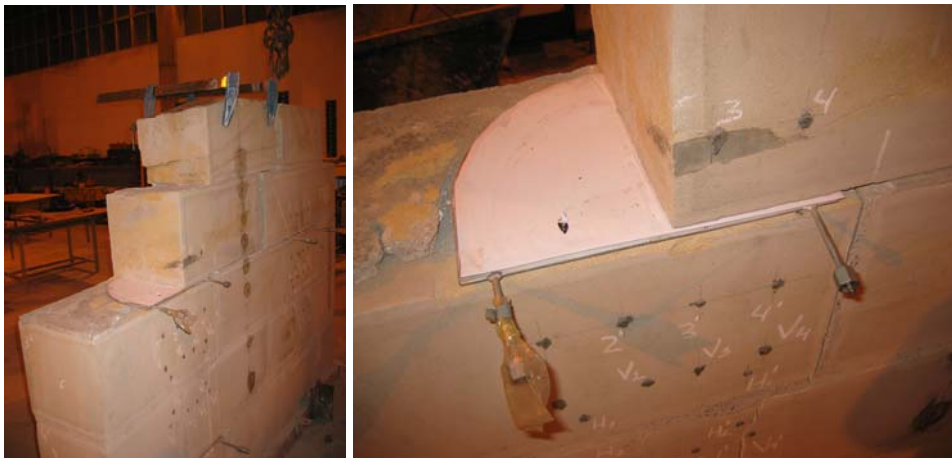
Fig. 4.1.245: Detalle de la posición del gato plano GPS-A Superior en fase de demolición de la sillería.
