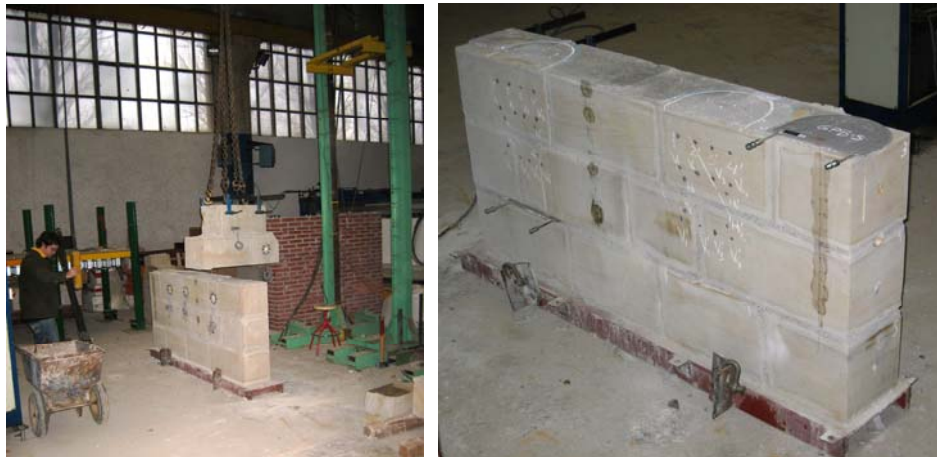
Fig. 4.1.262: Instante captado durante el proceso de demolición controlada.
