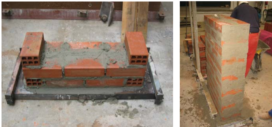
Fig. 4.4.2 y 4.4.3: Instantes tomados durante la construcción de los muretes de ladrillo hueco y mortero bastardo tipo M-20b, 1:2:10 (cemento:cal:arena, proporciones en volumen).
