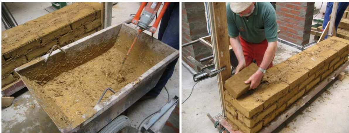
Fig. 4.6.4: Proceso de mezclado de los componentes del mortero constituido a partir de la fórmula de trabajo proporcionada por la empresa Adobera del Norte C.B.
