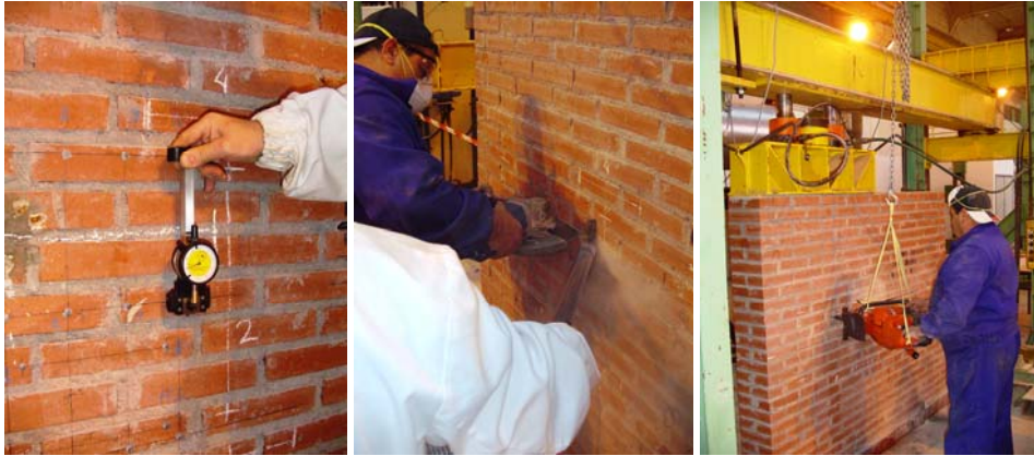
Fig. 4.3.73: Registro de la distancia existente entre los puntos de control antes del corte.
