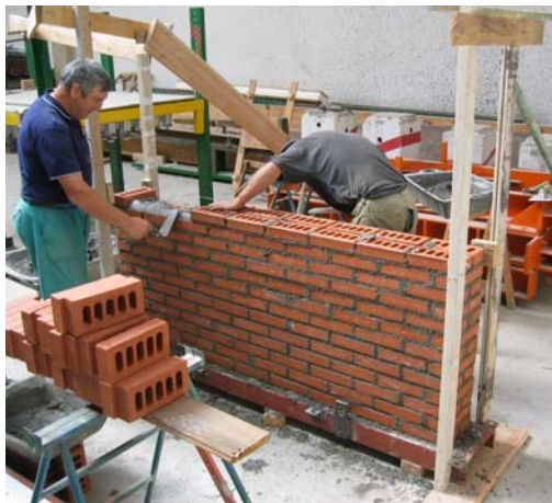
Fig. 4.3.2: Instante tomado durante la construcción del muro de fábrica de ladrillo.
