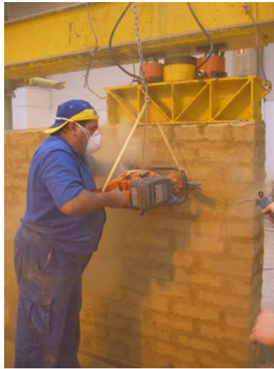
Fig. 4.6.62: Instante captado durante la ejecución de la roza mediante la sierra orbital.
