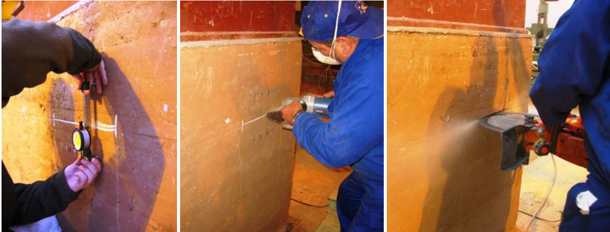
Fig. 4.5.104: Medida de las distancias iniciales existentes entre los puntos de control, previamente a la inserción del gato plano.
