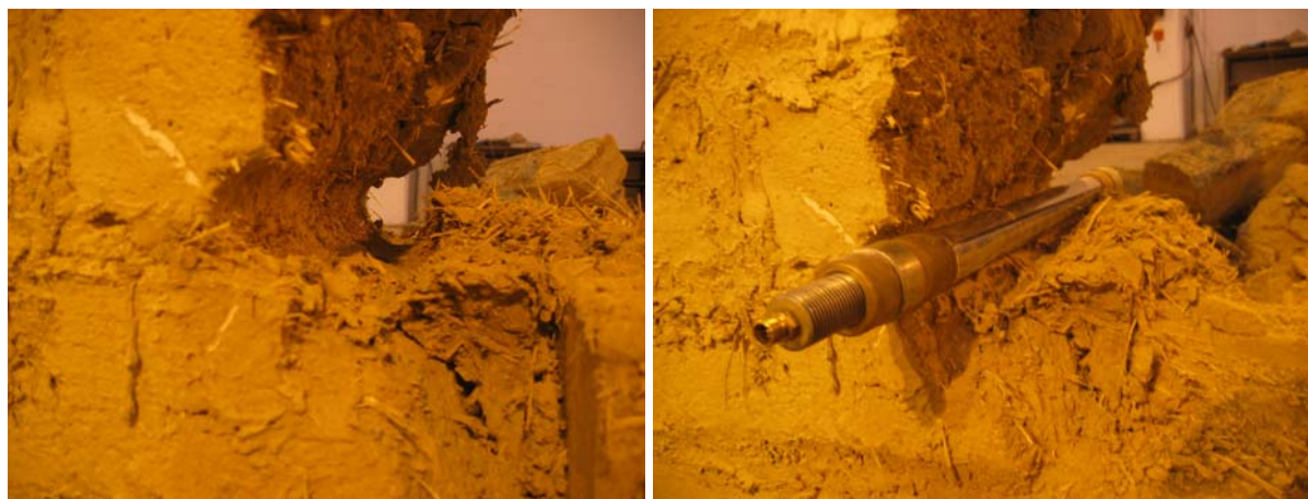
Fig. 4.6.117: Detalle de la perforación relacionada con el ensayo DILAd3.
