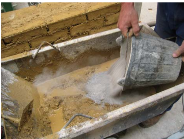
Fig. 4.6.2: Instante en el que se está añadiendo a la mezcla la arena de cantera (grijillo).
