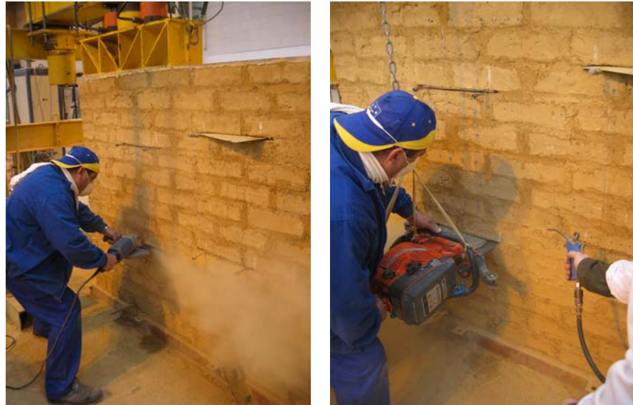
Fig. 4.6.48 y 4.6.49: Instantes captados durante la ejecución de la roza.
