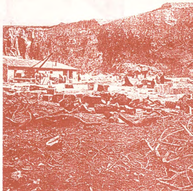
Pedrera Safont a la muntanya de Montjuïc.
