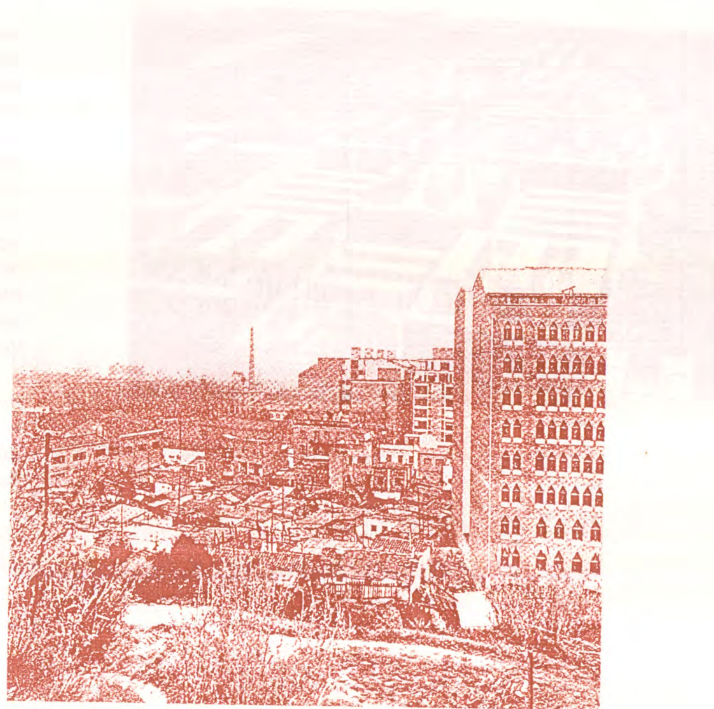
Aspecte del solar abans d'iniciar-se les obres de construcció dels habitatges corresponents a la 2 a fase del grup "La Viña". Font: Memòria del Patronat Municipal de l'Habitatge.
