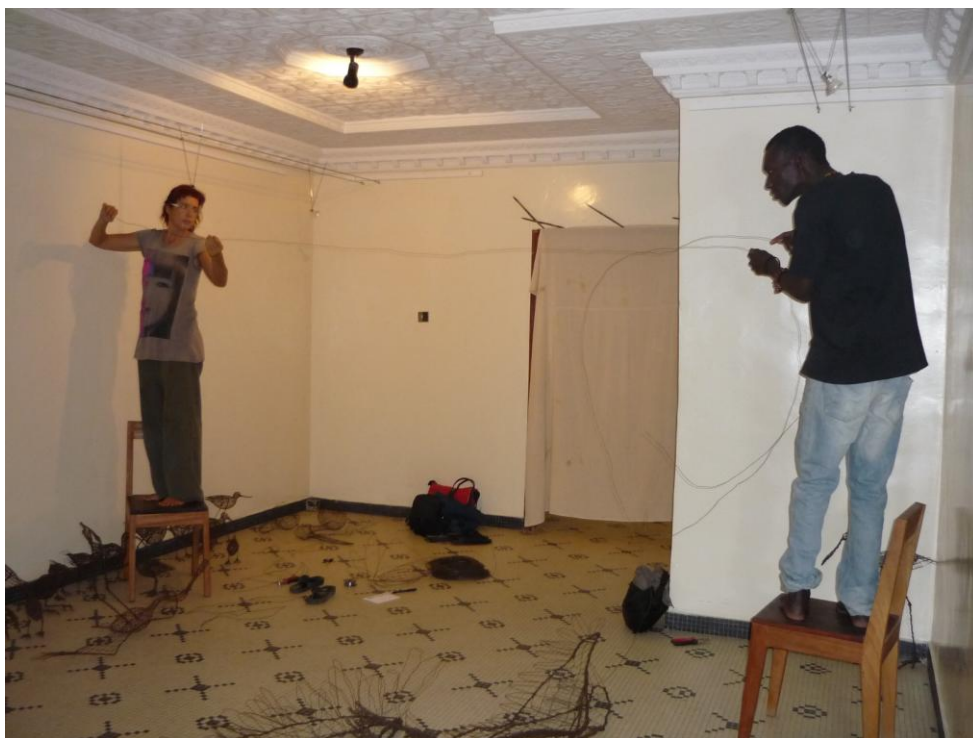
Figura 126. Alpha y Sofía montando la instalación en la Galerie Sinaa (Nouakchott, 13/11/2011)
