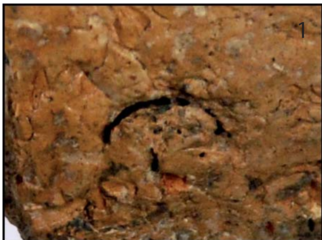
Grieta semicircular que indica la inserción del extremo del asa de cinta
