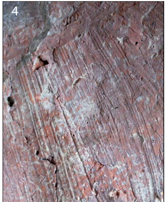
Acanaladuras rayadas formadas durante el compactado
