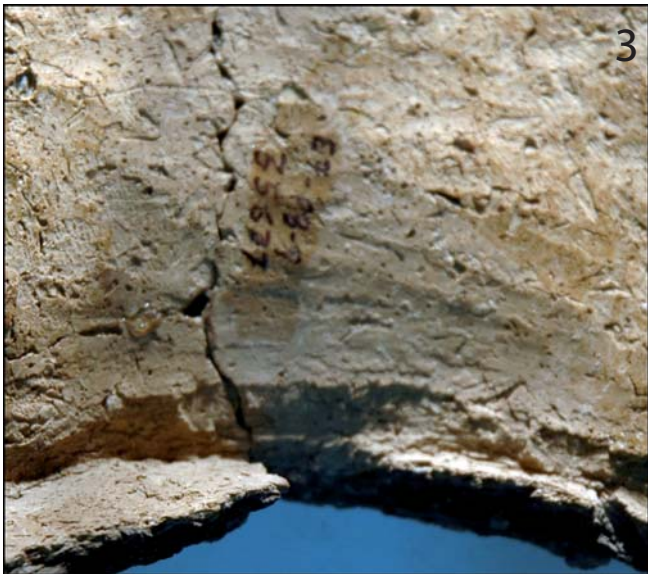
Acanaladuras generadas durante el compactado
