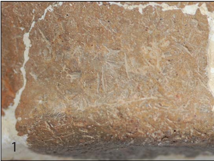
Rebas asociadas al alisado y arrastrado de la base
