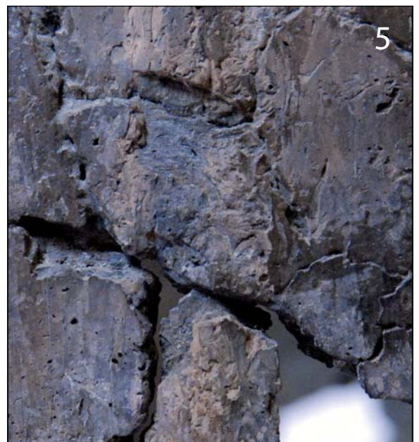
Fractura laminar que indica el ensamblaje del elemento secundario por arrastrado
