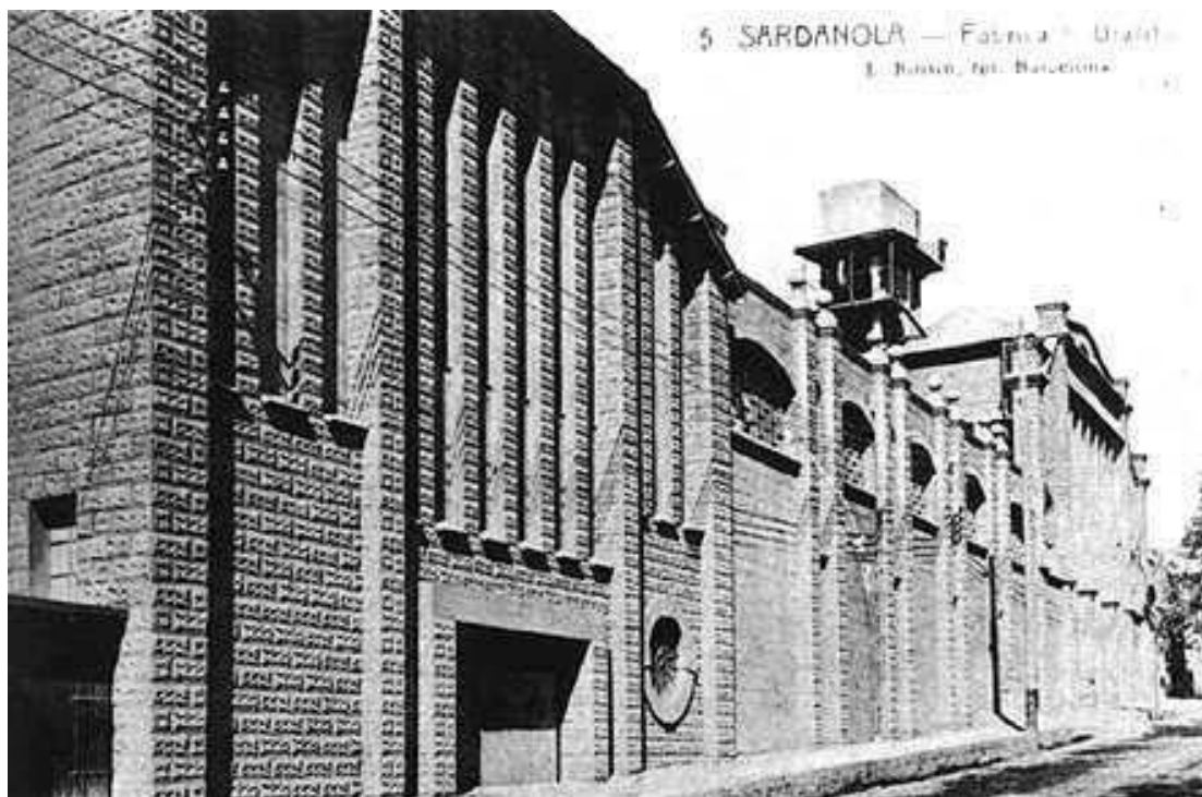
Font: Arxiu propi. Vista de la façana principal de l'empresa Uralita.
