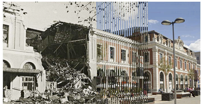
Desprendimientos latentes, 2011 Olalla Gómez
