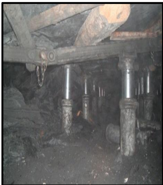
Fig.14. Entibado hidráulico actual de la Mina Malabá II, en Torre del Bierzo, León.
