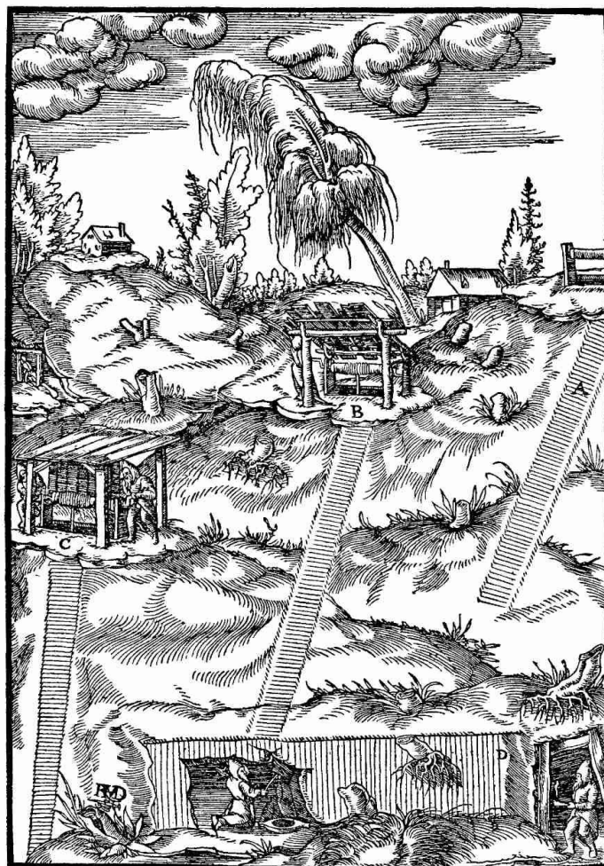
Fig.12. Otro ejemplo de la morfología de las minas, con varios accesos muy verticales hacia la galería y unos porches de madera cubriendo las entradas. En la galería, se observa un minero picando la pared de rodillas, mientras otro accede a la misma de pie con una lámpara. Fuente: HOOVER, Herbert Clark y HOOVER, Lou Henry. Georgius Agrícola. De Re Metallica. Translated from the first latin edition of 1556. Dover Publications, Inc., New York, 1950.
