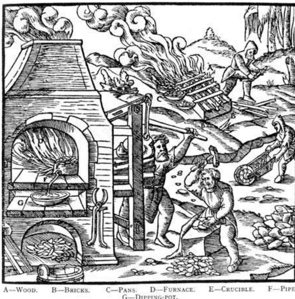
Fig.23. Al fondo de la imagen puede apreciarse a un minero tostando “mena” en una especie de pira; mientras que la escena principal muestra a un minero partiendo mena para ser introducida en un horno. Fuente: HOOVER, Herbert Clark y HOOVER, Lou Henry. Georgius Agrícola. De Re Metallica. Translated from the first latin edition of 1556. Dover Publications, Inc., New York, 1950.
