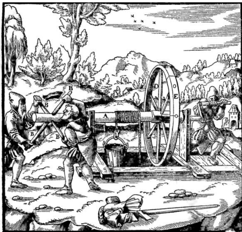
Fig.16. Mineros tirando del torno. Podía servir para drenar agua, para subir mineral o a los mismos mineros. En algunos casos, podían utilizarse équidos para tal efecto (otro tipo de torno). Fuente: HOOVER, Herbert Clark y HOOVER, Lou Henry. Georgius Agrícola. De Re Metallica. Translated from the first latin edition of 1556. Dover Publications, Inc., New York, 1950.
