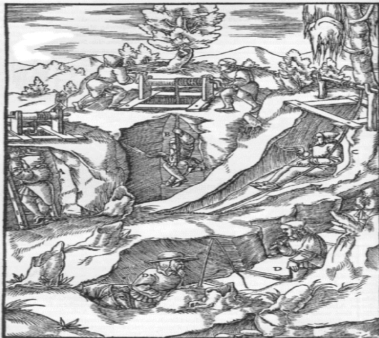
Fig.11. Grabado del tratado de Agrícola que muestra a los mineros descendiendo a los pozos subterráneos mediante tornos. Fuente: HOOVER, Herbert Clark y HOOVER, Lou Henry. Georgius Agrícola. De Re Metallica. Translated from the first latin edition of 1556. Dover Publications, Inc., New York, 1950.
