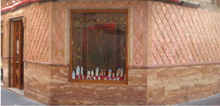
Figura 114. Fachada y vidriera en la esquina achaflanada.
