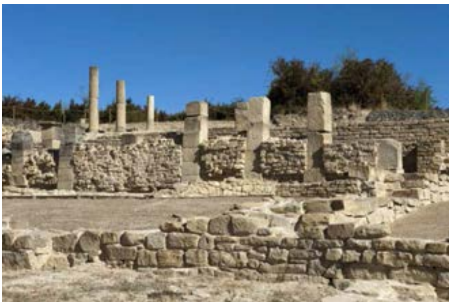
Fig. 492. Ciutat romana de Santa Cris. Detall de les columnes i dels murs amb grans carreus i en opus vittatum , que separen els diferents espais distribuïts en pendent
