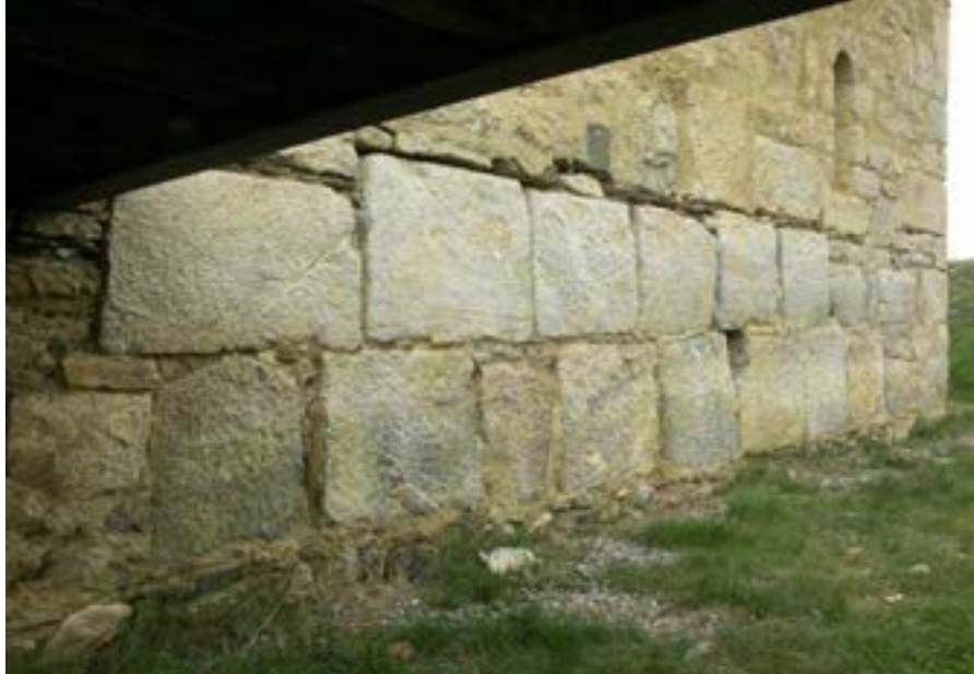
Fig. 542. Nostra Senyora de Quadres (Isòvol). Es poden observar part dels grans carreus a la base de la façana meridional de l'edifici
