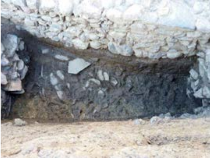
Fig 249. Temple. Procés de delimitació i excavació. Detall de la banquetta de fonamentació del mur lateral (ue 426) localitzada al fons de la rasa, amb el fons recobert de lloses planes. Als dos extrems de la imatge es poden apreciar els talls soferts pel mur, i a dalt la presència del mur fet en època moderna. Any 2016
