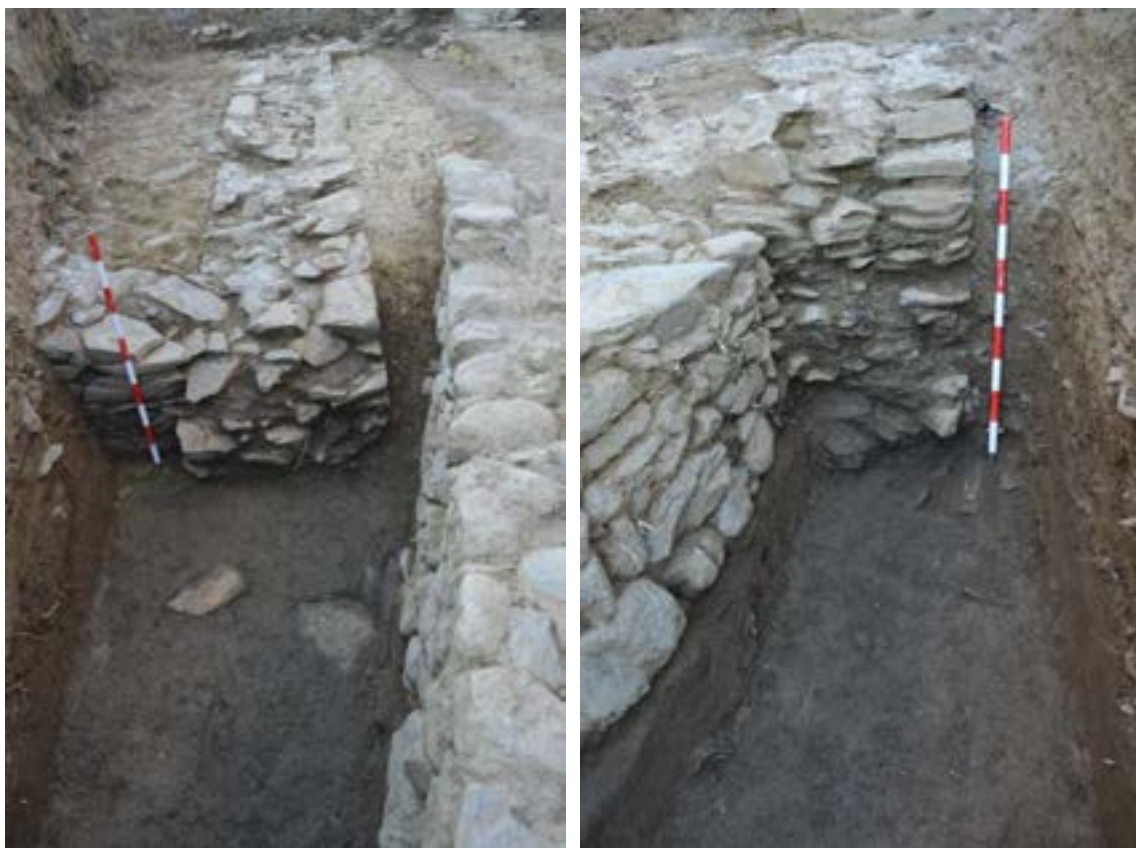
Figs. 246-248. Temple. Procés de delimitació i excavació. Diverses imatges corresponents als efectes provocats per la rasa efectuada en època moderna sobre el mur lateral dret de l'edifici del temple. A dalt, cantonada que forma la paret lateral amb el mur 9. A baix a l'esquerra, trencament produït a la part on lliga amb el mur 9. A baix a la dreta, trencament produït a la part septentrional de la rasa, on el mur lateral es conserva a major alçada (més de 1 m). També es pot observar, a les tres imatges, part del parament del mur fet en època moderna i amb posterioritat a la rasa (ue 415). Any 2016
