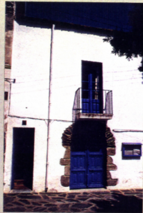
2. VISTA DEL AYUNTAMIENTO
