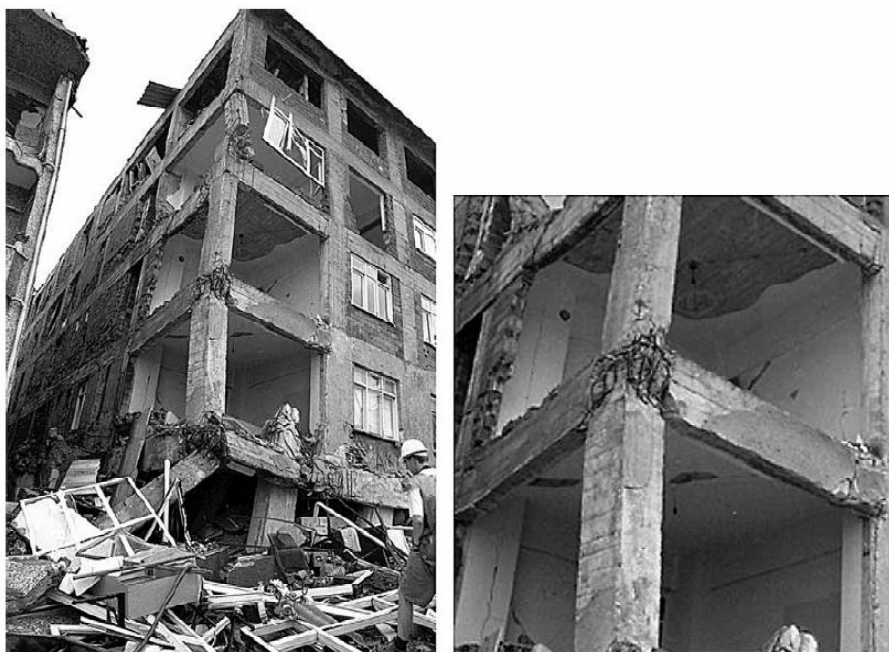
Figura 5.35. Daños producidos en edificios por el comportamiento no dúctil de las vigas de hormigón armado - Sismo de Turquía, 17 de Agosto de 1999 (Sezen et al., 2003).
