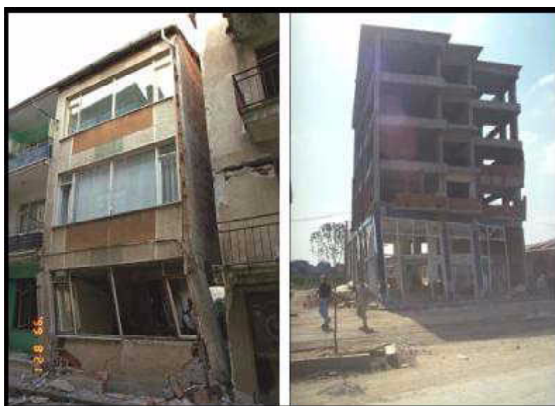
Figura 5.32. Daños producidos por las derivas excesivas en la planta baja de dos edificios aporticados de hormigón armado - Sismo de Izmit, Turquía, 17 de Agosto de 1999 ( http://nisee.berkeley.edu ).
