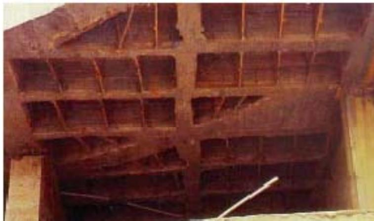
**Figura 8.4.** Detalle del sistema de aligeramiento con casetones de guadua utilizado para los forjados de los edificios de HA.
