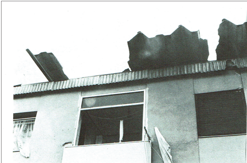
Figura 5: Imagen de los desperfectos en los pisos originales de San Cosme. Fuente: (Gracia & Clarés, 1987)
