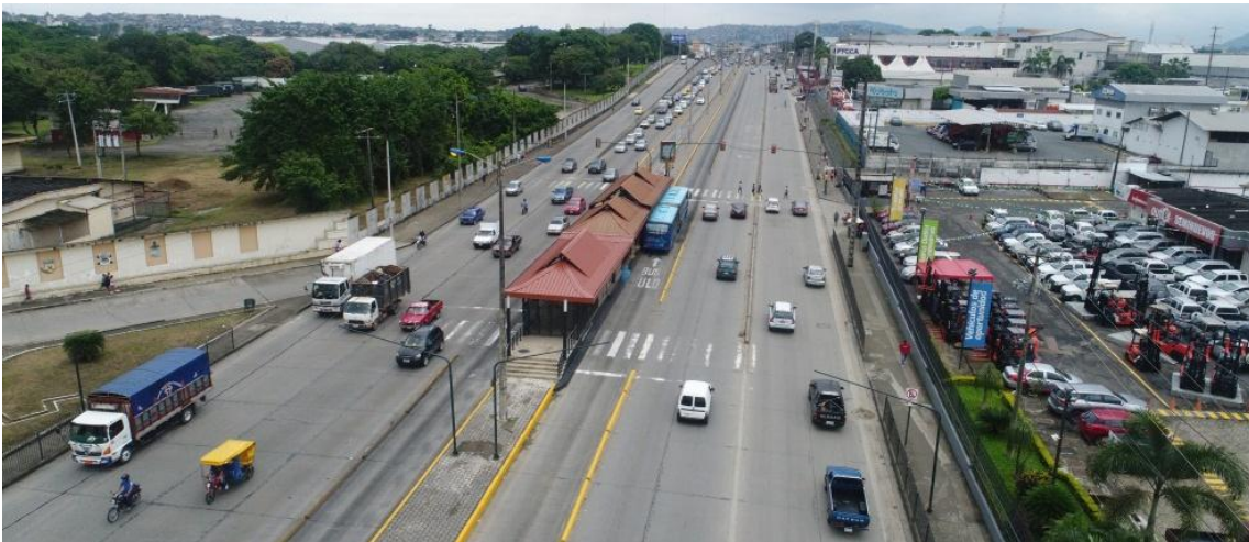
Imagen 129. Vista de la parte posterior de la parada Fuerte Huancavilca. Fuente: Naranjo, 2018
