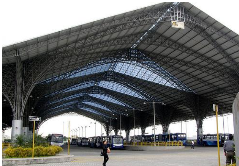
Imagen 53. Estación de integración, Río Daule. Fuente: (Skyscrapercity, Infraestructura y medios de transporte)
