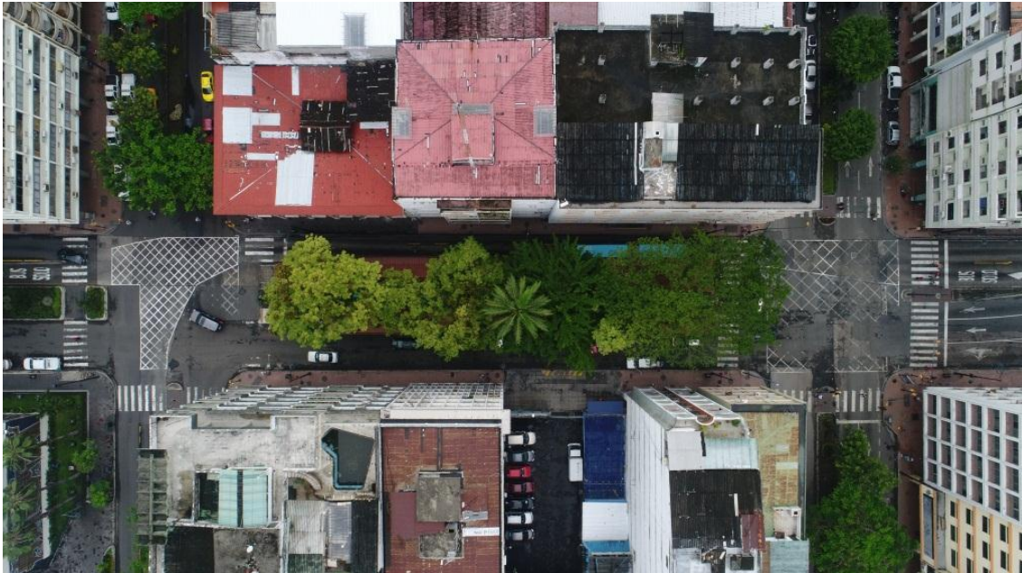
Imagen 141. Vista posterior de la parada Biblioteca Municipal. Fuente: Naranjo, 2018
