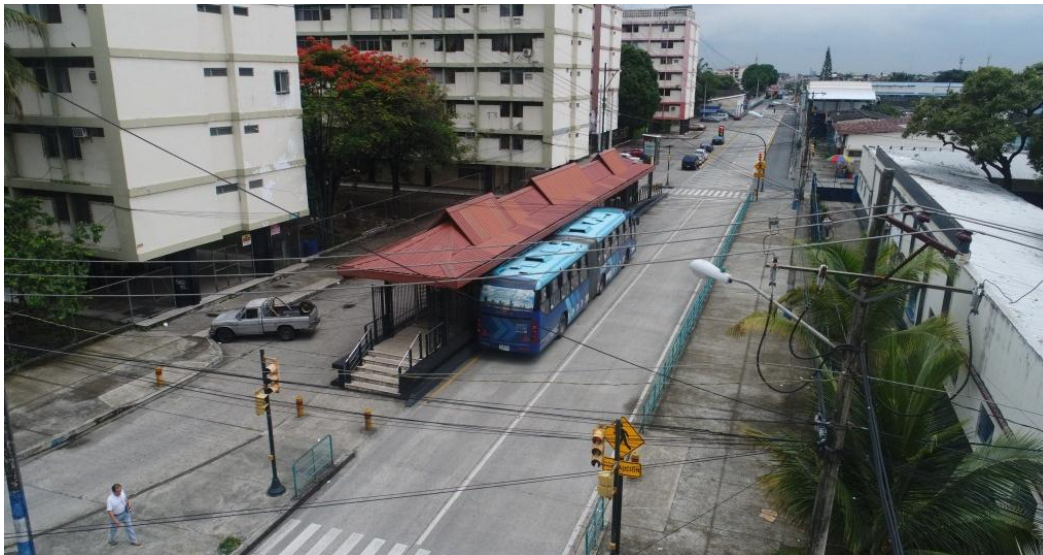
Imagen 108. Vista del ingreso de la parada Bloque del Seguro Sur . Fuente: Naranjo, 2018
