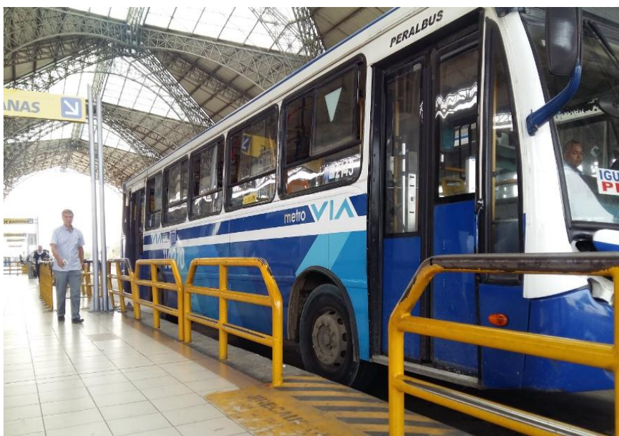
Imagen 195. Estado de las terminales piso, señalización y elementos de protección.
