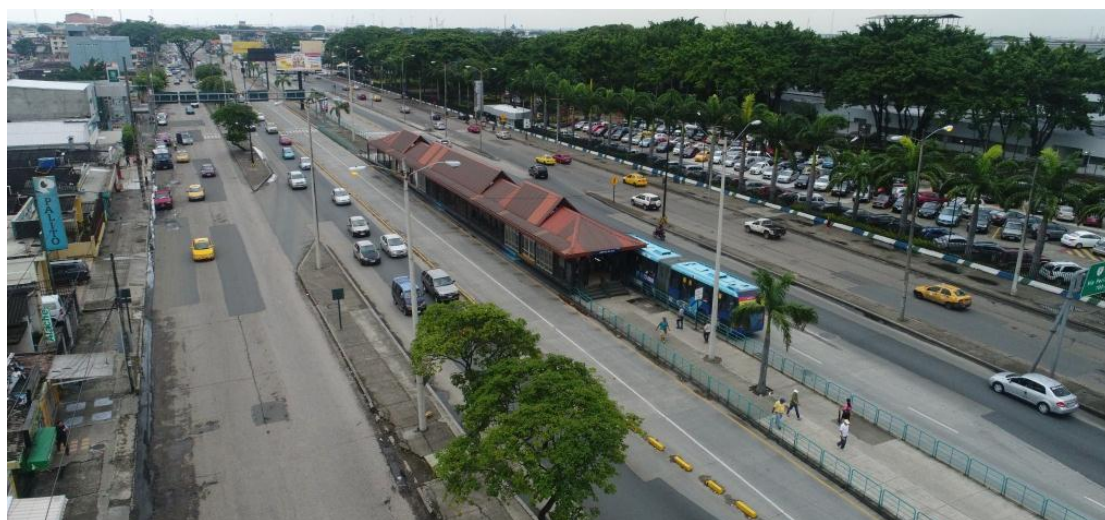
Imagen 116. Vista del acceso por rampa no utilizada (arriba) y vista del acceso habilitado, con escaleras de la parada Hospital del IESS (abajo). Fuente: Naranjo, 2018
