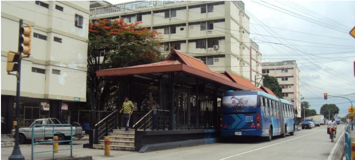
Imagen 49. Parada tipo caseta, calle Machala, 2018. Fuente: Naranjo, 2018
