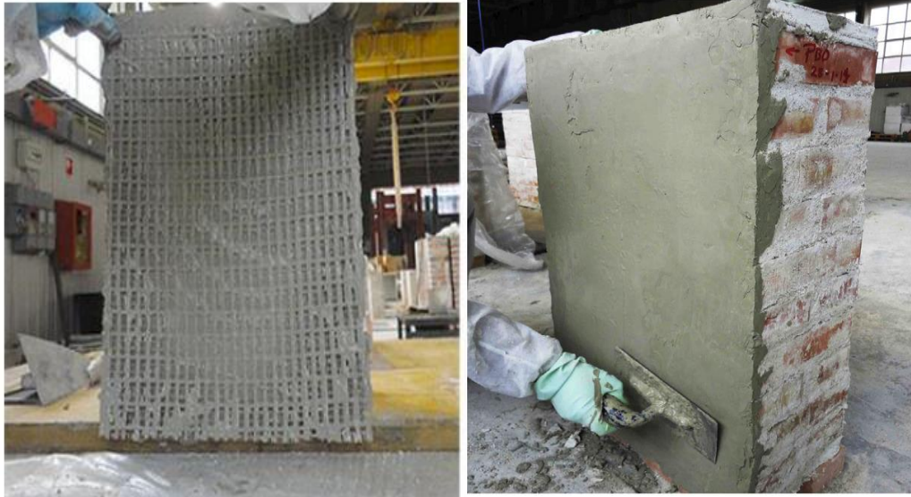
Figura 2.7. Colocación del FRCM [11]
