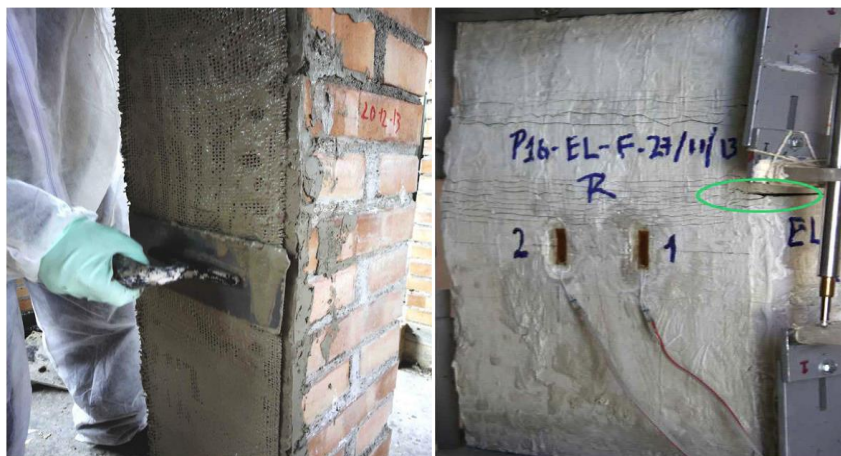
Figura 2. 10. Muros reforzados con FRCM de lino y PBO, sometidos a ensayos de carga excéntricas [12]
