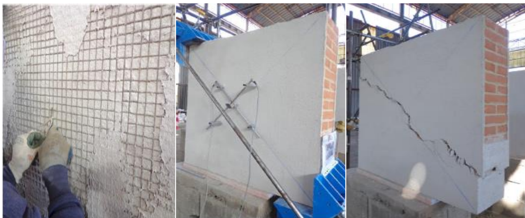
Figura 2.11. Muros de reforzados con FRCM de mallas de cáñamo impregnadas con resina, sometidos a ensayo de compresión diagonal [18]
