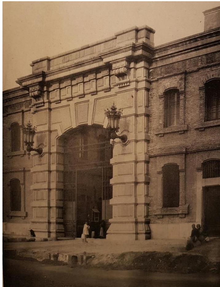
FIG. 11. Porta d'entrada de la fàbrica Rocamora. FCPR.
