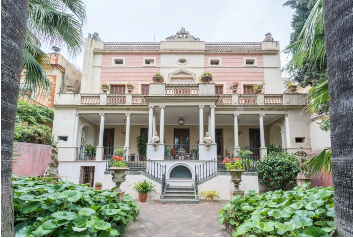
FIG. 26. Vista de la façana de la torre del carrer Ballester, 2017. Fotografia Adriana Domínguez Mata.
