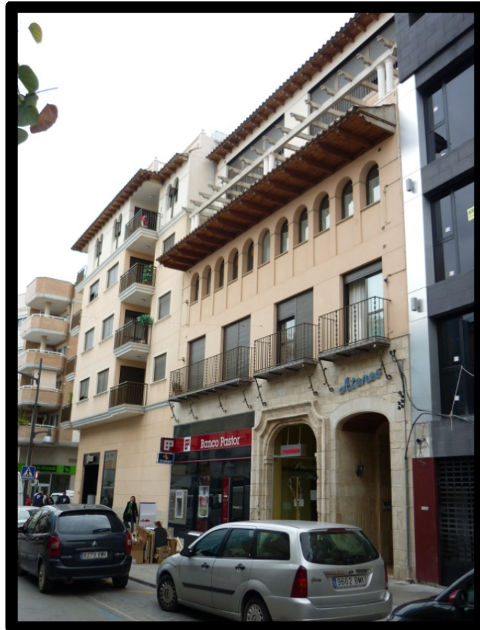
Imagen 1: Fachada del Teatro Ateneo de Vinaròs en la actualidad.
