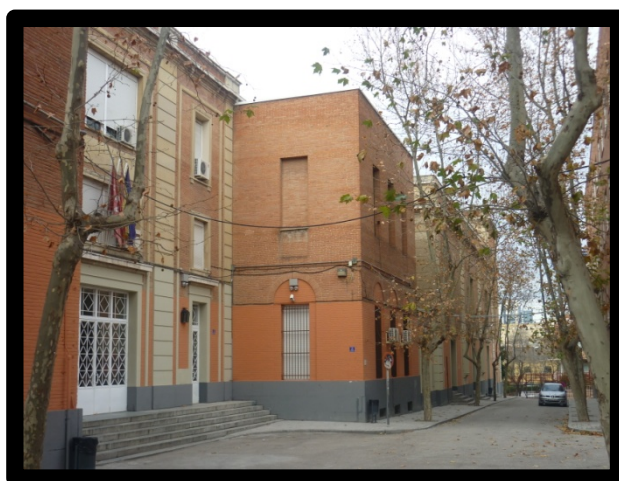
Imágenes 62: Puerta principal y vista del complejo.
