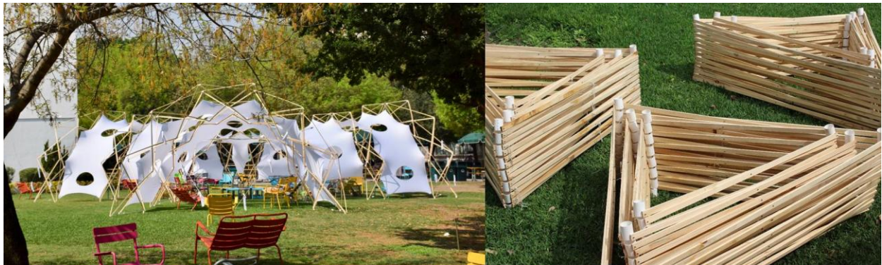
Fig 259. Pabellón Vertex. Prototipo desplegado en estado de uso. Prototipo cerrado en estado de Transportabilidad. Tecnológico de Monterrey, México 2018.
