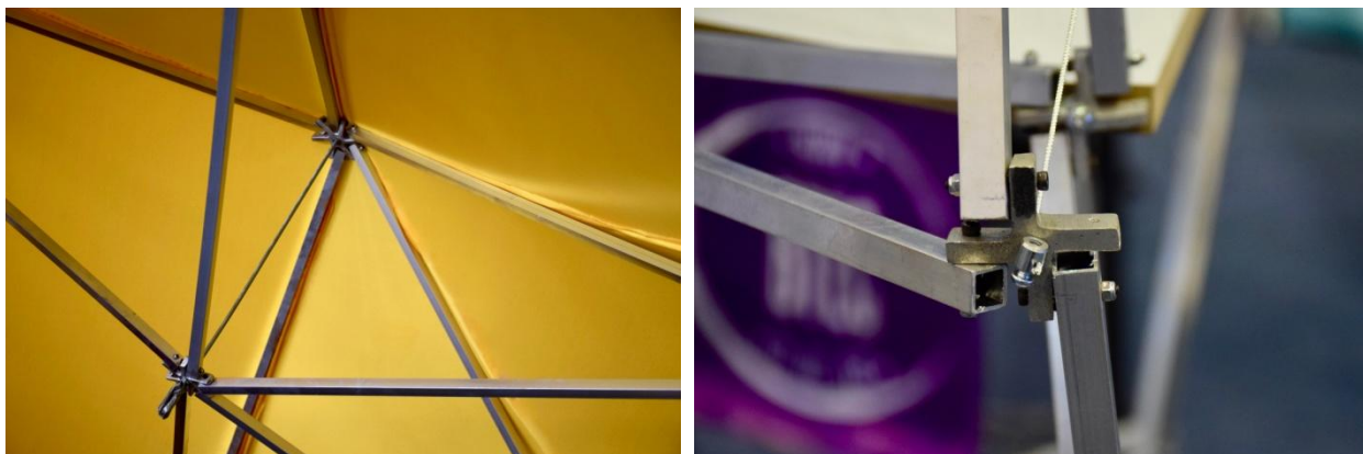
Fig 274. Elementos de control de movimiento límite para las EDBRA. Monterrey, México. Octubre 2018. DINAMIKA - Sinergia Creativa.
