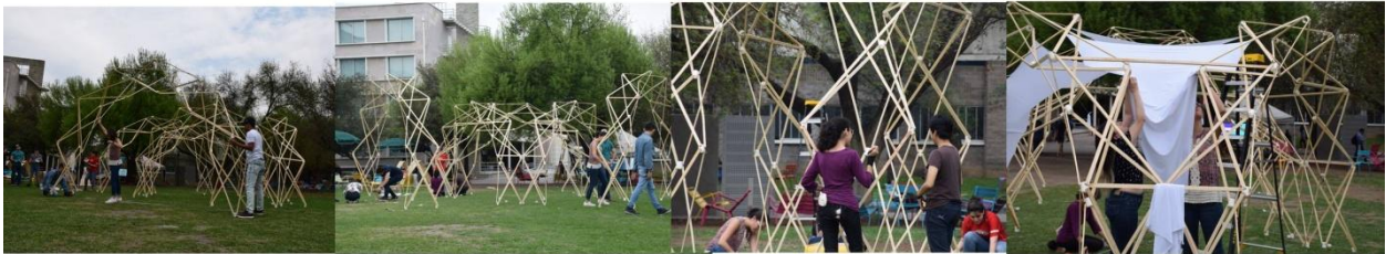
Fig 255. Pabellón Vertex. Proceso de montaje e instalación. Tecnológico de Monterrey, México 2018.
