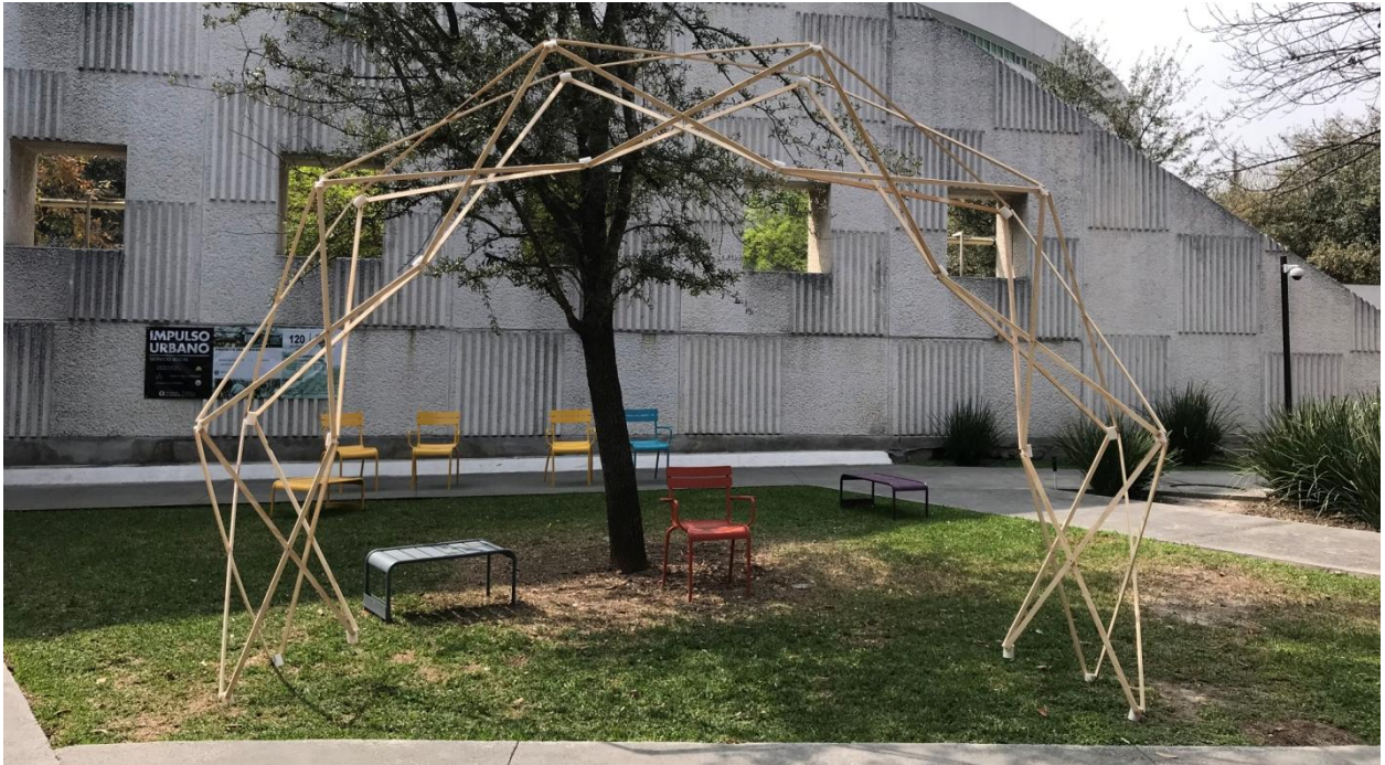
Fig 249. Arco desplegable con sección triangular. Prototipo.
