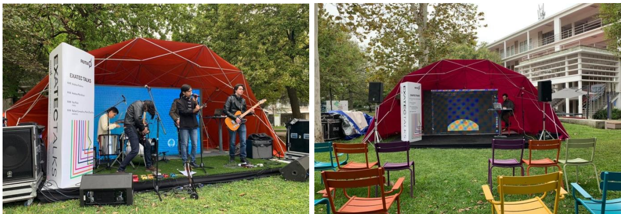
Fig 278. Medio domo desplegable con barras de aluminio y cubierta textil en lycra. Escenario de conciertos. Mayo 2019. Monterrey, México. DINAMIKA - Sinergia Creativa.
