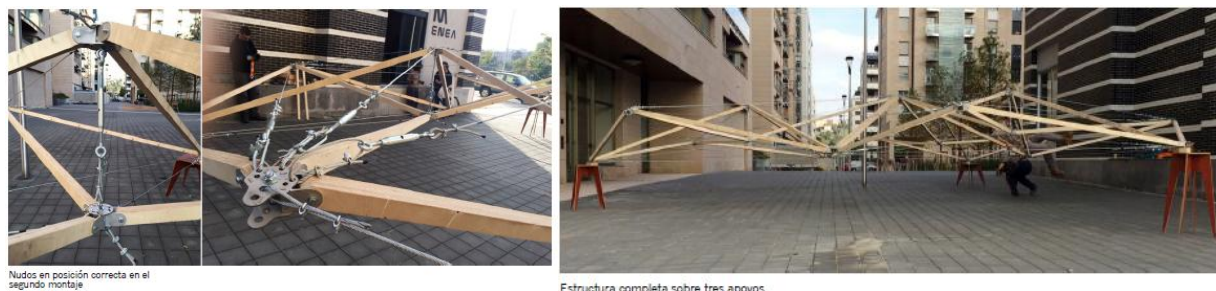
Fig 28. Detalles del prototipo de tres módulos hexagonales y nudos cruzados. Fuente: (Begiristain, 2015)
