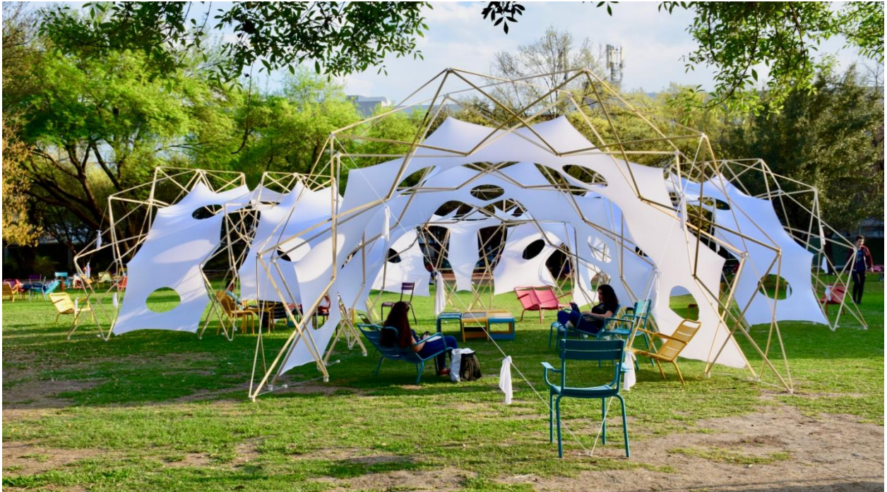
Fig 257. Pabellón Vertex. Instalación efímera de una estructura con arcos desplegables de 90 metros cuadrados construidos. Tecnológico de Monterrey, México 2018.
