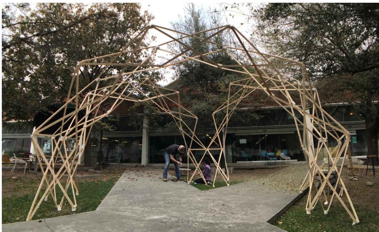
Fig 253. Pabellón Vertex. Primera prueba de montaje y comprobación del núcleo central. Tecnológico de Monterrey, México 2018.
