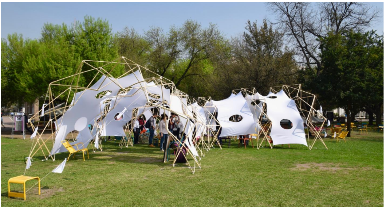
Fig 258. Pabellón Vertex. Instalación efímera de una estructura con arcos desplegables de 90 metros cuadrados construidos. Tecnológico de Monterrey, México 2018.
