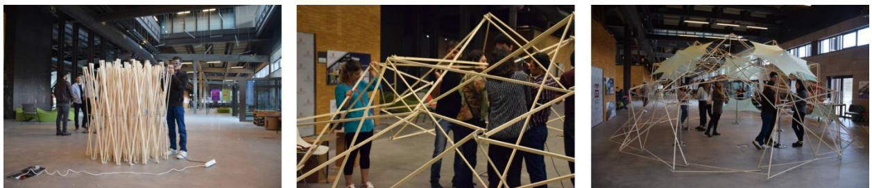
Fig 211. Domo desplegable D30. Proceso de montaje.
