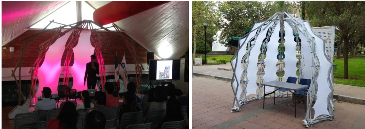
Fig 32. (a) Prototipo con barras en tubos de cartón y suelo en madera. (b) Prototipo con barras de aluminio. Fuente: www.smia-experimental.com
