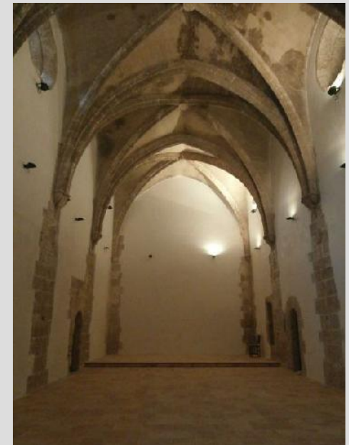
Fig 1.8 Interior iglesia San Martín, Cartuja de Vall de Cristo, una vez restaurada
