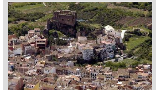
Fig. 1.65 Vista aérea del Castillo (Fuente Ayuntamiento de Castellново)
