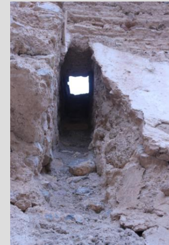
Fig.6.59. Conducto de salida de humos del la chimenea francesa descrita en sala principal
