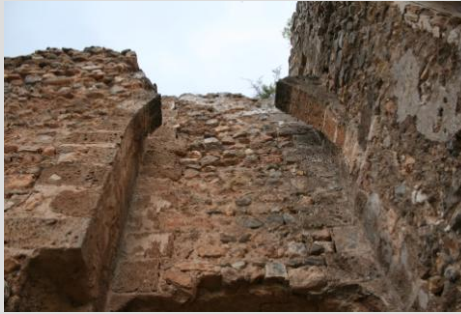
Fig.6.23. Entrada del Castillo de Castellnovo, buhedera entre arco y lienzo
