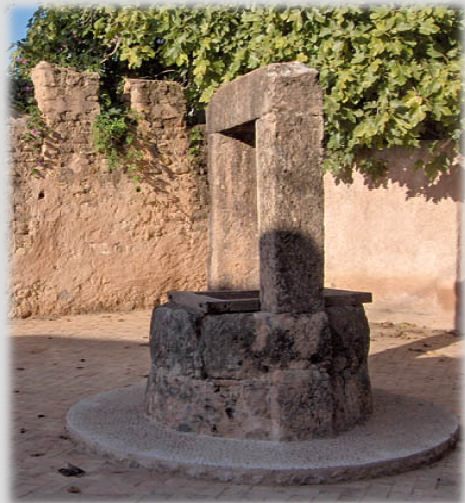
Fig. 2.48. Pozo de la Cisterna
