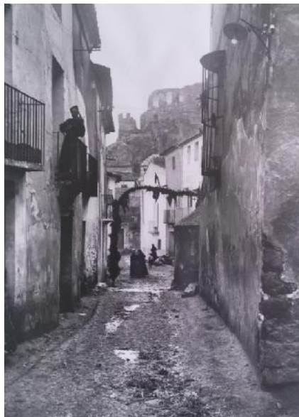
Fig. 3.28 Portal del Ravalet. Ayuntamiento de Castellnovo.
