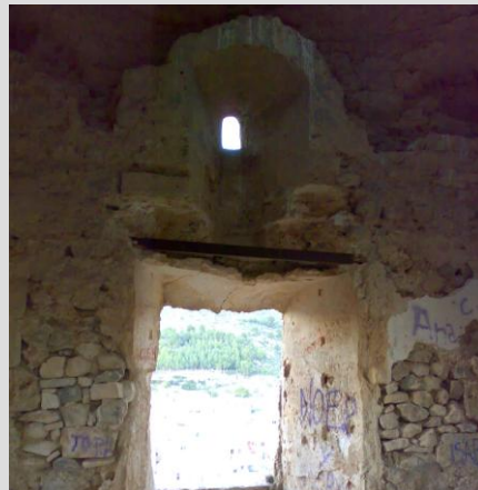
Fig.6.35. Restos de la aspillera de la sala de la Glorieta
