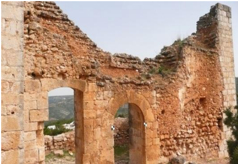
Fig 4.11 Detalle de arcos y huecos recercados con sillería del siglo XV en el castillo de Chirel Autor: López, 2015:195, http://dx.doi.org/10.4995/FORTMED2015.2015.1739
