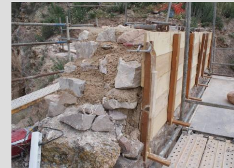
Fig.6.69. Ejemplo de encofrado realizado en la torre norte de Castellnovo, siguiendo la técnica del tapial
