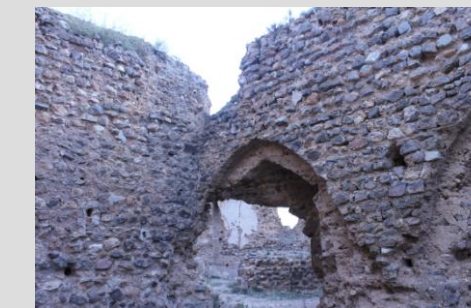
Fig.6.71. Hiladas en la sala de mujeres lienzos murarios que se añaden para cuadrar la sala
