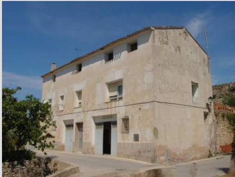
Fig. 2.28. 15-Molino del Titi (15B), titular actual: Jose Luis Piquer Sánchez, sito en la parcela 632, del polígono 11 de Castellnonovo. fachada principal.
