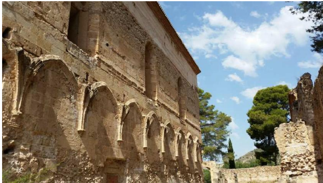
Fig. 4.16. Restos del paso porticado. Cartuja de Vall de Cristo
