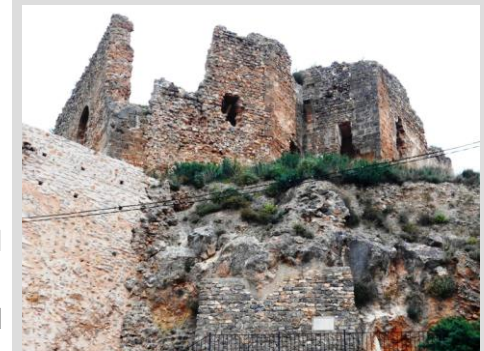
Fig.6.21. Fachada principal del Castillo de Castellnovo
