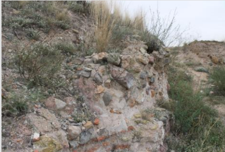
Fig.6.48. Entrada al castillo lienzo murario del lado izquierdo según se accede
