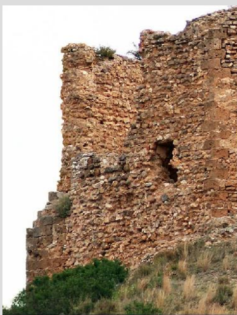
Fig. 1.30 Vista exterior de fachada 6
