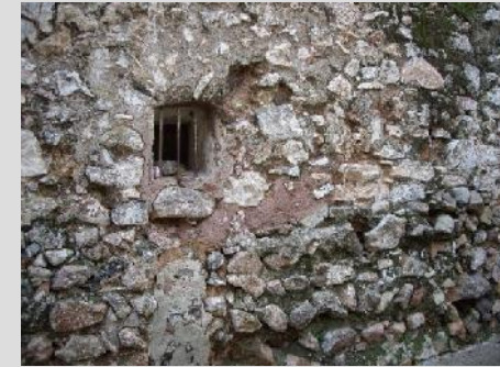
Fig. 3.29 Trazado murario zona 2. Casa muro.
