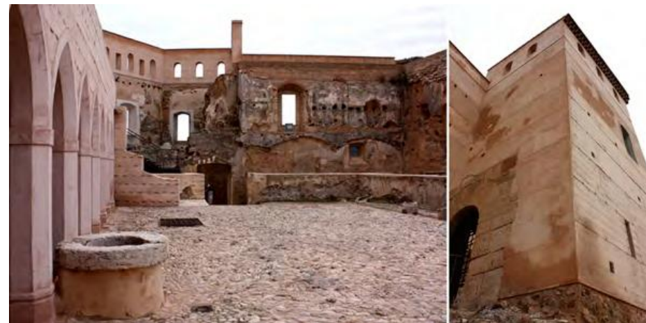
Fig 4.11 Patio interior y torre, Castillo de Cofrentes. Fotografías de la rehabilitación realizada por Salvador Vila, autor: Mestre Sabater.
