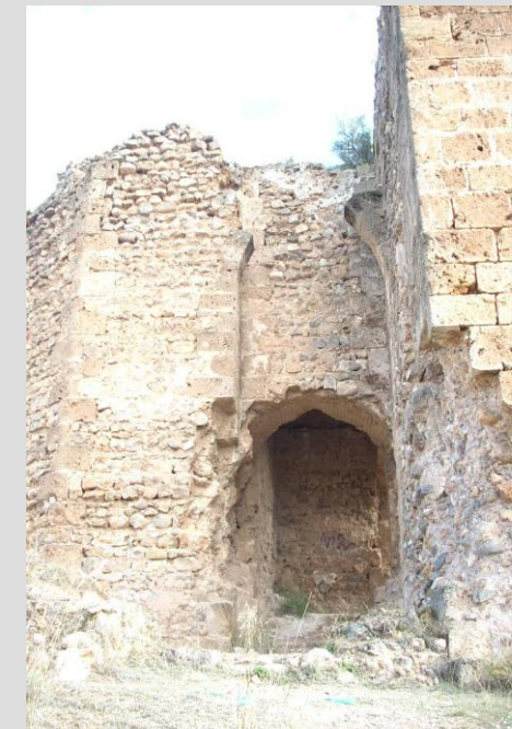
Fig.6.22. Fachada principal del Castillo de Castellnovo, pendiente de acceso
