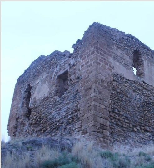
Fig. 6.5. Característica en común sillares en esquina
