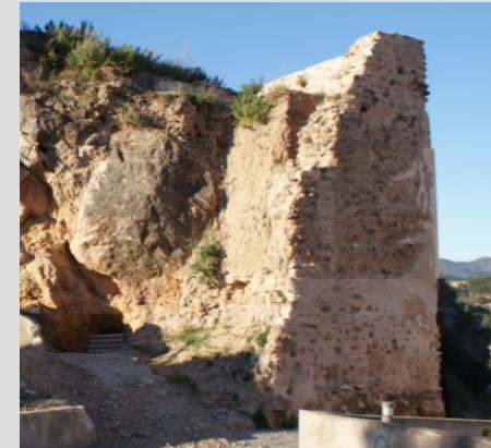
Fig.6.72. Torre norte lienzo pendiente de intervención
