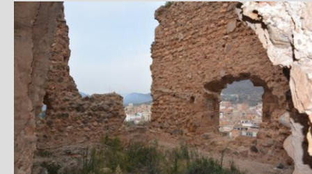
Fig.6.52. Sala de la cocina
