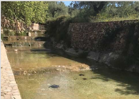
Fig. 2.37. Canalización del río Aurín junto al manantial de la Mina
