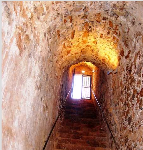
Fig. 2.43. Entrada a la Cisterna, escalera
