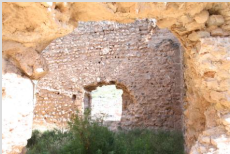
Fig.6.10. Ventana en zona de cocina
