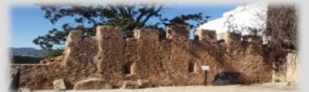
Fig. 3.35 Trazado murario zona de la cisterna
