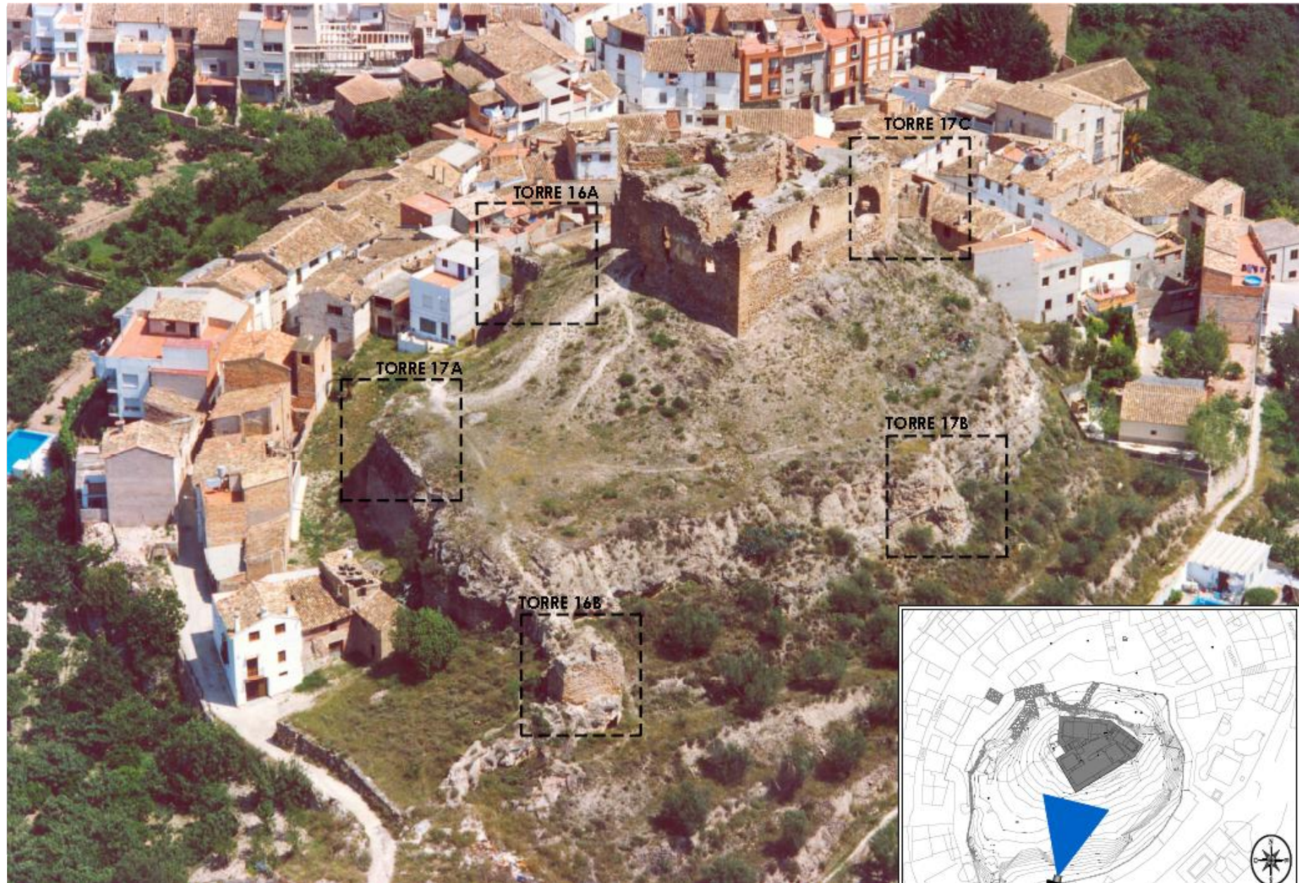
Fig. 3.13 Vista aérea del Castillo de Castellново con ubicación de sus torres.
