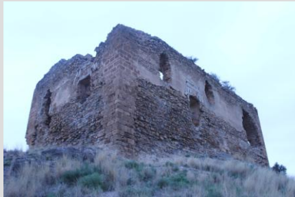
Fig.6.34. Fachada meridional y occidental, esquina sala principal
