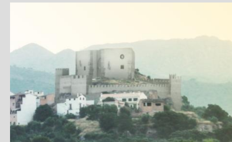
Fig.6.89. Reconstrucción fachada principal
