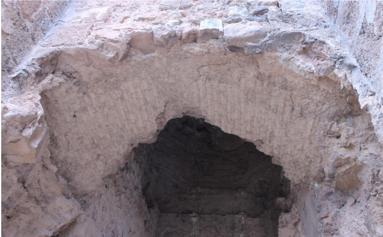
Fig.6.7. Perfil negativo del arco carpanel de la entrada y de la bóveda interior
