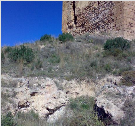
Fig.6.81. Restauración del aljibe exterior para evitar caídas de personas
