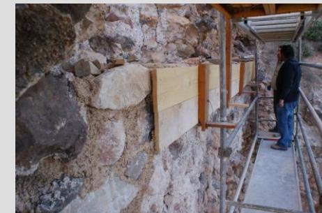
Fig.6.47. Encofrado de la torre norte para su restauración
