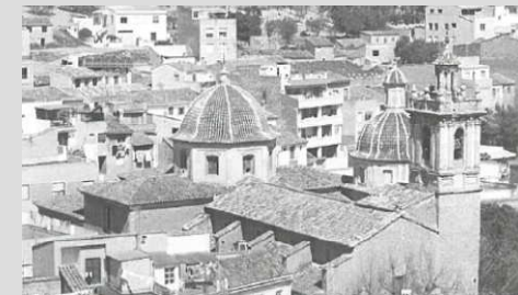
Fig. 2.22. Vista General del Tempo, torre de las campanas y cúpulas.
