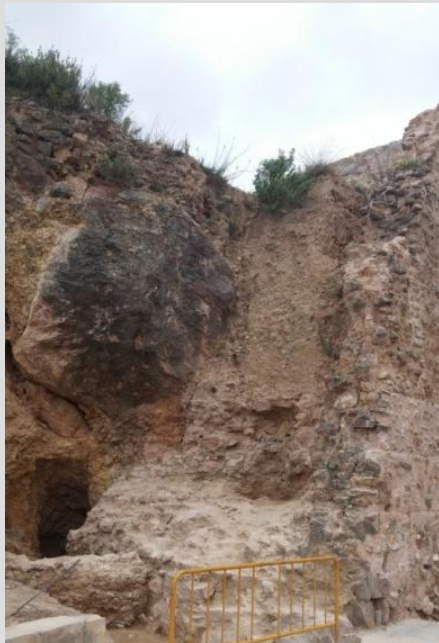
Fig.6.20. Lado sin realizar de la torre albarrana pendiente de realización, hueco de refugio de guerra a su parte izquierda
