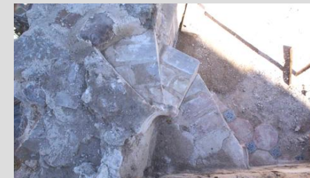
Fig.6.53. Escalera de acceso desde la cocina a las edificaciones auxiliares adosadas a estas
