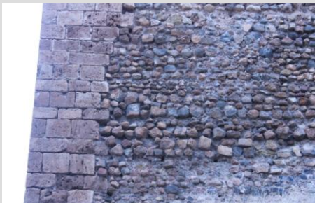
Fig.6.67. Refuerzo de piedra de sillaría labrada en esquinas
