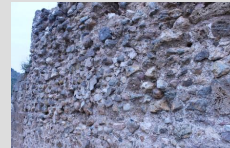
Fig.6.70. Hiladas en sala de mujeres y huecos realizado para los apeos de las bóvedas
