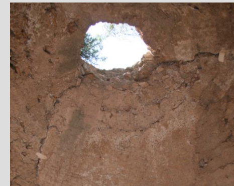
Fig.6.84. Restauración de cúpulas
