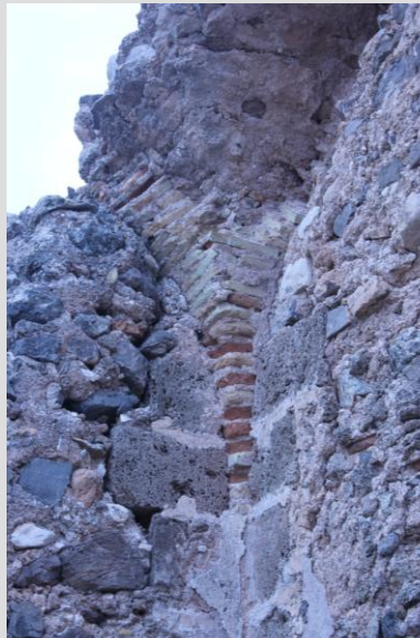
Fig.6.40. Arranque de la bóveda en la sala de mujeres
