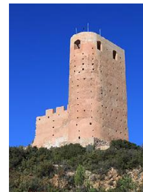
Fig.48 Castillo de Almonecir, Torre una vez restaurada (Autor: Santa Morro Rueda)
