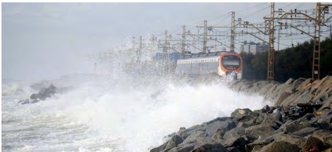
Figura 107. Impacte de les onades sobre la via del tren R1 Barcelona-Mataró.
