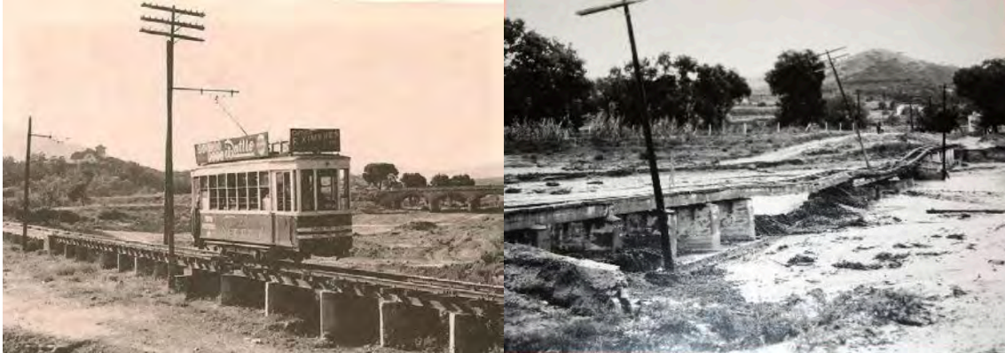
Figura 65. Imatges dels danys causats al tramvia de Mataró a Argentona al seu pas per la riera d'Argentona pel fort aiguat dels dies 9 i 10 d'octubre de 1965
