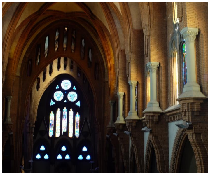
Columnetes on es recolzen els arcs parabòlics i vitralls del fons de la nau. Fotografia de l'autora (23-5-2019).
