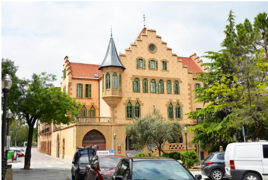
Vista general de l'hotel Sant Roc, a Solsona. Fotografia de l'autora (10-5-2019).
