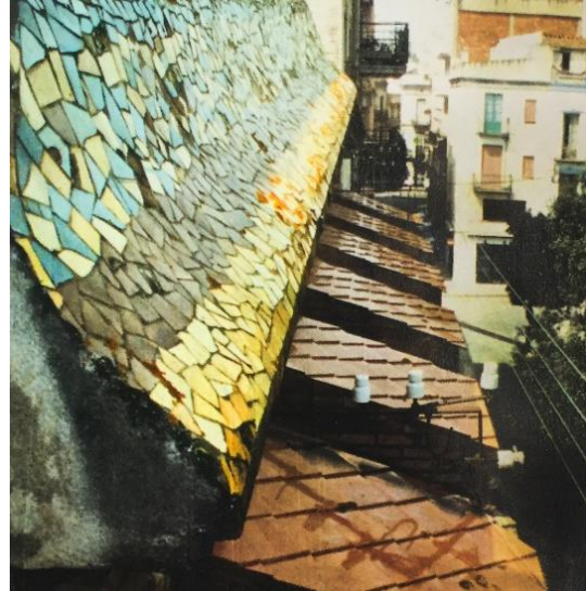
Detall del trencadís al coronament de la façana. Fons: AMSFG (251/1993).
