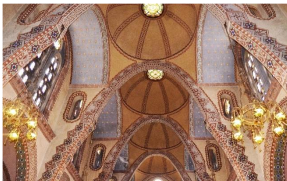
Vista general de les voltes. Fotografia de l'autora (9-6-2019).
