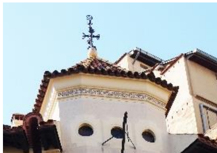
Detall de torre coronada per creu de quatre braços a la casa Pilar Serrahima. Fotografia de l'autora (26-10-2017).
