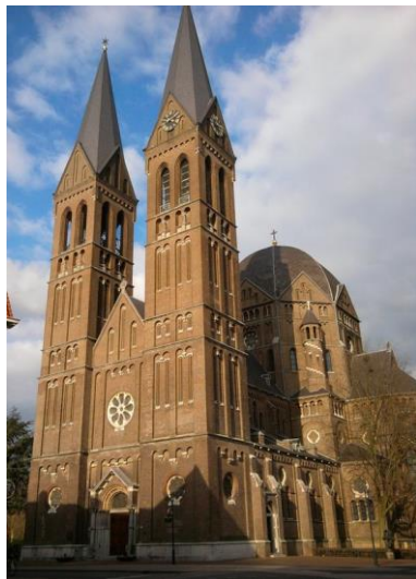
Església de Santa Brígida, Geldrop, Països Baixos. Extret de: http://rijksmonumenten.nl (consulta: 19-3-2018).
