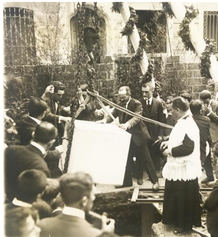
Benedicció de la primera pedra. 25-5-1924. Fons: APEPC. Crònica 1923-1940. (Es pot veure l'arquitecte darrere el senyor que toca la pedra).
