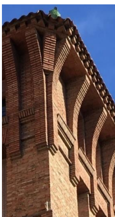
Detall del coronament de la façana de l'escola de les Teresianes de Tarragona. Fotografia de l'autora (23-1-2018).
