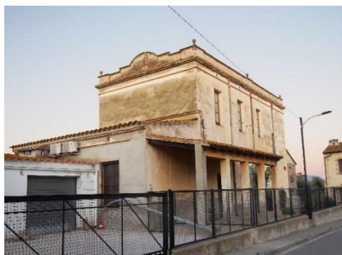
Façana lateral i porxo. Fotografia de l'autora (16-11-2017).
