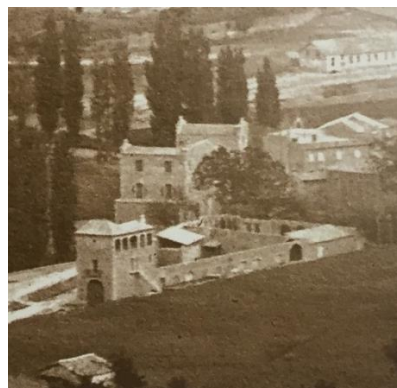
Imatge de tota l'illa de l'hotel Sant Roc en construcció, des de la part del darrere. Extret de: Tasies, J. op. cit. , p. 35.
