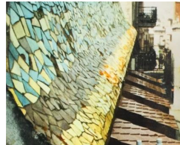
Detall del trencadís al coronament de la façana. Fons: AMSFG (251/1993).
