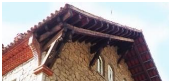
Part superior de la façana nord de la casa Maristany. Fotografia de l'autora (16-2-2020).
