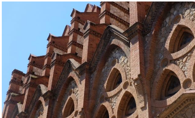
Façana lateral. Fotografia de l'autora (24-5-2019).
