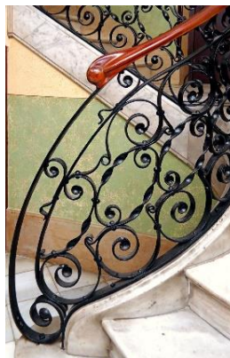
Detall de l'acabament de la barana.
