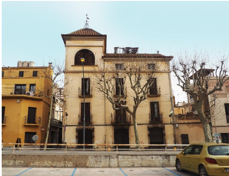
Façana de la casa des de la riera Bisbe Pol. Fotografia de l'autora (28-1-2020).
