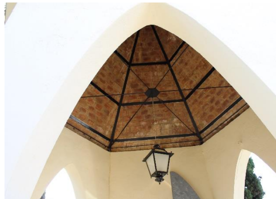
Interior de la coberta del porxo d'accés al cementiri. Fotografia de l'autora (17-10-2018).
