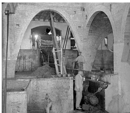
Vista interior del celler. Abans de 1937. Josep Vidal i Barraquer. Fons: AMCAM, arxiu família Vidal i Barraquer (J024-003E).
