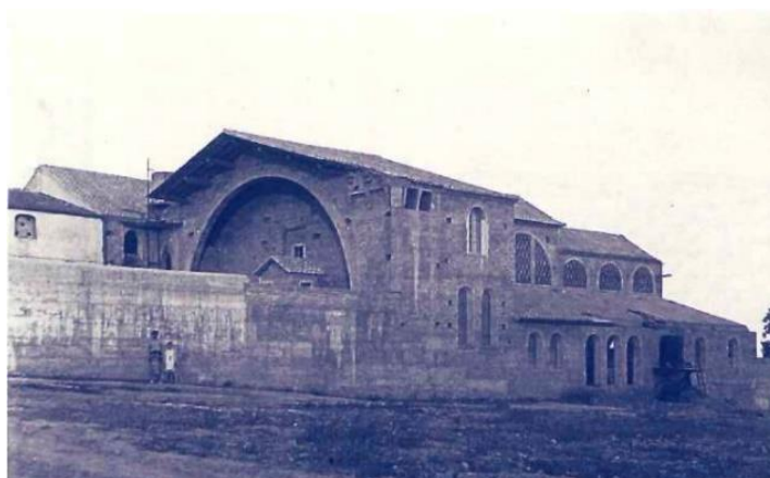
El celler en construcció. 1921. Extret de: Siuró, J.M. op. cit. , p. 31.
