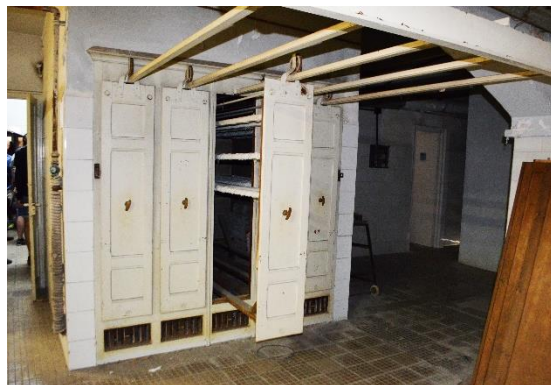
Armaris-assecadors d'aire calent, a la bugaderia. Fotografia de l'autora (9-6-2019).
