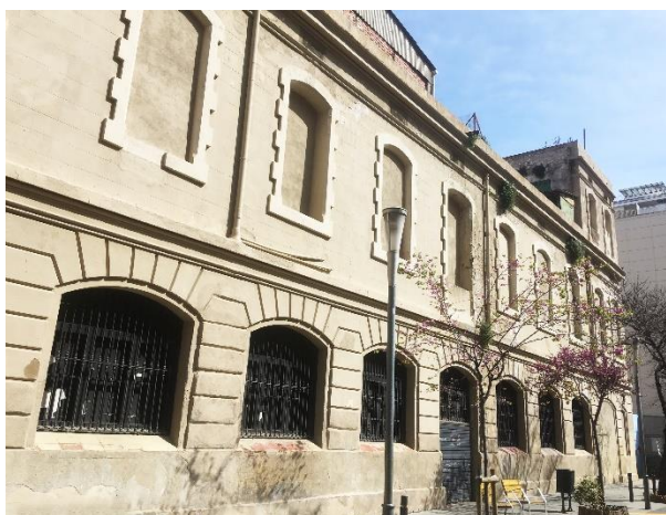
Façana des del passatge Pere Calders (als plànols passatge Parlament). Fotografia de l'autora (12-3-2020).
