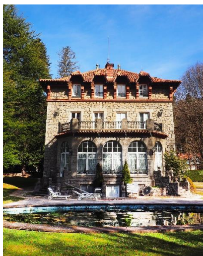
Façana sud. Fotografia de l'autora (16-2-2020).
