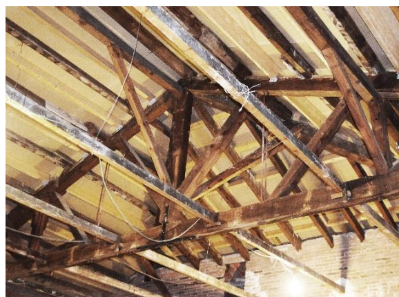
Estructura del sostre del saló d'actes. Fotografia de l'autora (9-6-2019).
