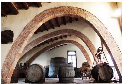
Arcs parabòlics d'una nau lateral del celler de la cooperativa agrícola, Cambrils. Fotografia de l'autora: 17-10-2018
