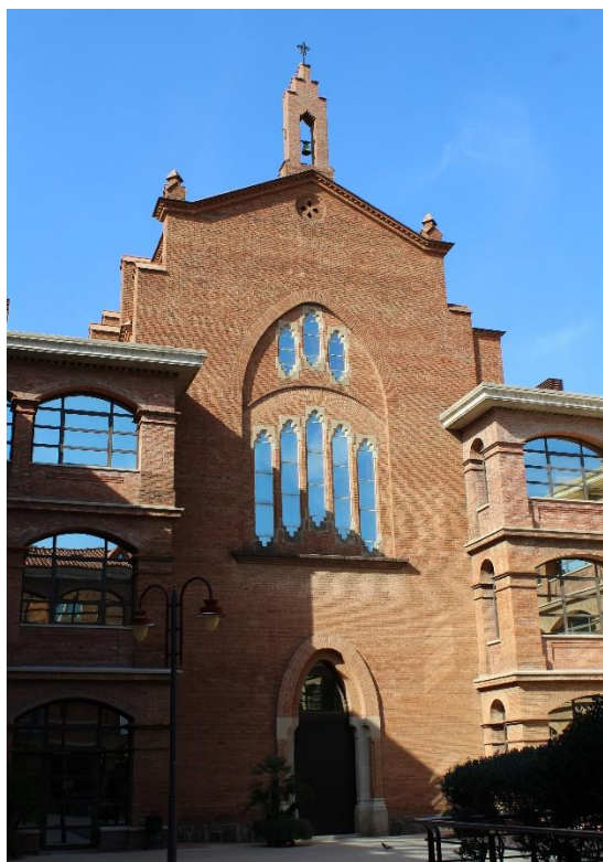
Façana. Fotografia de l'autora (15-3-2019).
