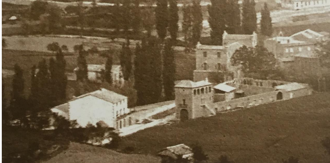
Imatge de tota l'illa de l'hotel Sant Roc en construcció, des de la part del darrere. Extret de: Tasies, J. op. cit. , p. 35.
