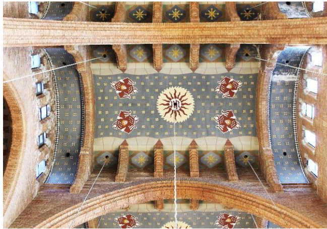
Voltes de la nau principal. Fotografia de l'autora (17-9-2019).
