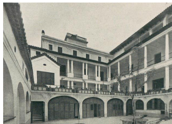
Pati interior de l'edifici. 1925. Extret de: Colonia social... (1925), op. cit.
