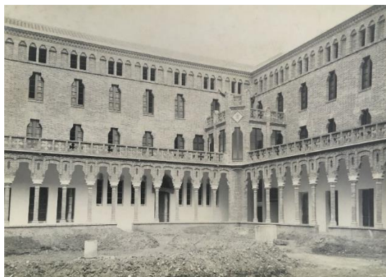
Vista del claustre durant les obres. Fons: Bernardí Martorell, ACG-ETSAB.
