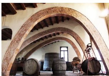
Arcs parabòlics d'una nau lateral del celler. Fotografia de l'autora: 17-10-2018
