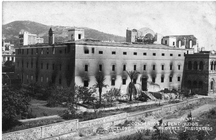
Vista de l'edifici dels claretians després de la Setmana Tràgica (es pot veure darrere l'edifici, a la dreta, una part de l'església, encara inacabada). 1909. Fons: APCM.
