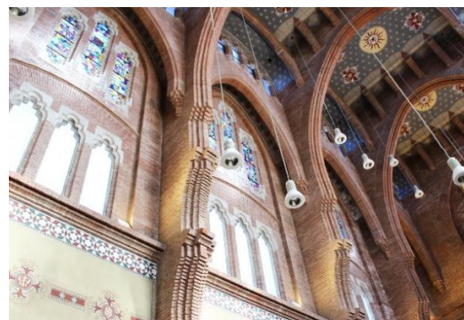
Visió dels murs laterals, separats en diferents trams per contraforts que acaben en arc parabòlic formant les voltes del sostre. Fotografia de l'autora (17-9-2019).
