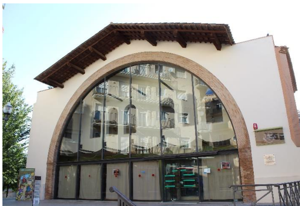
Façana principal del celler. Fotografia de l'autora (17-10-2019).
