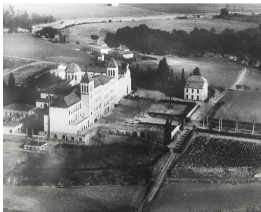
Vista aèria del conjunt. (s.d.). Fons: exposició al sanatori, visita 9-6-2019. (Es pot veure l'accés al sanatori, el xalet construït al davant i dues de les cases del fons).
