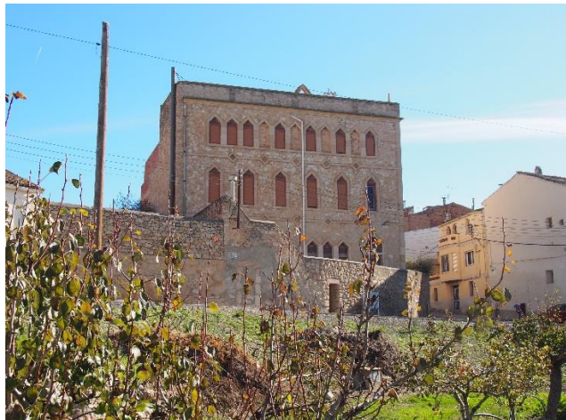
Vista de l'edifici: façana est (Fotografia: Mariola Borrell, 10-11-2017).
