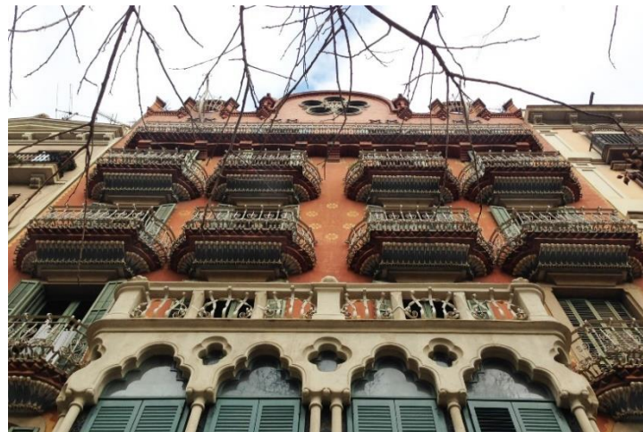
Vista de la façana des del carrer. Fotografia de l'autora (3-3-2017).
