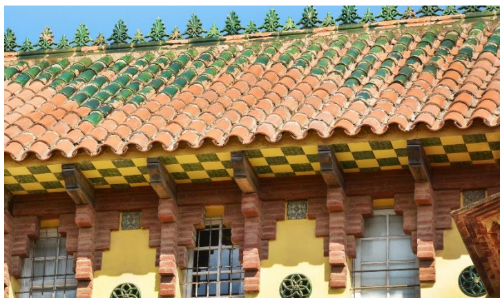
Detall de la coberta, el ràfec i les finestres superiors. Fotografia de l'autora (11-5-2018).
