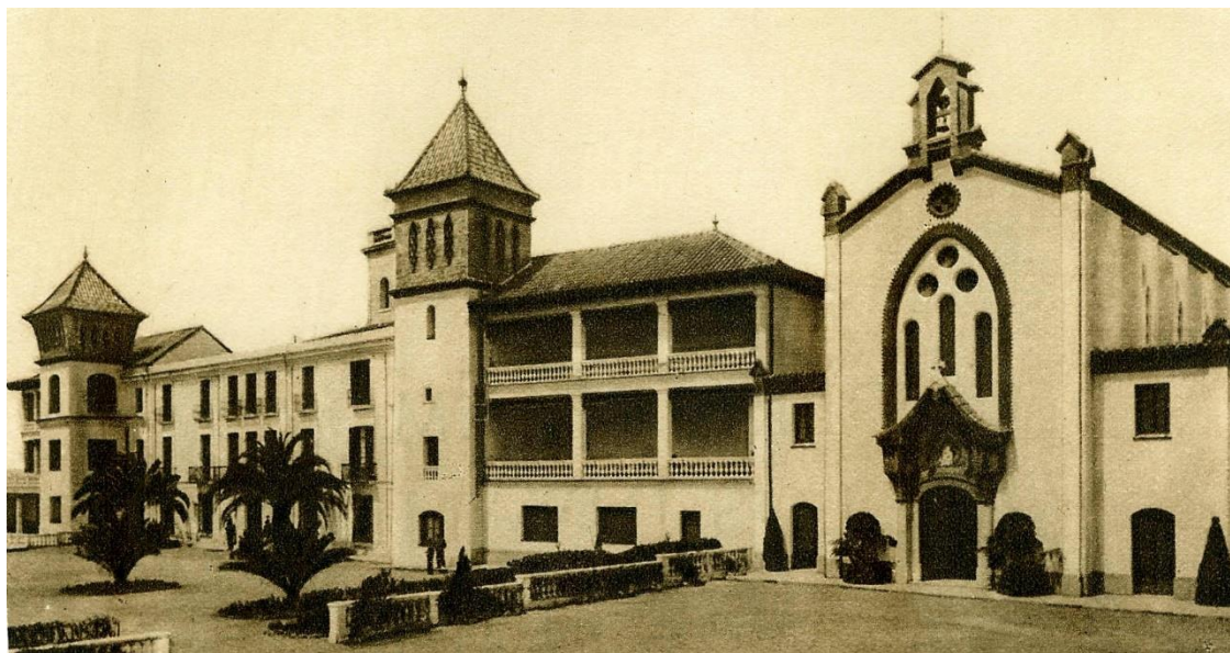
Façana principal del sanatori i l'església. (s.d.). Fons: Bernardí Martorell, ACG-ETSAB.
