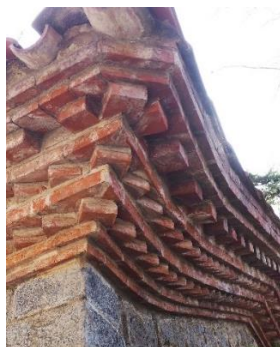
Detall de la cornisa de totxo de la portalada d'accés a la casa Maristany, Camprodon. Fotografia de l'autora (16-2-2020).
