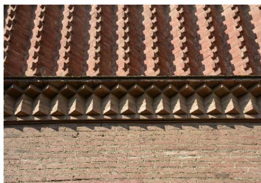
Mur del monestir de Valldonzella, amb combinacions variades de maó. Fotografia de l'autora (11-5-2018).
