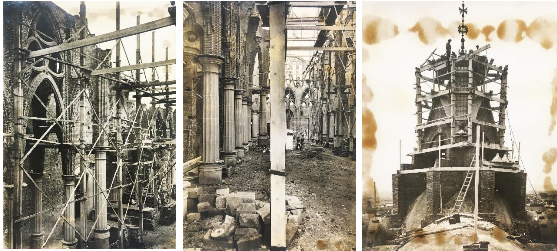
Imatges de diferents etapes de les obres: les bastides, la construcció de les voltes i la construcció del cimbori. Fons: APEPC. Crònica 1923-1940.
