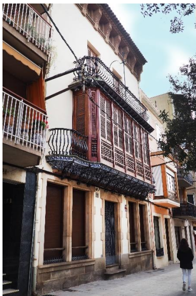
Vista general de can Montal. Fotografia de l'autora (28-1-20 20).
