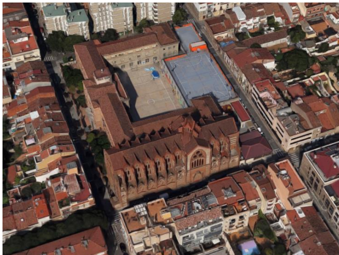
Visió aèria del conjunt de les Escoles Pies. Extret de: Google Earth (consulta: 10-5-2019).
