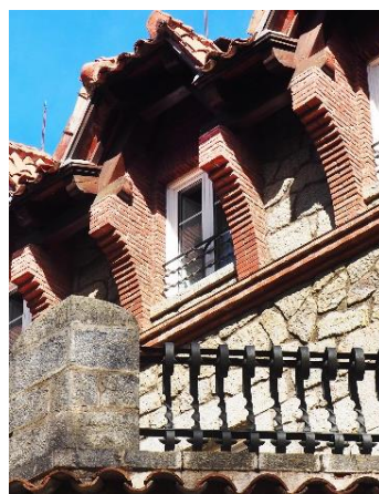
Detall de la part superior de la façana (finestres de les golfes) de la casa Maristany. Fotografia de l'autora (16-2-2020).
