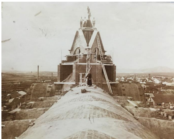
Les voltes de la coberta sense teulada. Fons: APEPC. Crònica 1923-1940.
