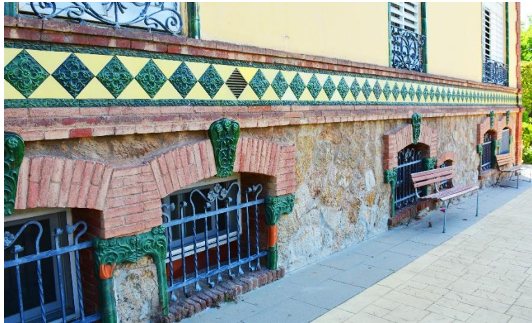
Detall del sòcol de l'edifici, amb finestres del soterrani i cornisa (11-5-2018).
