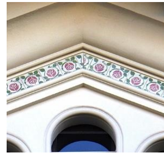
Detall de la peça ceràmica de la cornisa superior de la casa Pilar Serrahima. Fotografia de l'autora (26-10-2017).
