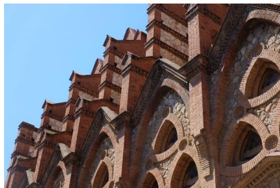
Façana lateral. Fotografia de l'autora (24-5-2019).
