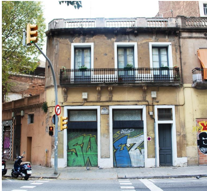
Façana de l'edifici actualment. L'obertura sobre la porta és part de la reforma. Fotografia de l'autora (3-12-2019).
