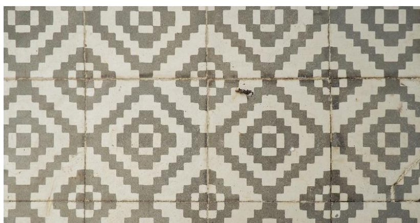
Paviment de l'habitatge de la botiga. Fotografia de l'autora (29-1-2020).
