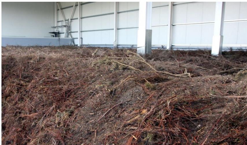
Figura 6. Detall del rebliment de bruc del Biofiltre
