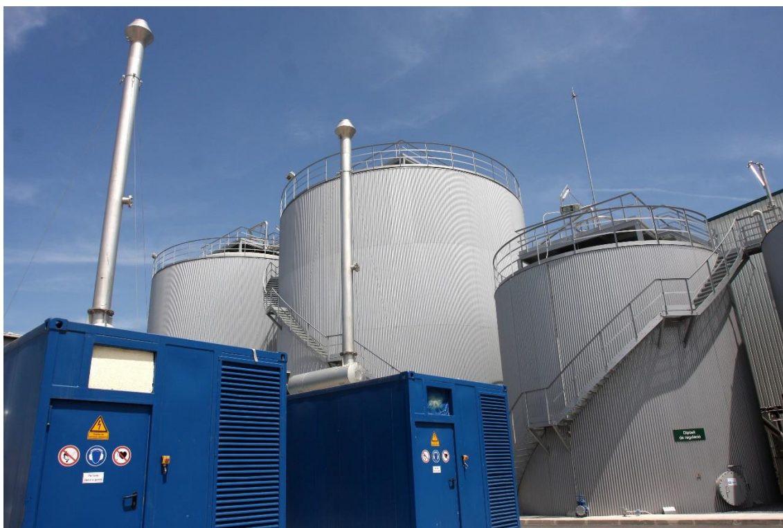
Figura 3. Àrea de biometanització: digestors anaeròbics i motors de cogeneració
