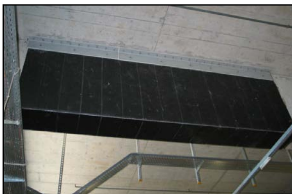
Figura 2.9: Ejemplo de aplicación del tejido de FRP (C-sheet) de la marca S&P® en estructura de hormigón armado.
