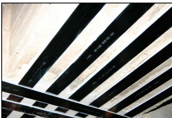
Figura 2.8: Ejemplo de aplicación del laminado de FRP (C-Laminate) de la marca S&P® en estructura de hormigón armado.
