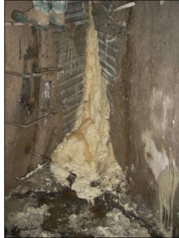
Figura 4.60. a) Preparación del tape de gunita en la zona del hastial b) Sellado del hastial izquierdo y preparación del tape (Pozo 5A)
