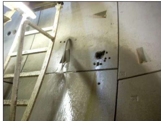
Figura 4.61. a) Infiltraciones en el hastial en el tape de gunita b) Entrada de agua en la tuneladora (Pozo 4A)
