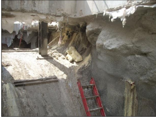
Figura 4.54. Inyecciones de espuma en el tape de salida del recinto estanco de la estación de Terminal Actual
