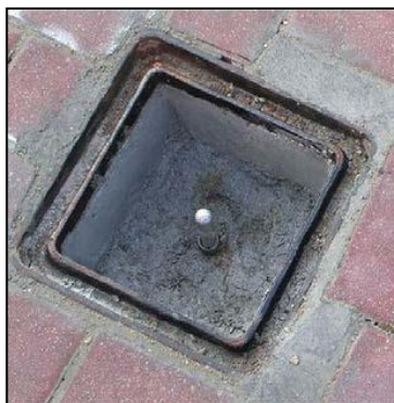
Figura 3.75. Cabeza de un hito de nivelación simple (HN)
