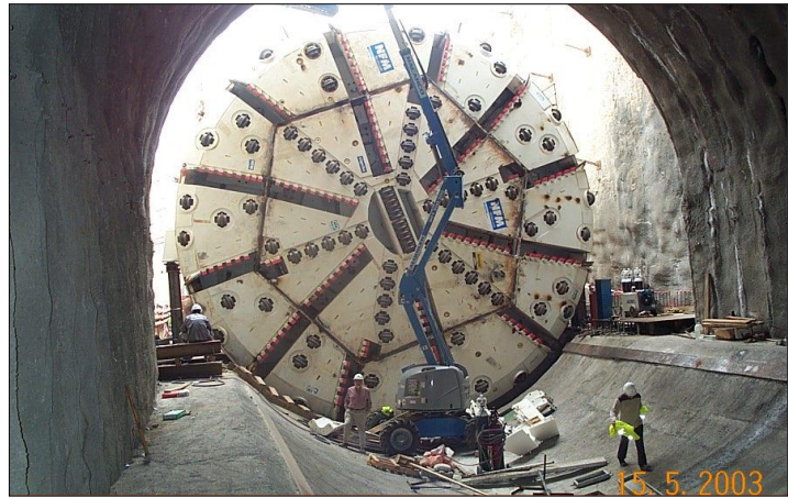
Figura 3.6. a) Sección del túnel de 12 metros de diámetro. Doble vía superpuesta en dos niveles en los tramos 2,3 y 4 b) Máquina TBM/EPB de 11.95 m de diámetro utilizada en el Tramo 4 entre las estaciones de Can Zam y el Río Besòs y parte del Tramo 3
