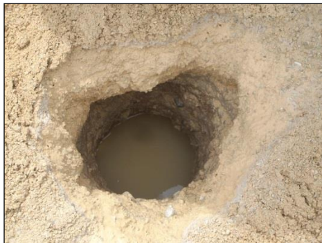
Figura 4.57. Vista del sondeo de comprobación del jet-grouting ejecutado para UTE Túnel Airport b) Sondeo de comprobación relleno y sellado con hormigón
