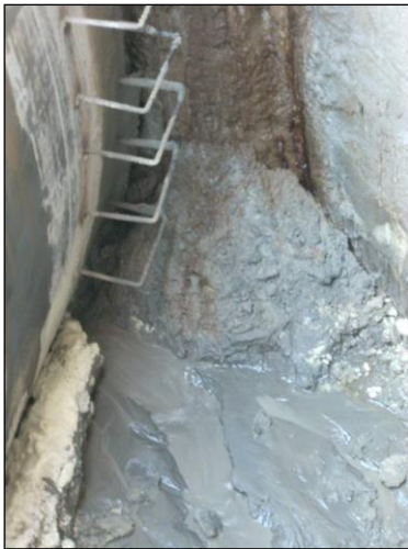
Figura 4.62. Entrada de agua por el tape de gunita b) Sellado del tape de gunita desde el interior de la dovelas
