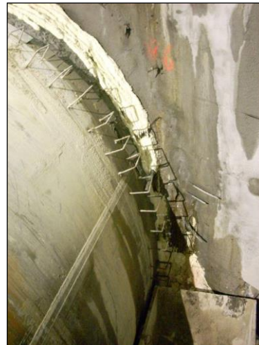
Figura 4.62. Entrada de agua por el tape de gunita b) Sellado del tape de gunita desde el interior de la dovelas
