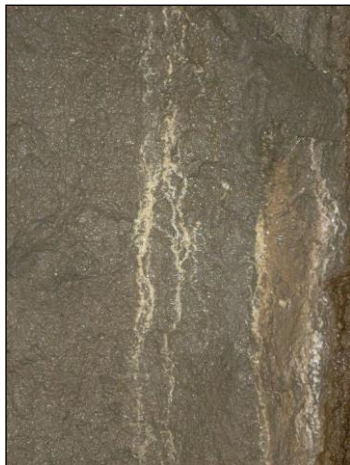
Figura 4.61. a) Infiltraciones en el hastial en el tape de gunita b) Entrada de agua en la tuneladora (Pozo 4A)
