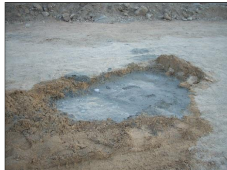
Figura 4.57. Vista del sondeo de comprobación del jet-grouting ejecutado para UTE Túnel Airport b) Sondeo de comprobación relleno y sellado con hormigón
