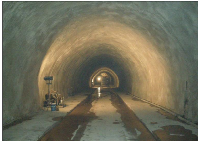
Figura 3.7. a) Sección del túnel en mina. Doble vía superpuesta en dos niveles en el Tramo 1 entre las estaciones de Europa/Fira y Pou Bifurcació b) Fotografía de la parte superior del túnel en mina realizado entre Europa/Fira y Pou Bifurcació
