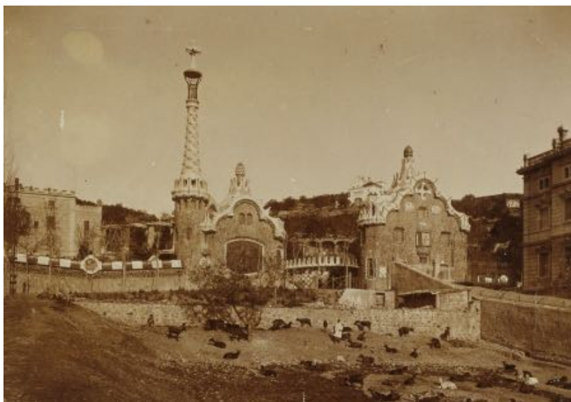
Imatge 1. El Park Güell i els seus entorns durant la seva construcció
