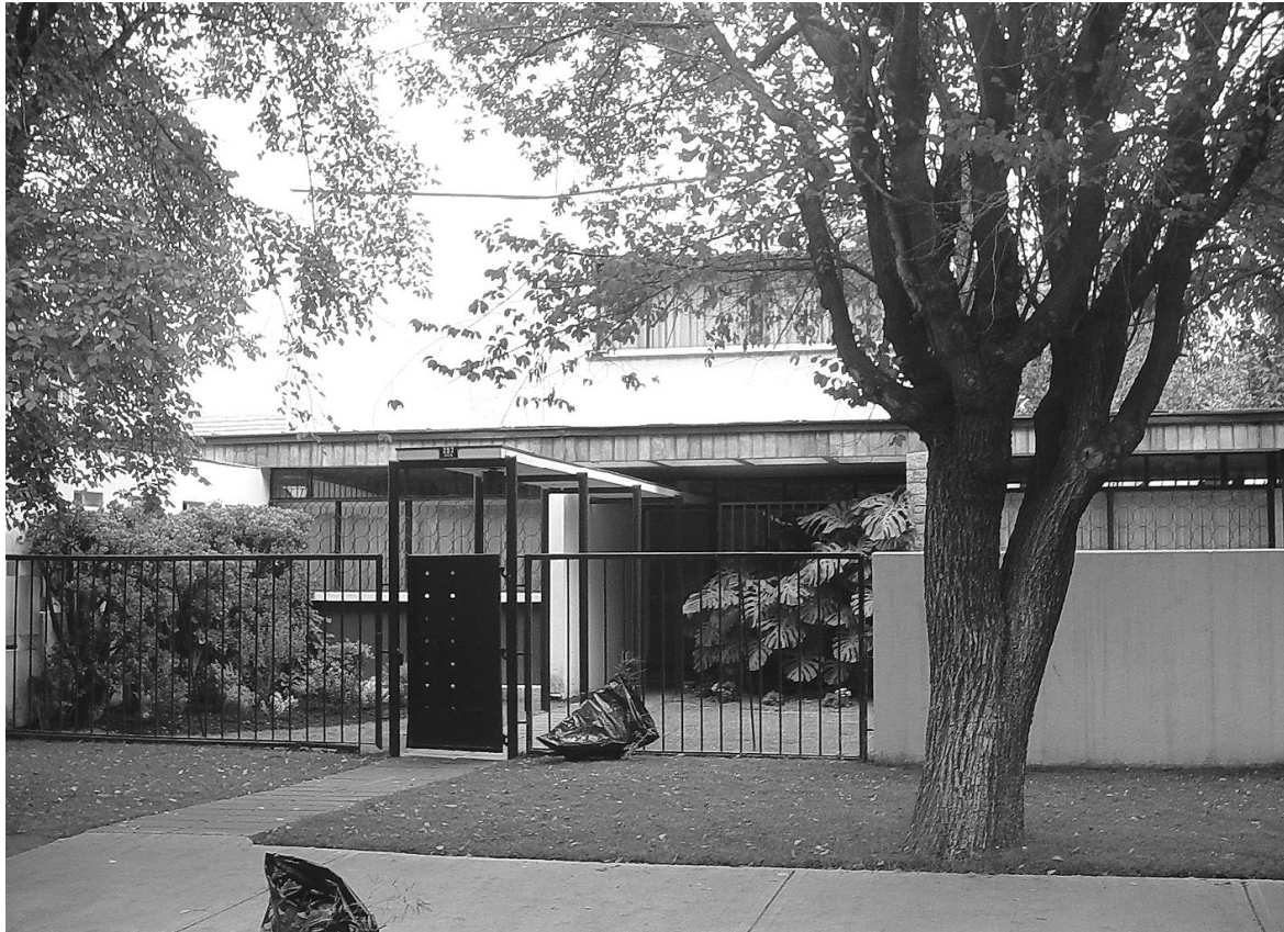
Casa Ravera. Cierro diferenciado según sectores de fachada y elementos constitutivos de la marquesina. Fotografía: Hugo Weibel Fernández.
