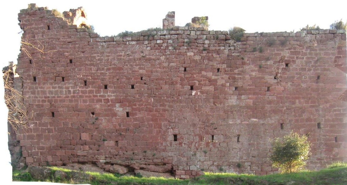
Figura 39. Façana nord. Foto Jordi Lozano.
