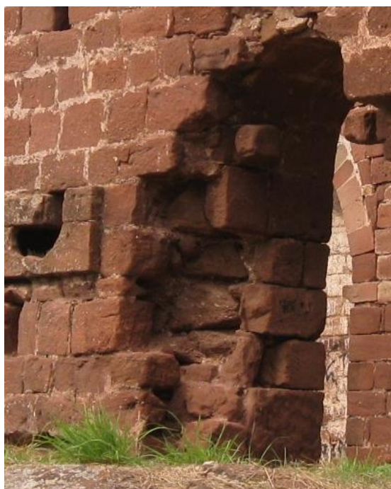
Figura 52 (Esquerra); figura 53 (dreta) Dues negatives ens mostren com és l'interior del mur a dues zones diferents. A l'esquerra, la UE23, amb els carreus seguint per tamany i filada l'estructura de la façana. A la dreta, la UE45, on les pedres no segueixen l'estructura de la façana ni en tamany ni en filada.
