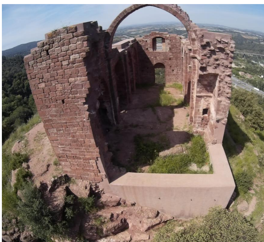
Figura 140. Imatge aèria de la zona de l'absis vista per l'exterior, obtinguda amb posterioritat a la intervenció.
