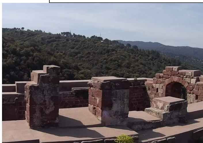
Figura 146. Vista aèria de la zona del campanar, la interpretació de la qual surt perjudicada per la intervenció realitzada. En aquest cas no es pot saber si la part inferior es corresponia amb una superfície, com correspondria al terra de l'ull de cada arc, o si es tractava realment d'una zona de pèrdua que calia reblir.
