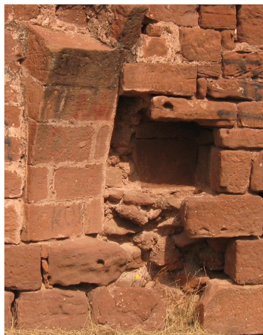
Figura 52 (Esquerra); figura 53 (dreta) Dues negatives ens mostren com és l'interior del mur a dues zones diferents. A l'esquerra, la UE23, amb els carreus seguint per tamany i filada l'estructura de la façana. A la dreta, la UE45, on les pedres no segueixen l'estructura de la façana ni en tamany ni en filada.
