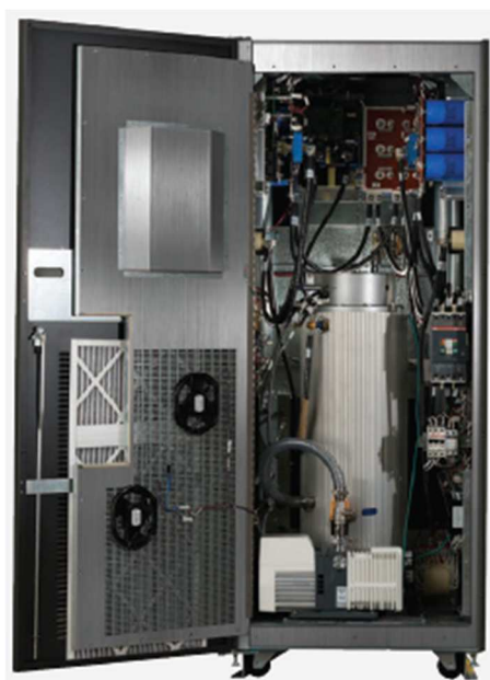
Fig. 8 Acumulador cinético de energía eléctrica, llaves en mano, en armario eléctrico std comercial, 300 kW, 400-520 V. Fuente: “Celenix-VYCON”
