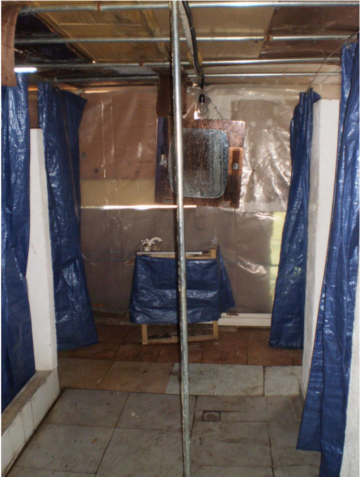
Los baños colectivos en "la granja". Caben resaltar las baldosas de distintos colores (porque recuperadas), el techo hecho de tablas y puertas de madera (con huecos por donde pasa la luz y la lluvia), el soporte del fregadero, también de madera, y las cortinas de ducha hechas de tela agrícola de plástico grueso. Alcanar, Tarragona, 04/05/2012.
