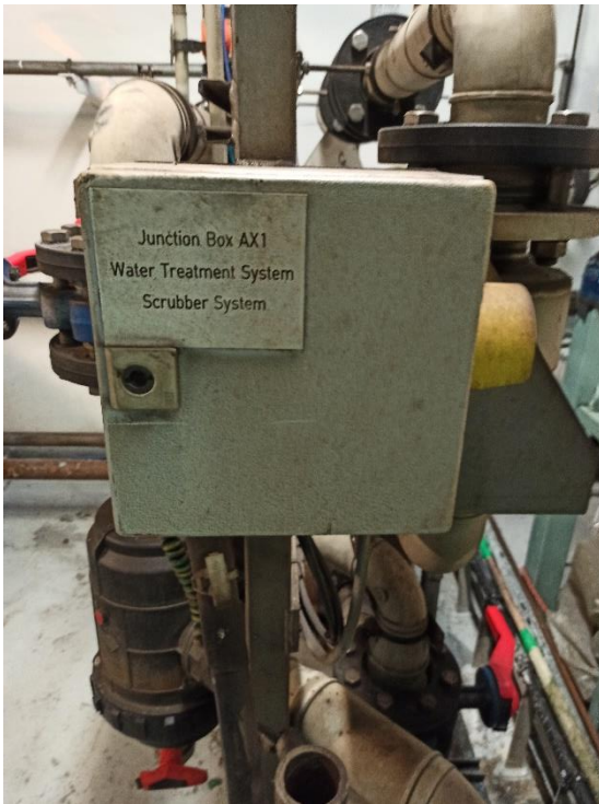
Figura 39. Vista de la caixa de connexions de la planta de tractament d'aigua de lavado residual de un SLGE de tipus híbrid instal·lada a bord d'un buque tipus portacontenedores. Fuente: el Autor.
