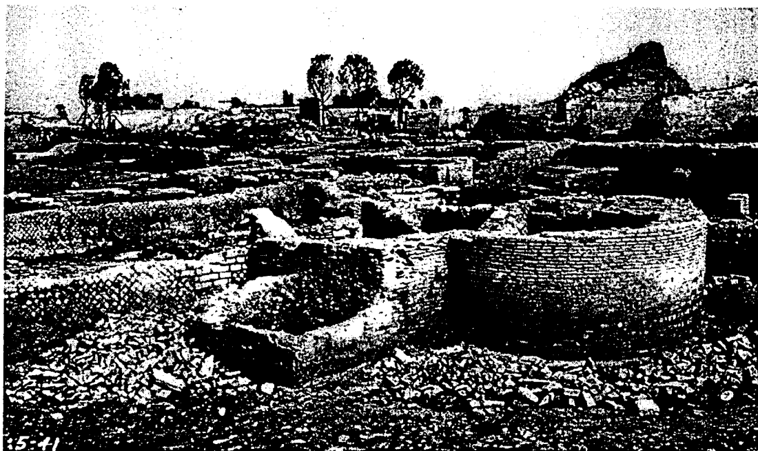
Fig.26.- Exterior del recinte absidiat en el moment de la seva excavació (S.A.O. B-2994).
