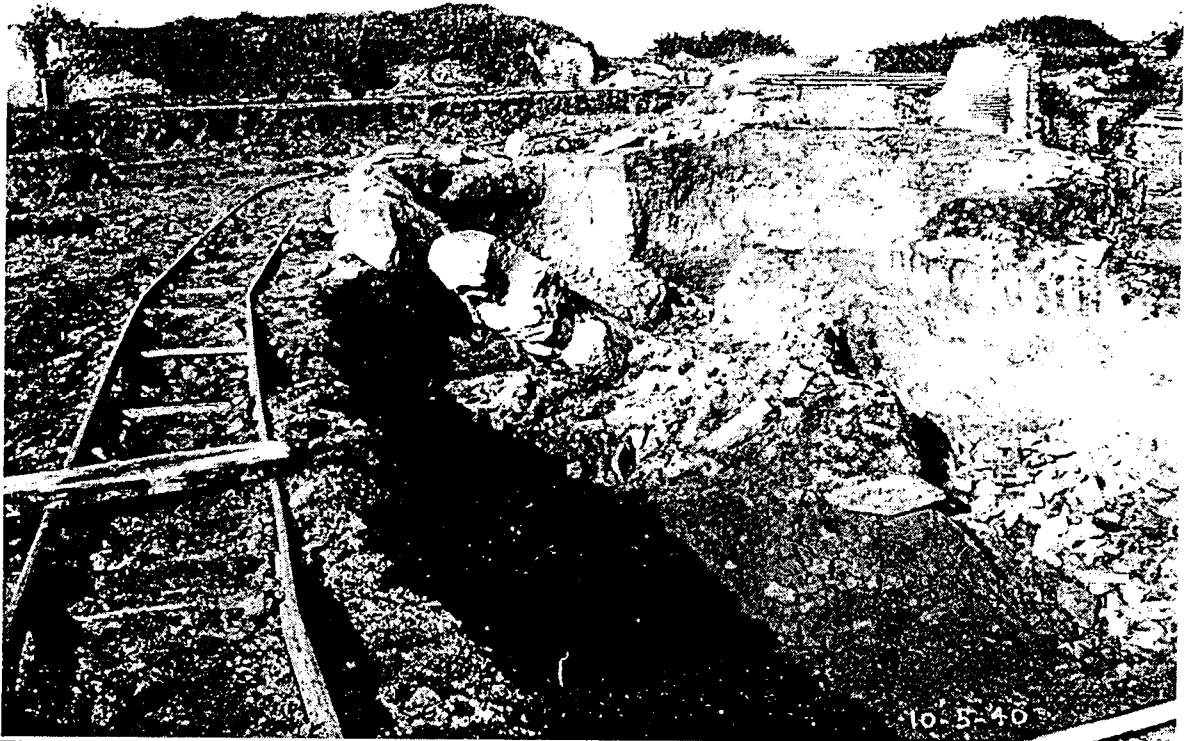
Fig.-31.- Fotografia de les excavacions del recinte d'Atis (S.A.O. B-2909).
