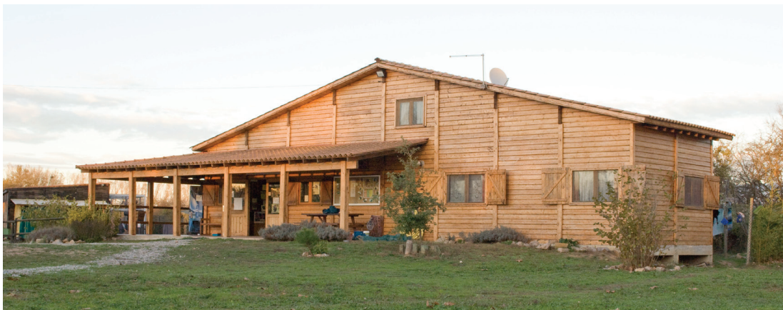
Figura 41: Aula de educación y oficinas del Centro de Recuperación de Primates de Fundación Mona.
