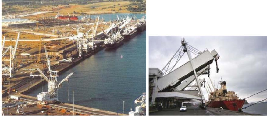
**Figura 2.26** Puerto de Richards Bay (Izquierda). Detalle de las cintas transportadoras utilizadas en el puerto para el llenado de los barcos con circón (Derecha).
