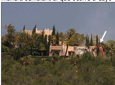
Figura 1. Can Cretu amb la màquina excavadora (Font: Manresa, 9/05/2009).
