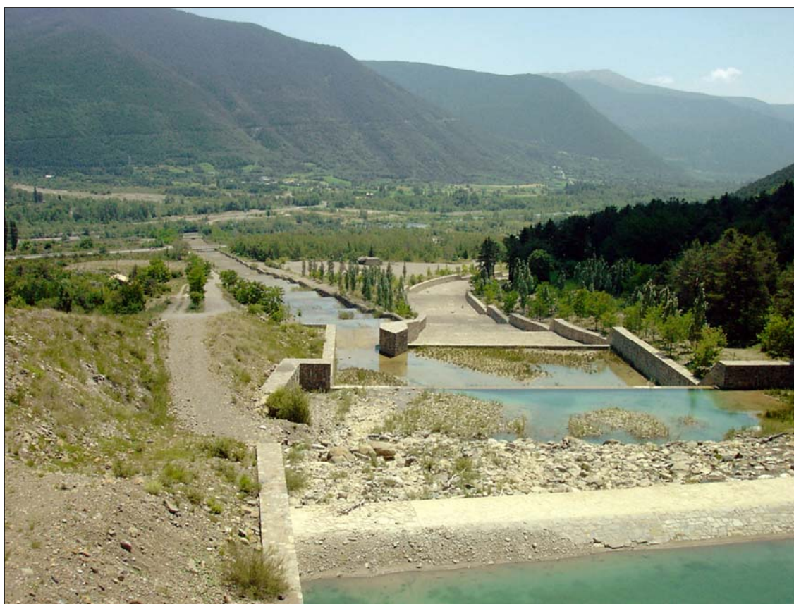
Figura 10.8: Nuevo cauce de entrada al cono de deyección del torrente. Foto: Juan Carlos García Codron.
