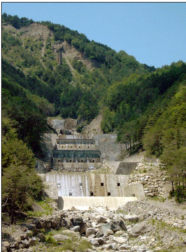
Figura 10.3: Presas en el canal de desagüe construidas en sustitución de las que fueron destruidas por el desastre. En la parte superior de la foto se aprecia una “demoiselle coiffée” forma asociada al desmantelamiento del depósito glaciar que demuestra la fácil movilización del mismo.
