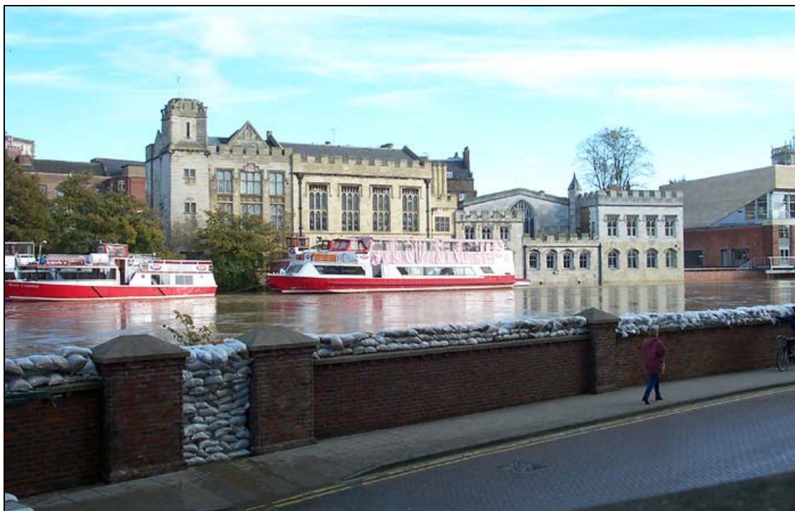
Figura 10.20: Instalación de defensas provisionales contra la inundación. North Street , ciudad de York (noviembre de 2000).
