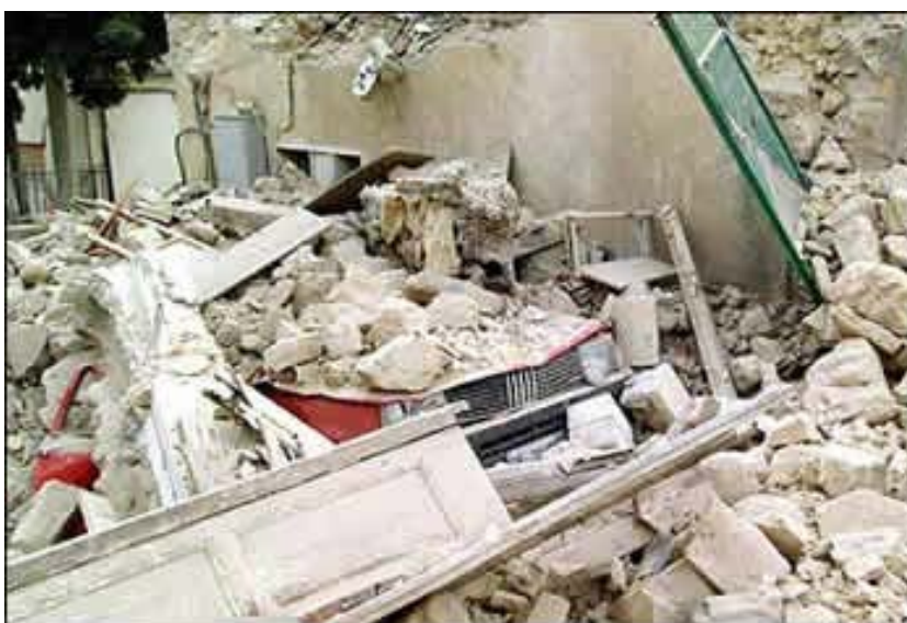
Figura 10.17: Detalle de la escuela derrumbada en San Giuliano di Puglia.
