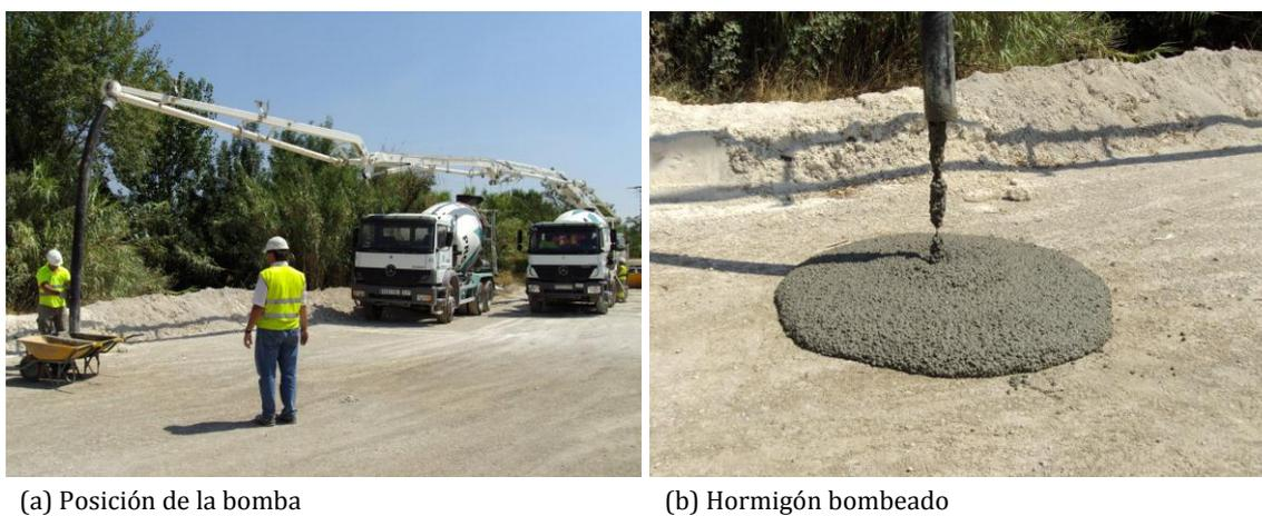
*Figura 7.10 – Bombeo del HLACF en la dirección horizontal*
