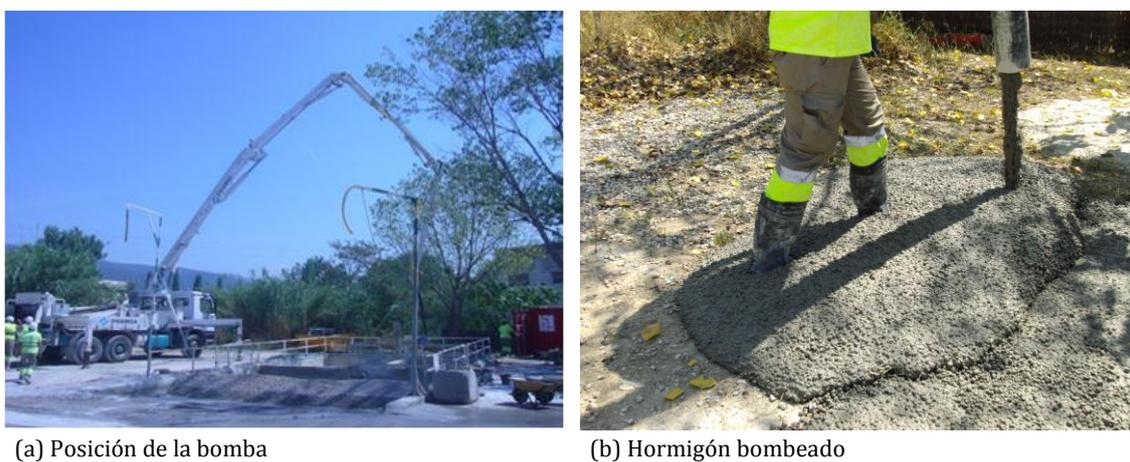
*Figura 7.9 – Bombeo del HLACF en la dirección vertical*
