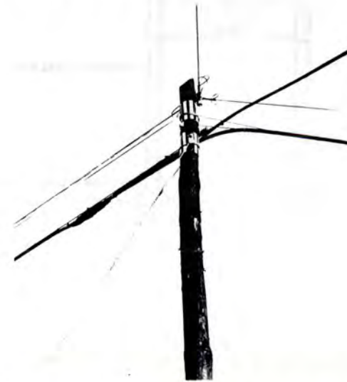
Fig. 4.34.- Pal de telèfons i antenes ancorats amb vents.
