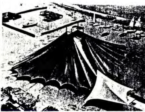
Fig. 4.13.- Pavelló d'esbarjo. Màlaga 1971. (Artiques, López Rey & Soldevila, Arqtes.) Els ancoratges es van comprovar realitzant assaigs d'arrencament.
