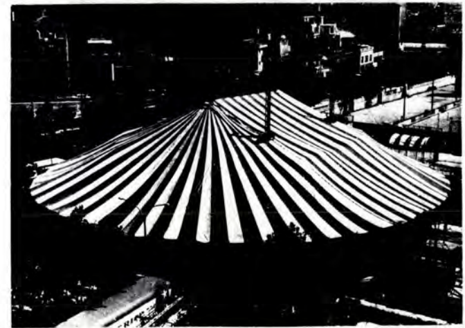
Fig. 4.8.- La tenda del circ, ancorada amb estacques i paliars.
