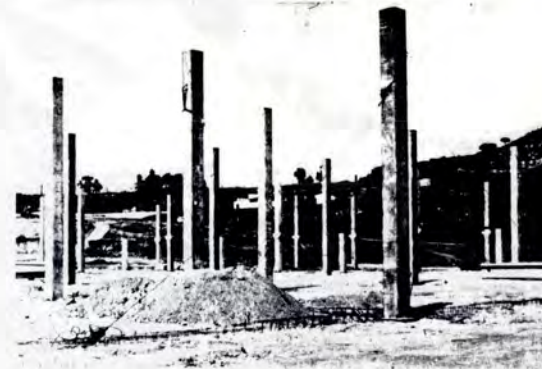
Fig. 4.23.- Arriostament d'estructures lleugeres i prefabricades: Fotografia superior: Coberta tensada, "Liceo Sorolla", Pozuelo de Alarcón (M. Majowiecki) Fotografia inferior: Estructura prefabricada de l'hipermercat "Makro" en construcció (Badalona).
