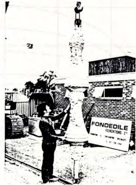
Fig. A.5.- Pilots eixamplats (Hanna, 1982)
