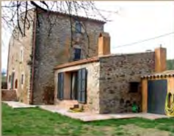
estado final (I)
