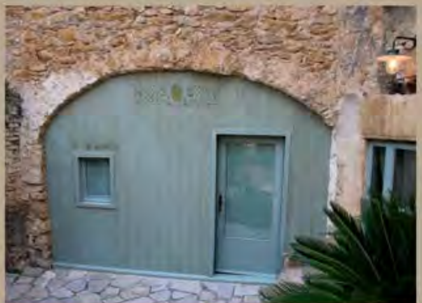
CERRAMIENTO ESTADO FINAL
