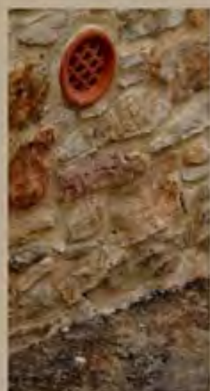
VENTILACION SOLERA ESTADO FINAL
