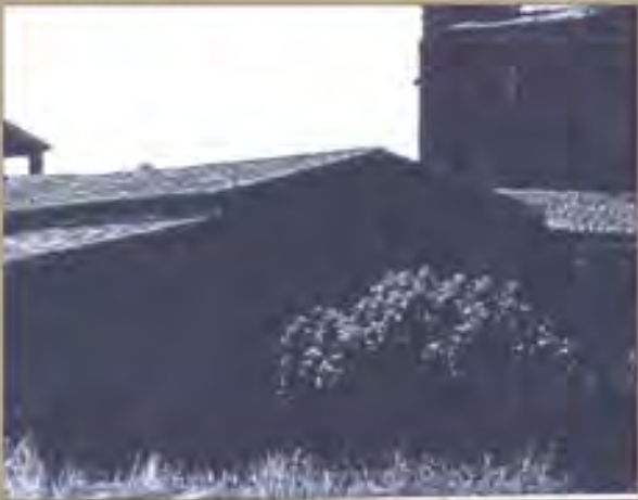
estado final (I)
