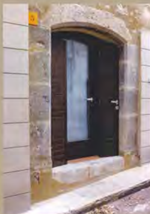
PORTAL PRAL. ESTADO FINAL
