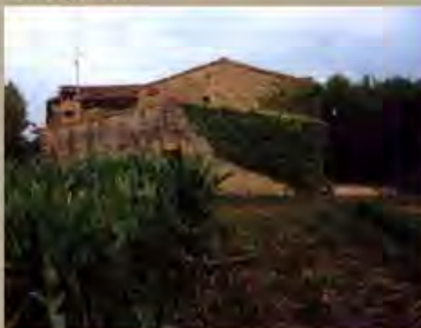
estado final (I)
