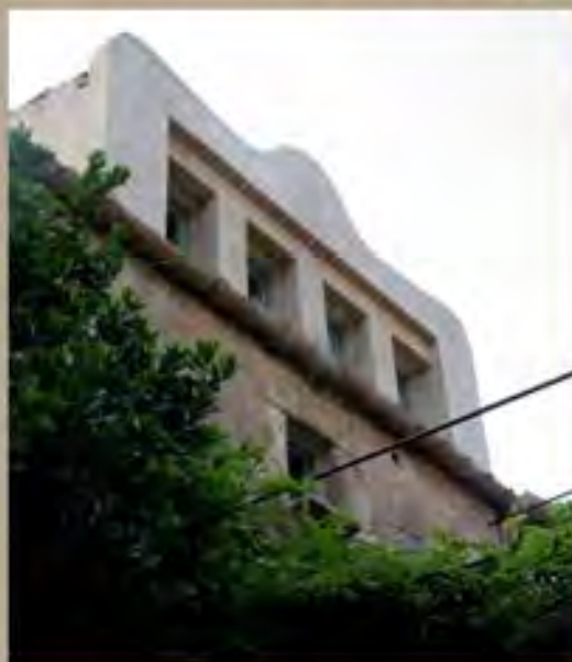
LINTERNA ESTADO FINAL
