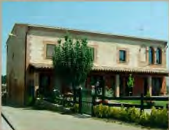
estado final (I)
