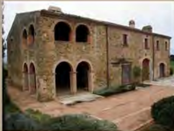
estado final (I)
