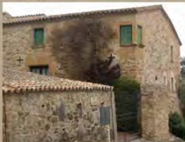
estado final (I)
