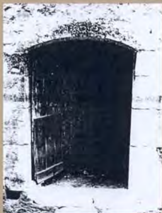
PORTAL PRAL. ESTADO ORIGINAL
