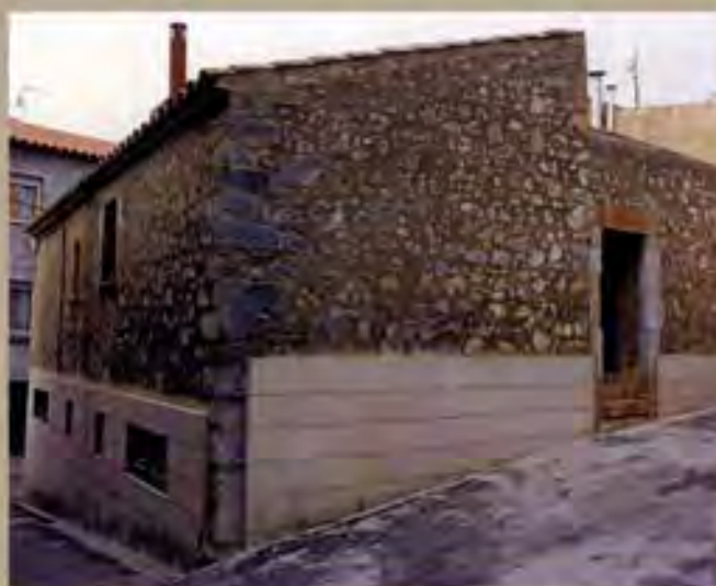
ESQUINA N ESTADO FINAL
