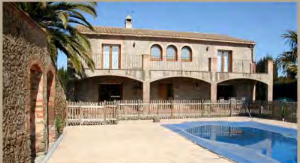
FACHADA SUR ESTADO FINAL
