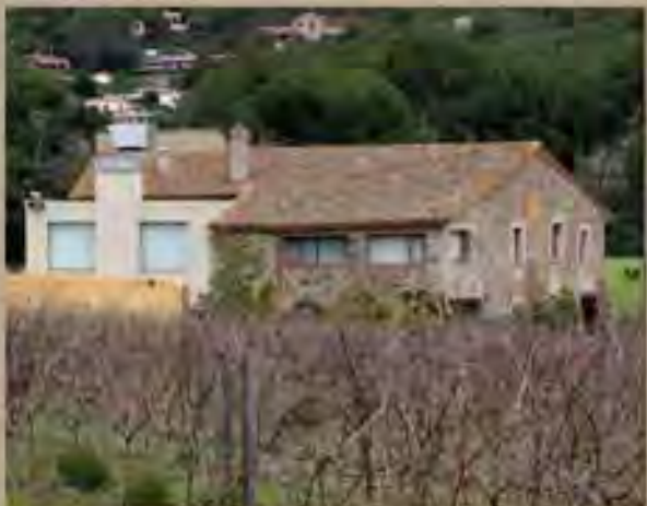
estado final (I)
