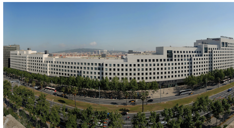
Figures 4.17. A. De Mesa; T. Bover. Illa Diagonal, Barcelona, 2007. Imatge panoràmica en perspectiva cilíndrica
