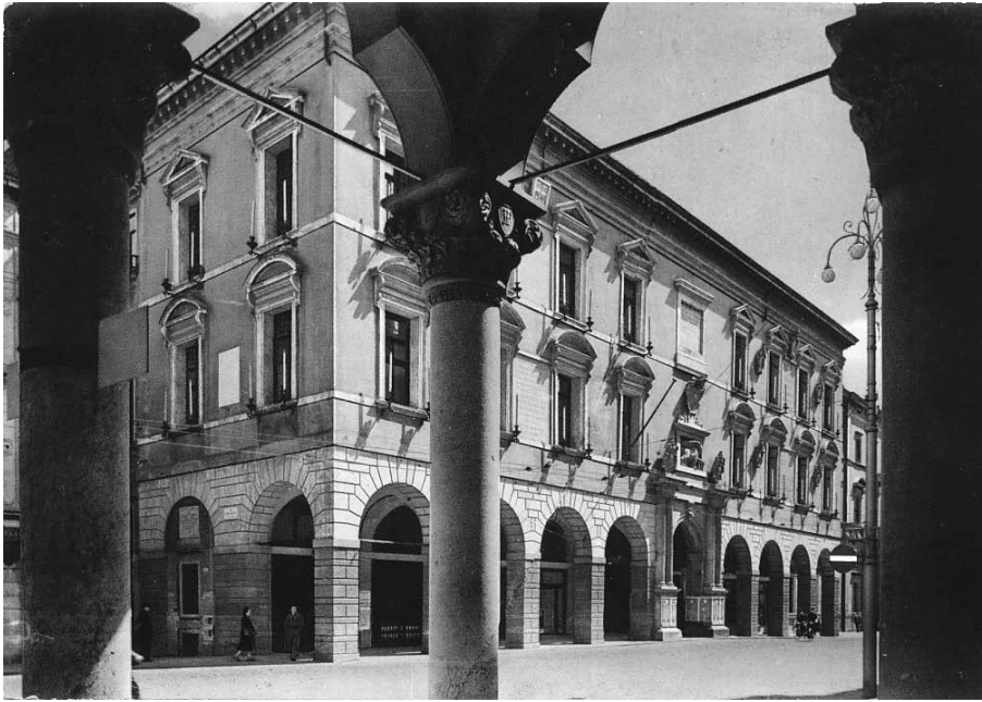
Fig. 38. Palacio Bo, edificio principal de la Universidad de Padua, el cual, alberga el anfiteatro anatómico en la esquina izquierda (noroeste) de las dos plantas superiores. Vista desde la galería vecina al Caffè Pedrocchi. Postal B. Facchinelli, Padova © Archivo Claudio Galeno.
