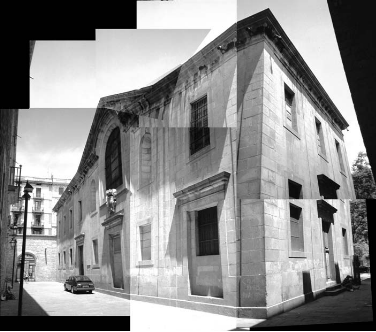
Fig. 60. Real Colegio de Cirugía de Barcelona, vista hacia el norte desde el acceso norte del Hospital de la Santa Creu. © Claudio Galeno.
