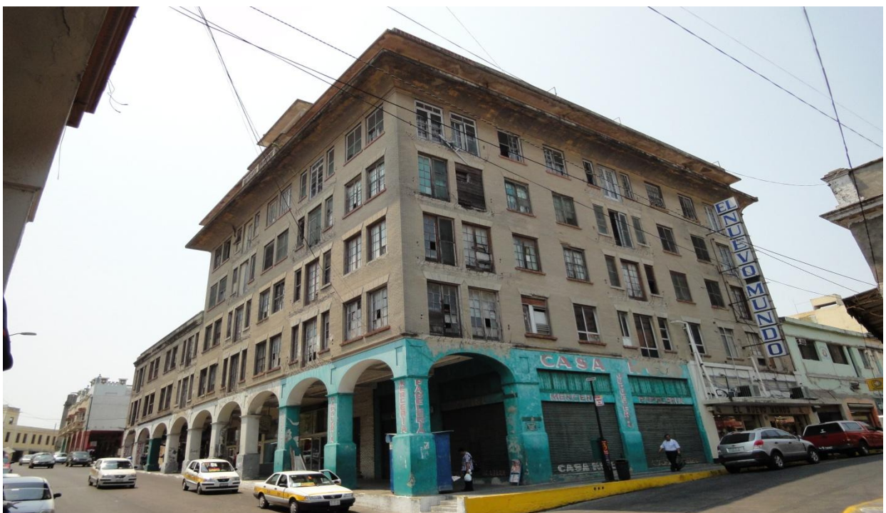
Figura. 77. Edificio en abandonado total en el Centro Histórico de Tampico. 2011. FUENTE: SOLORZANO CERDA M. DEL PILAR.
