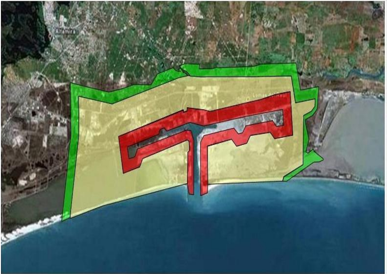
Figura. 52. Vista satelital del Complejo Industrial Portuario de Altamira. 2011. FUENTE: Administración Portuaria Integral de Altamira (API Altamira). Ciudad. www.puertoaltamira.com.mx
