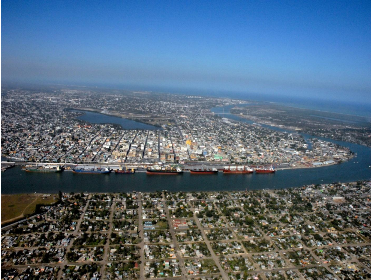
Figura. 50. Vista aérea actual Puerto de Tampico. 2011. FUENTE: Administración Portuaria Integral de Tampico (API Tampico). Ciudad.
