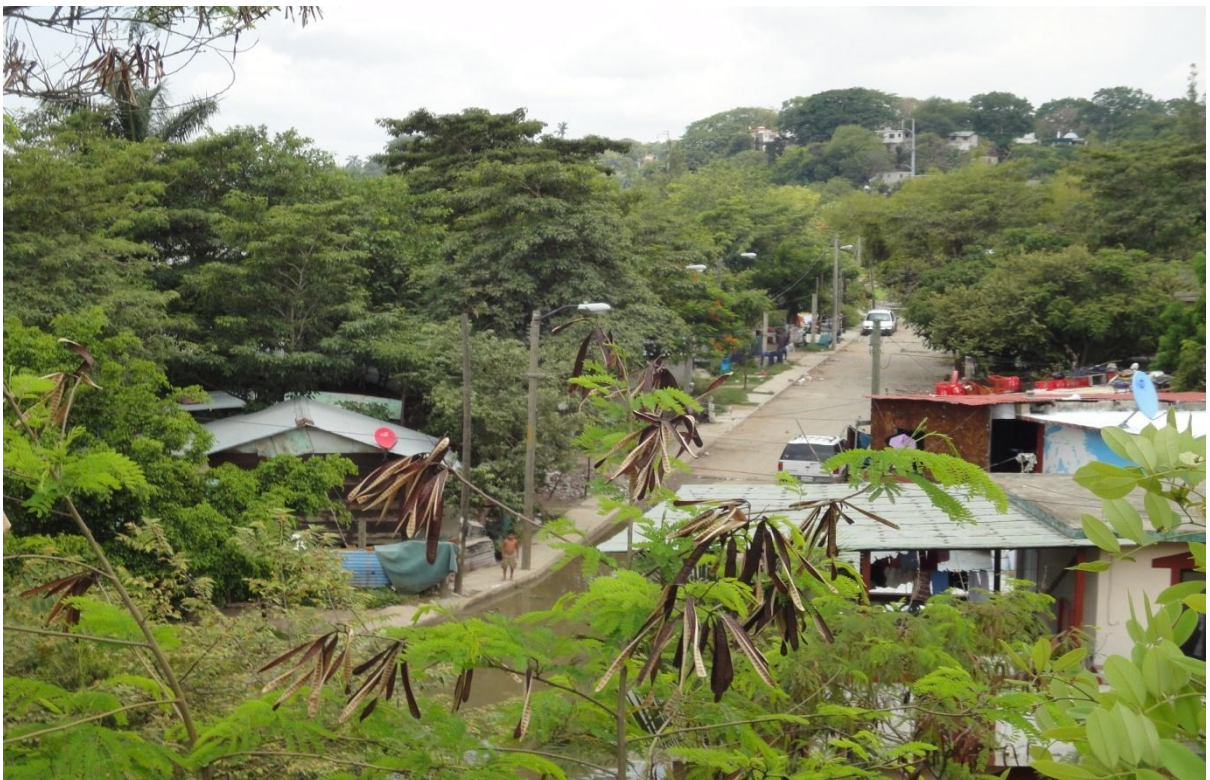
Figura. 54. Morfología de un emplazamiento situado en zona de alto riesgo a la margen del Río Tamesí, en la colonia El Sauce de Tampico. 2011. FUENTE: Propia.
