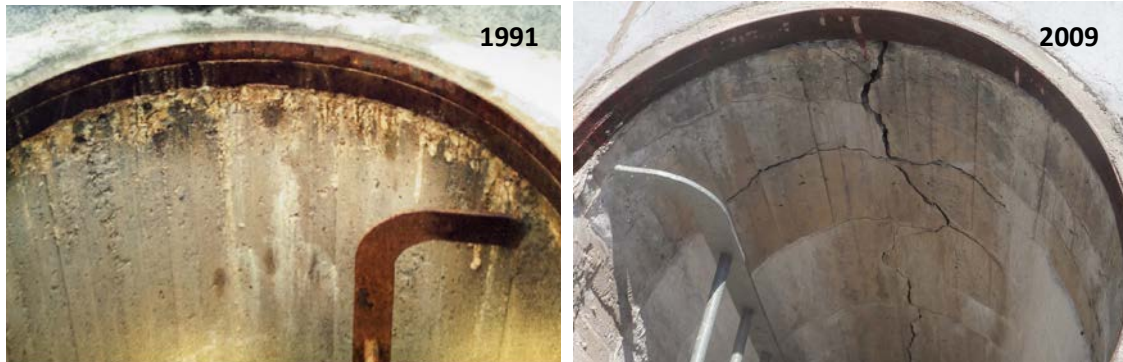
Figura 7.39 – Vista de la parte superior del pozo del péndulo 2 en 1991 y en 2009.
