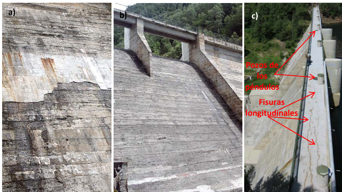
Figura 7.9 – Aspecto del hormigón del paramento aguas abajo y de la coronación de la presa de Graus.
