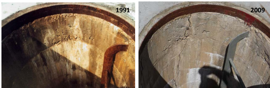
Figura 7.13 – Vista de la parte superior del pozo del péndulo 1 en 1991 y 2009.
