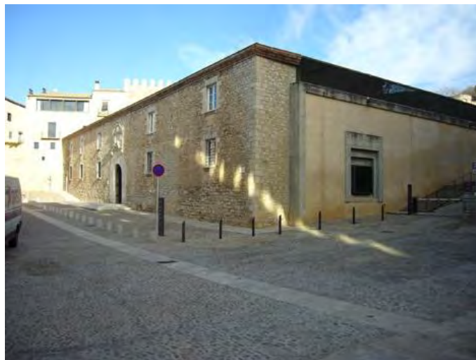
Edifici del Rectorat de la Universitat de Girona.
