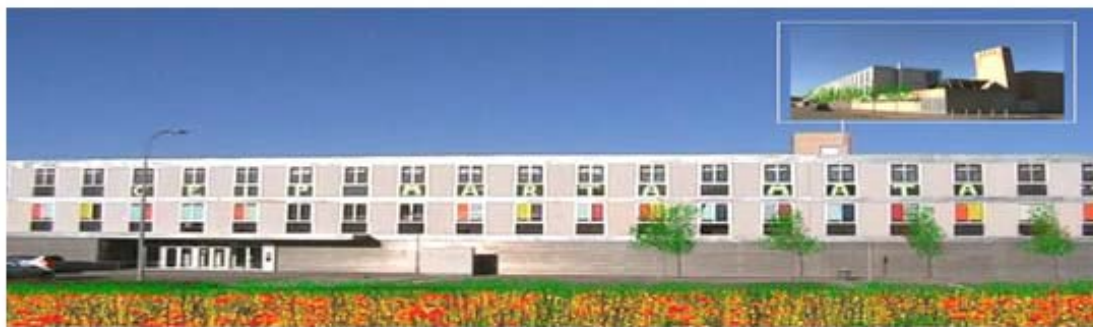
Fachadas del edificio
