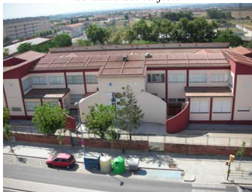
Fachadas del edificio 1
