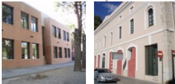
Fachadas del edificio 1
