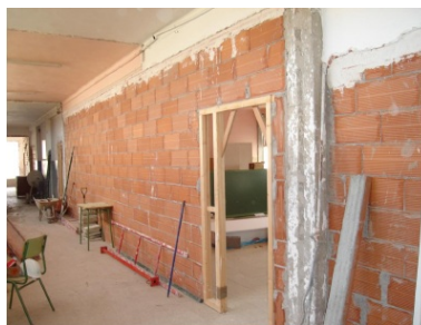
Identificación de pilares de hormigón armado.
