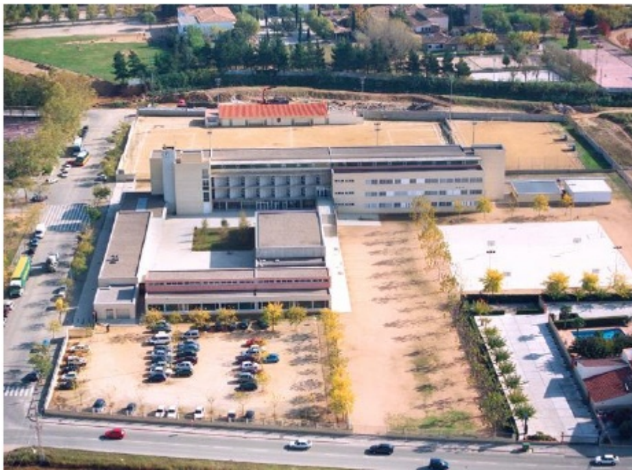
Fuente: Estudi de patologies i ampliació del I.E.S. Santa Eugenia
