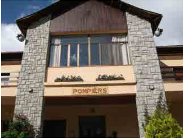
Foto 11_1-1 Fachada del edificio
