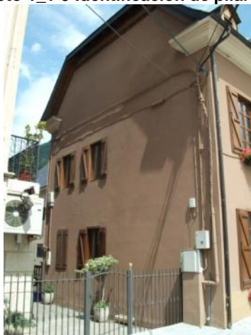
Foto 1_1-11 Vista de fachada
