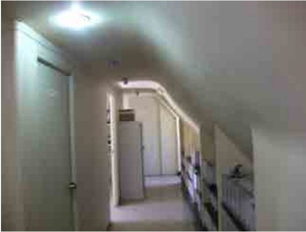
Foto 14_1-13 Oficinas de la última planta
