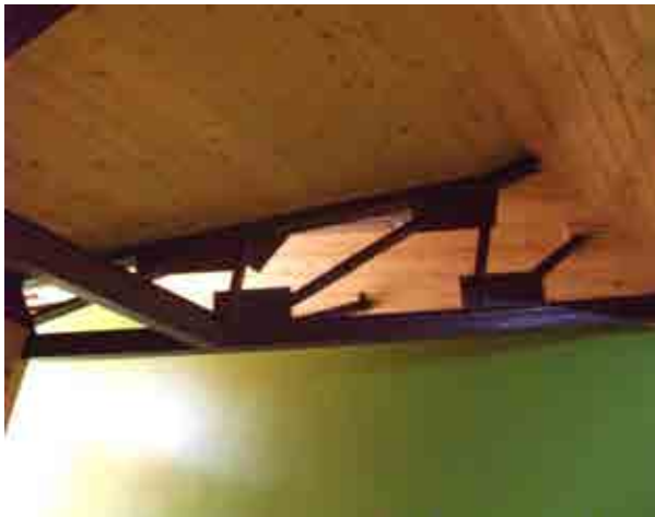
Foto 25_1-28 Estructura del techo
