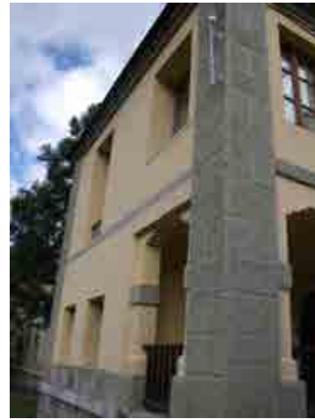
Foto 23_1-2 Fachada del edificio
