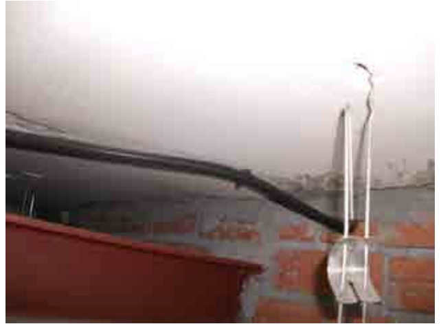
Foto 11_1-8 Inspección de forjados y de muros
