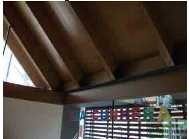
Foto 31_1-4 Detalle de la estructura del techo
