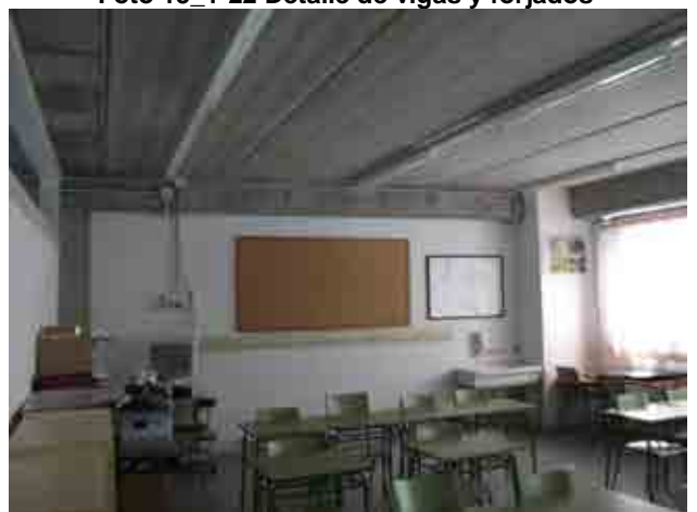
Foto 15_1-24 Detalle de la tabiquería y configuración de salones
