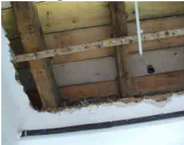
Foto 23_1-9 Inspección del forjado
