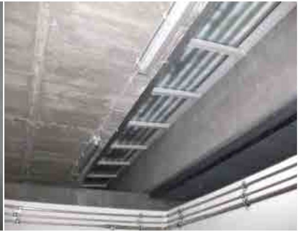
Foto 17_1-10 Forjados de la zona de graderías
