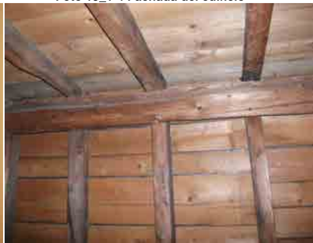
Foto 19_1-6 Estructura del techo
