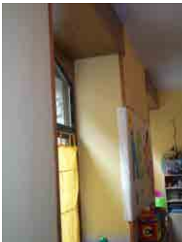
Foto 6_1-11 Vista de los muros (EEI)
