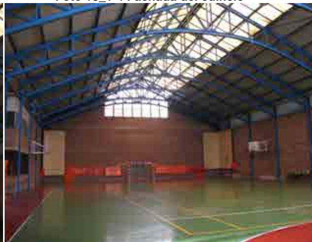
Foto 18_1-6 Estructura del techo y muros laterales
