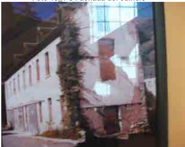
Foto 19_1-5 Fachada del edificio (Foto antigua)
