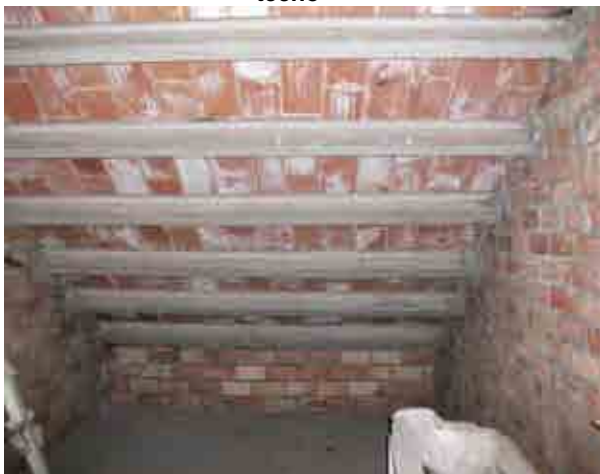
Foto 20_1-17 Muros del edificio y estructura del techo
