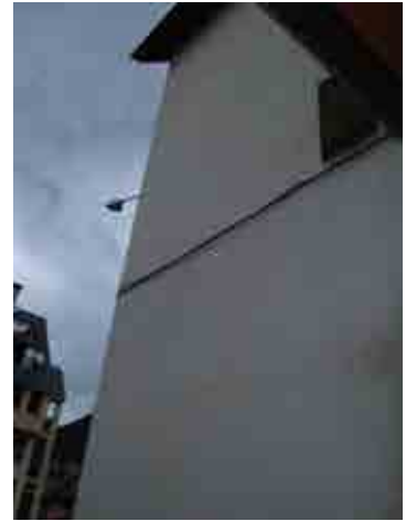
Foto 5_1-4 Fachada del edificio
