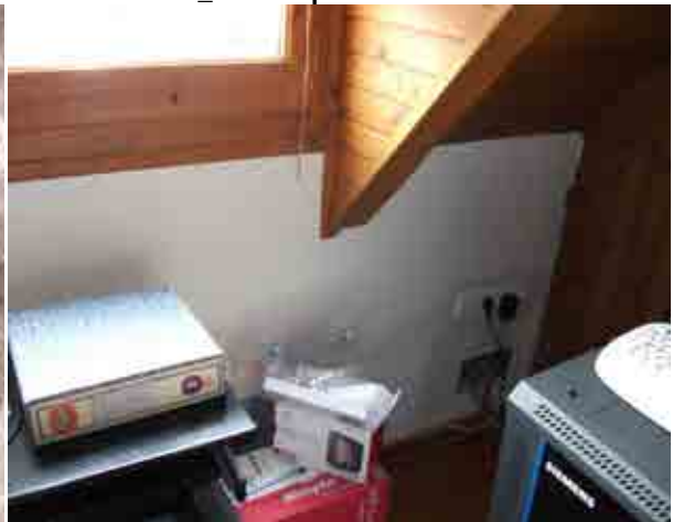
Foto 22_1-12 Inspección de muros
