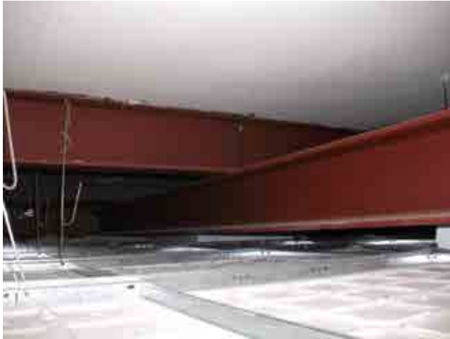
Foto 11_1-7 Inspección de forjados y de muros
