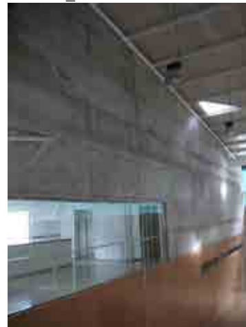
Foto 17_1-6 Muros de hormigón armado del edificio
