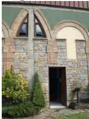
Foto 24_1-5 Fachada del edificio
