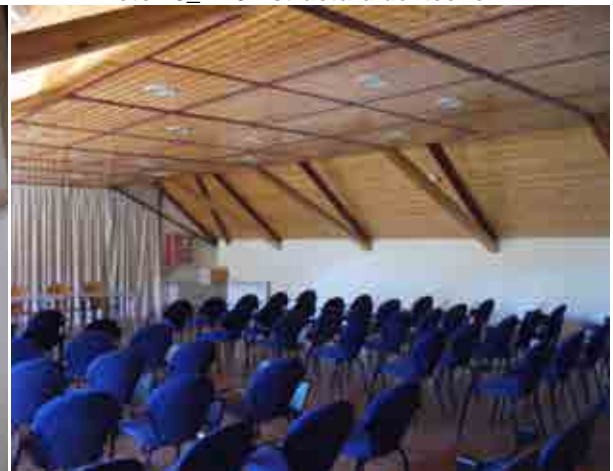
Foto 25_1-31 Estructura del techo
