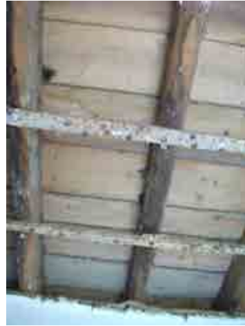
Foto 23_1-8 Inspección del forjado
