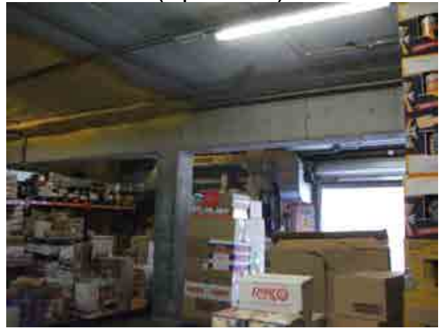
Foto 12_1-4 Pilares, vigas y forjado planta subterránea (supermercado)
