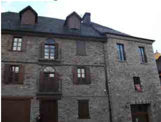
Foto 6_1-3 Fachada del edificio
