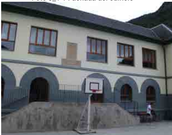
Foto 9_1-3 Fachada del edificio
