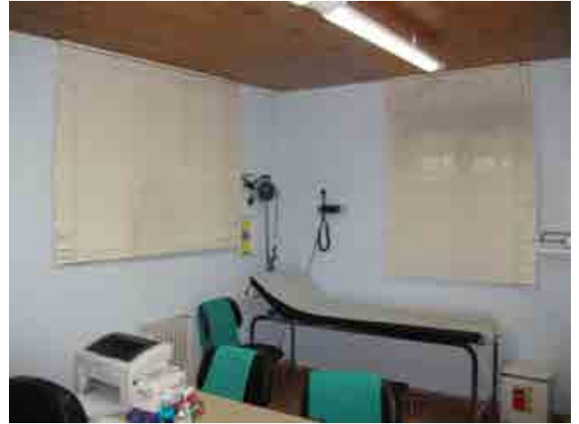
Foto 33_1-8 Muros del edificio
