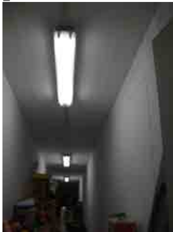
Foto 31_1-9 Detalle de muros interiores
