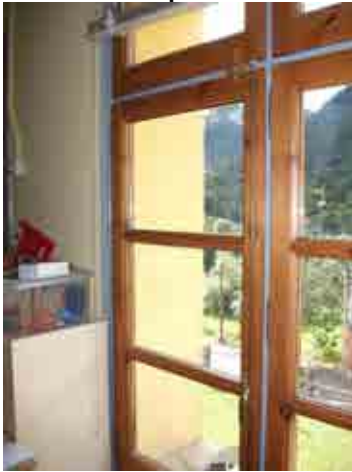
Foto 22_1-15 Inspección de muros
