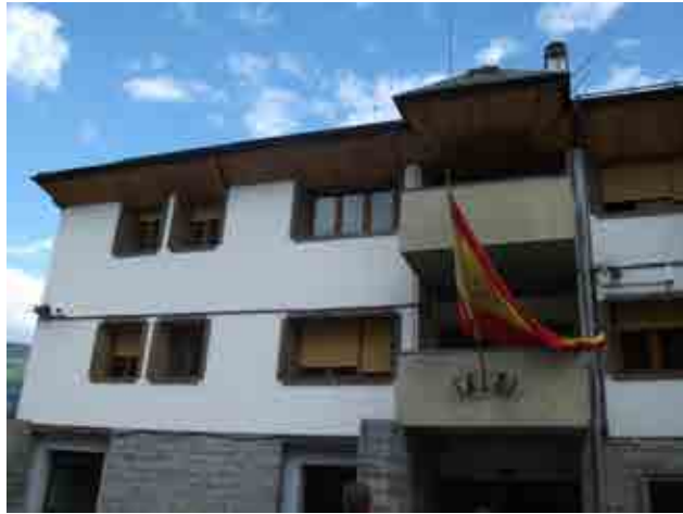
Foto 20_1-6 Fachada del edificio
