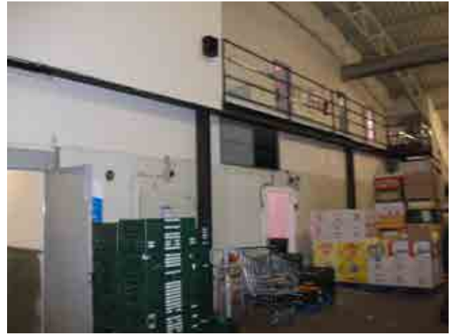
Foto 13_1-10 Muros de la zona de oficinas
