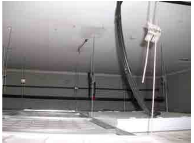
Foto 11_1-10 Inspección de forjados y de muros
