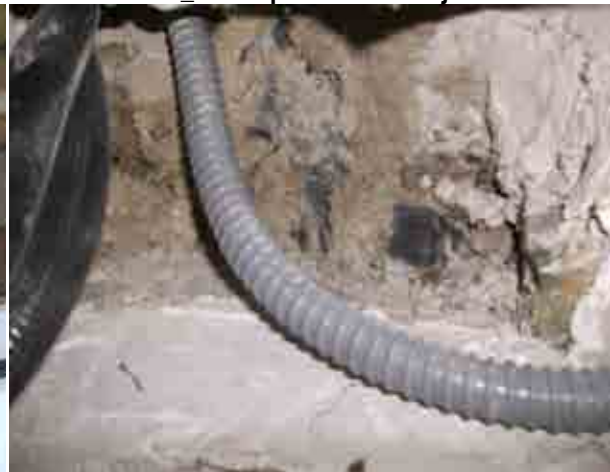
Foto 23_1-10 Inspección de muros
