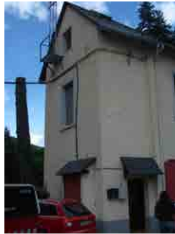
Foto 19_1-2 Fachada del edificio
