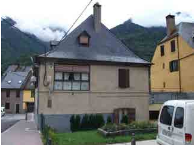
Foto 34_1-3 Fachada del edificio
