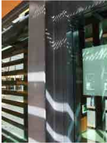
Foto 12_1-7 Pilares metálicos (centro comercial)
