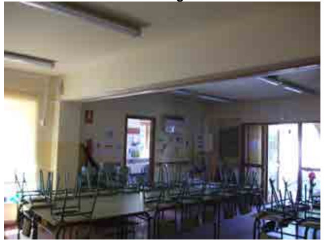
Foto 26_1-10 6 Forjados primera planta-Viguetas y laminas de hormigón armado
