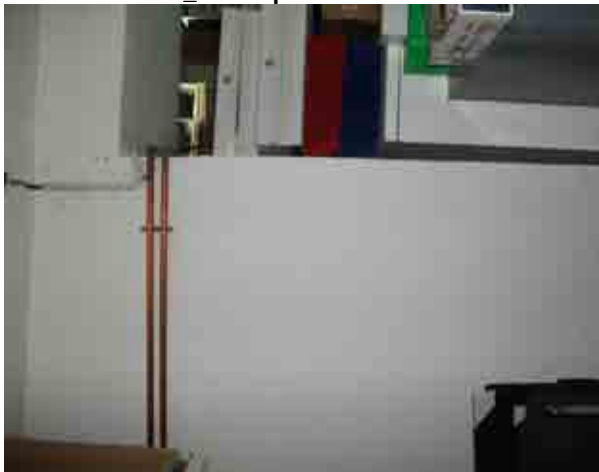
Foto 22_1-9 Inspección de muros
