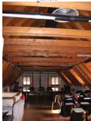
Foto 22_1-24 Estructura del techo
