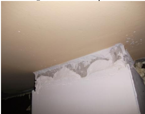
Foto 1_2-4 Inspección de pilares
