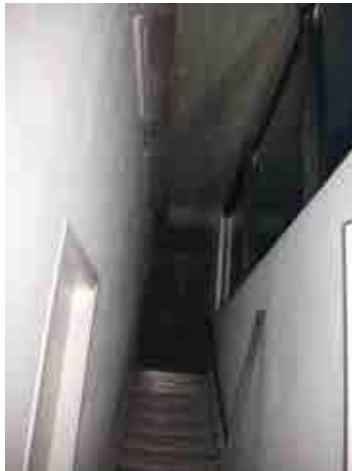
Foto 15_1-9 Muros en zonas de escaleras
