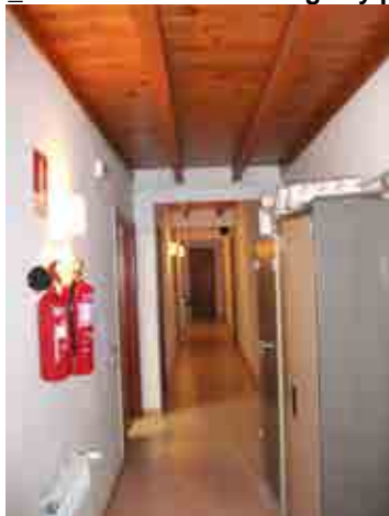
Foto 3_1-9 Identificación de vigas y pilares
