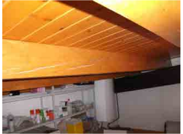
Foto 33_1-14 Detalle de la estructura del techo
