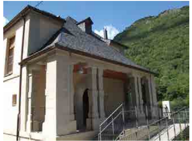
Foto 29_1-2 Fachada del edificio
