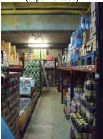
Foto 12_1-5 Pilares, vigas y forjado planta subterránea (supermercado)
