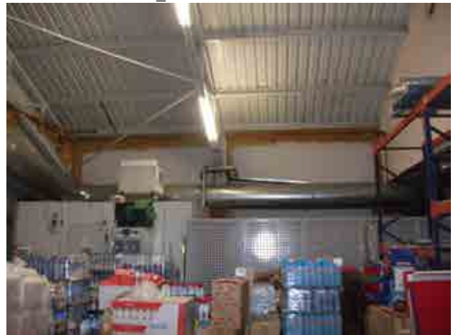
Foto 13_1-4 Muros, techo y cercha de la estructura
