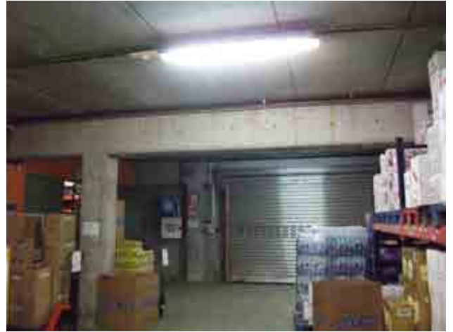
Foto 12_1-2 Pilares, vigas y forjado planta subterránea (supermercado)
