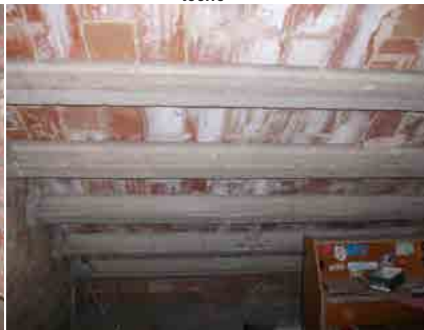
Foto 20_1-18 Muros del edificio y estructura del techo
