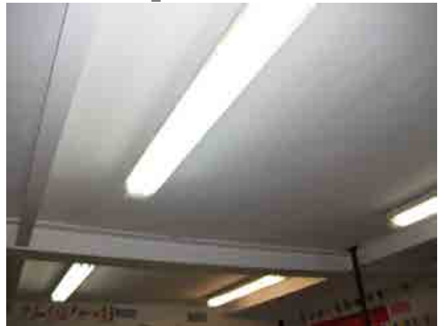
Foto 27_1-6 Reformas en el techo de la primera planta. Adición de vigas metálicas
