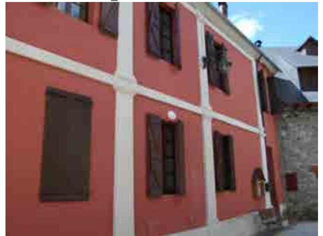
Foto 33_1-6 Fachada del edificio
