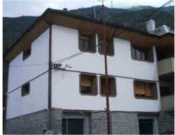
Foto 20_1-8 Fachada del edificio
