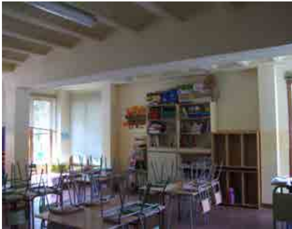
Foto 26_1-19 Forjados - Viguetas y Bóvedillas hormigón armado
