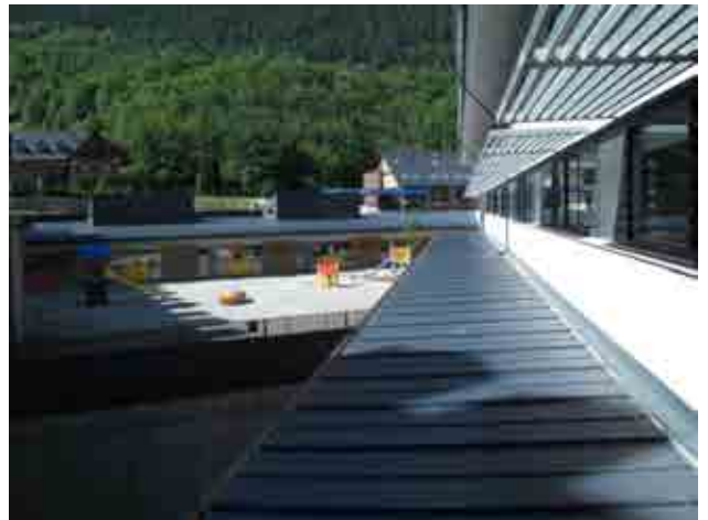
Foto 15_1-20 Techos del edificio
