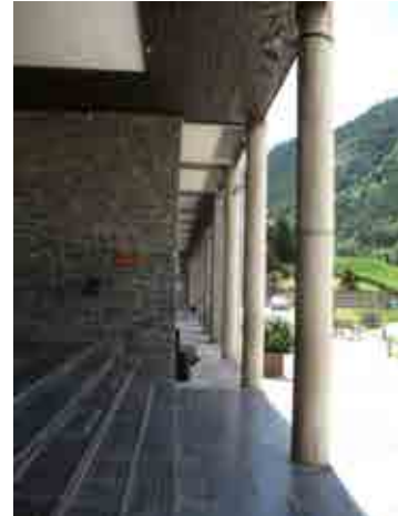
Foto 25_1-2 Fachada del edificio
