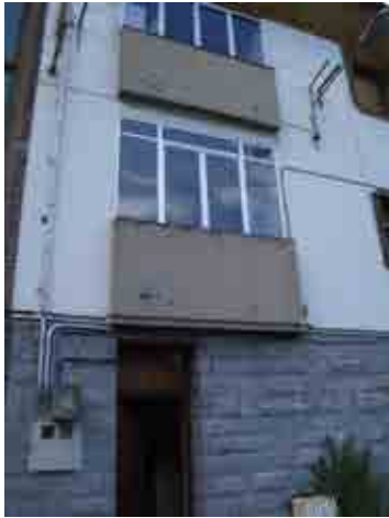
Foto 20_1-3 Fachada del edificio
