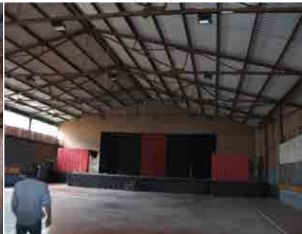
Foto 8_1-4 Vista de las cerchas
