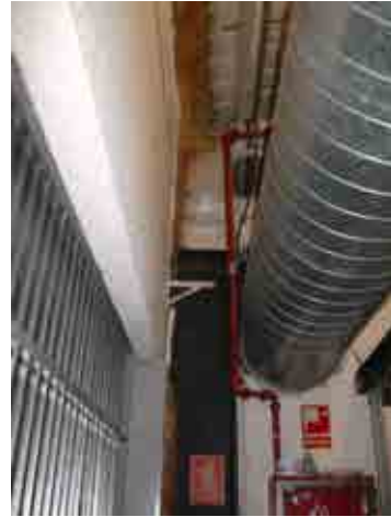
Foto 13_1-8 Muros de la sección de oficina
