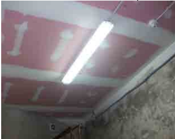
Foto 6_1-9 Revisión de entresijos (Zona de almacenamiento de combustible)
