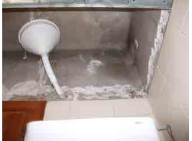
Foto 14_1-14 Inspección de materiales de muros y forjados
