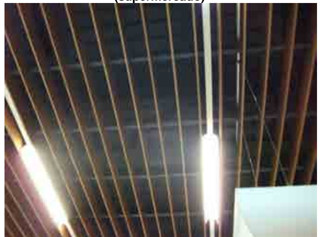
Foto 12_1-6 Estructura metálica de los techos (supermercado)
