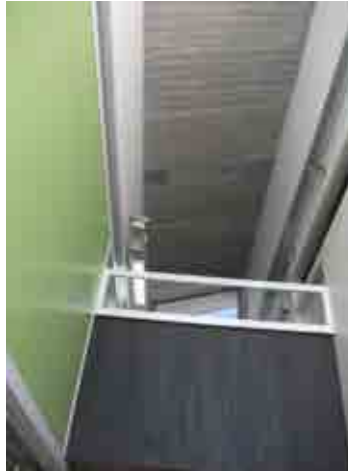
Foto 15_1-26 Detalle de los forjados en la segunda planta
