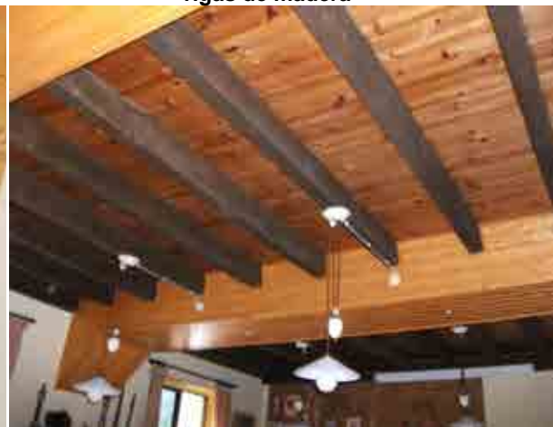
Foto 19_1-12 Reformas realizadas a los forjados - vigas de madera
