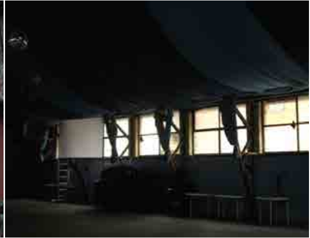
Foto 10_1-2 Detalle de las cerchas
