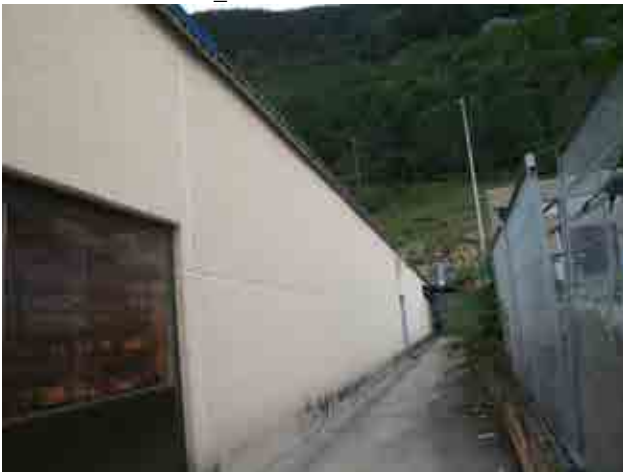
Foto 13_1-3 Fachada del edificio
