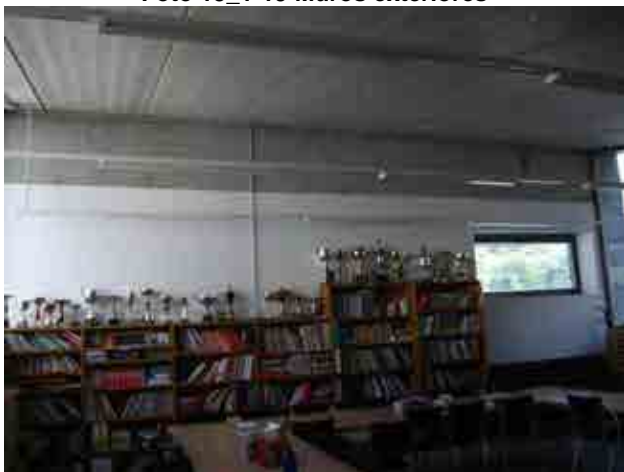
Foto 15_1-21 Detalle de muros, vigas y forjados
