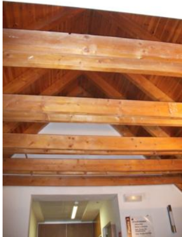
Foto 1_1-7 Estructura de los techos
