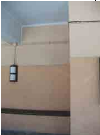
Foto 14_1-11 Detalle de los muros
