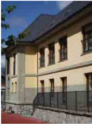
Foto 26_1-1 Fachada del edificio
