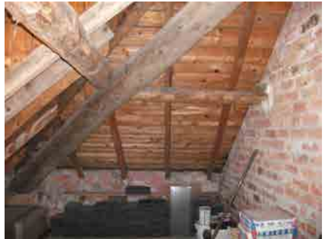
Foto 11_1-14 Inspección del techo del edificio
