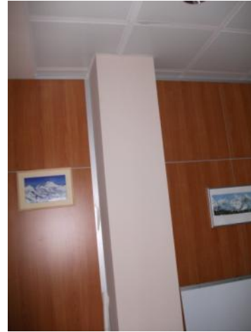
Foto 1_2-3 Inspección de pilares
