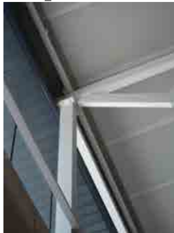
Foto 17_1-5 Detalle de cerchas
