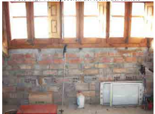
Foto 11_1-16 Inspección del techo del edificio
