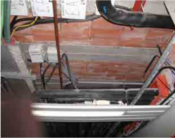
Foto 2_1-7 Forjados del túnel de comunicación entre el hospital y la residencia
