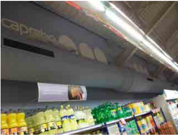
Foto 13_1-15 Detalles de la cercha y muros de la estructura
