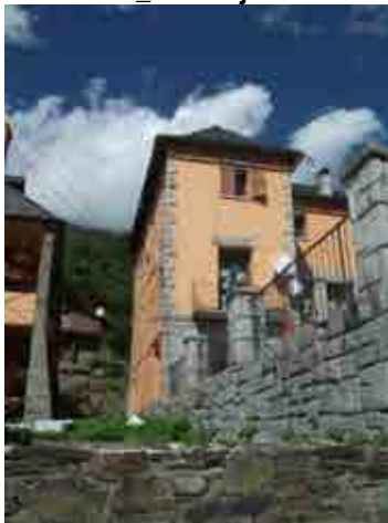
Foto 28_1-5 Fachada del edificio
