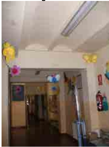
Foto 26_1-15 Forjados - Viguetas y Bóvedillas hormigón armado
