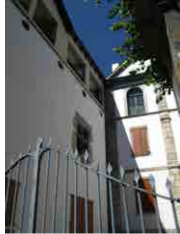
Foto 30_1-10 Fachada del edificio
