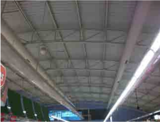
Foto 13_1-13 Cercha del supermercado
