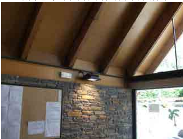
Foto 31_1-5 Detalle de la estructura del techo
