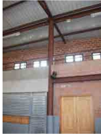
Foto 8_1-8 Detalles pilares y vigas metálicas
