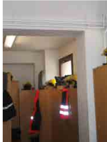
Foto3_1-8 Identificación de vigas y pilares
