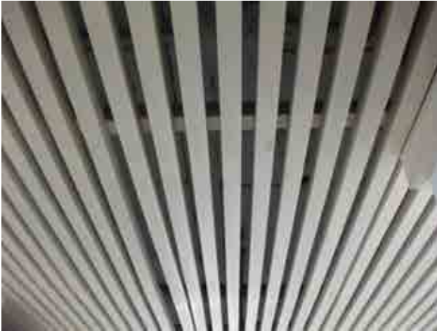
Foto 25_1-19 Inspección de forjados segunda planta
