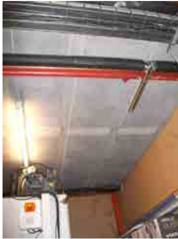
Foto 13_1-9 Muros y forjados de la zona de oficinas
