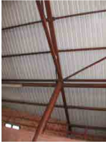
Foto 8_1-7 Detalles pilares y vigas metálicas
