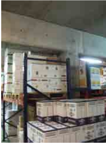
Foto 12_1-1 Pilares, vigas y forjado planta subterránea (supermercado)
