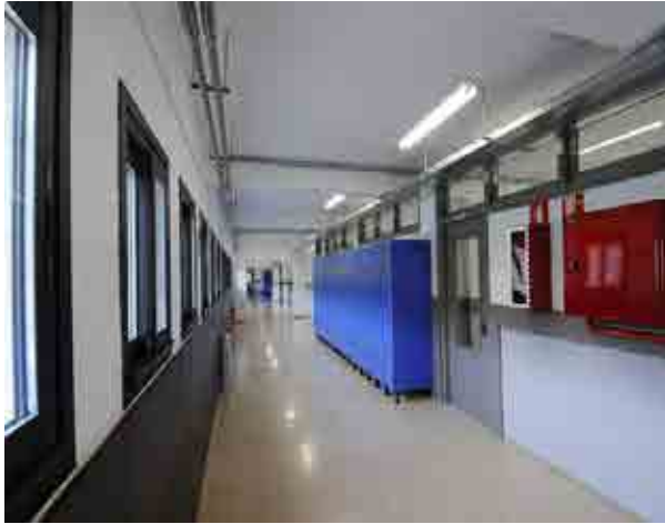
Foto 16_1-1 Vista al interior del edificio - Distribución de pilares
