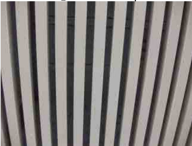
Foto 25_1-9 Inspección de forjados planta baja
