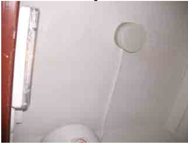
Foto 27_1-9 Detalle de grietas en el techo
