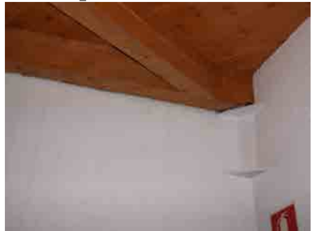
Foto 33_1-12 Detalle de la estructura del techo
