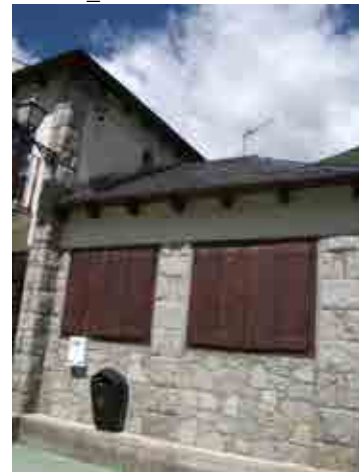
Foto 27_1-4 Fachada del edificio
