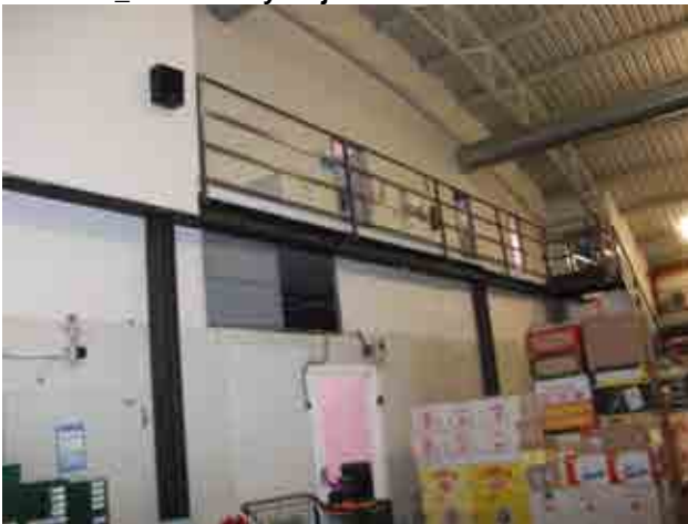
Foto 13_1-11 Muros de la zona de oficinas
