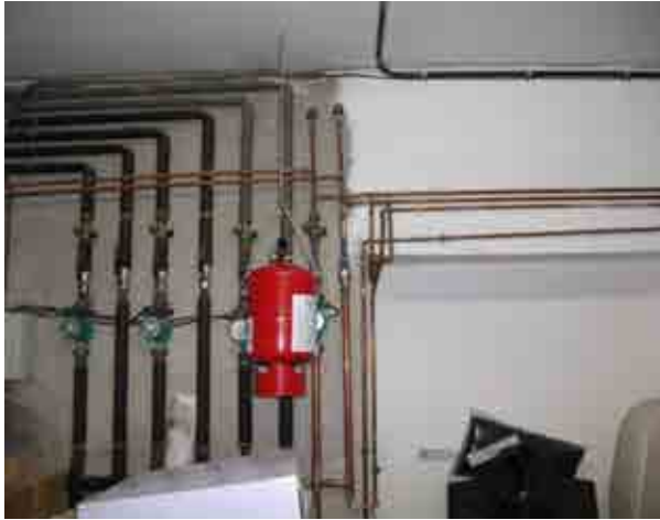
Foto 22_1-7 Inspección de muros
