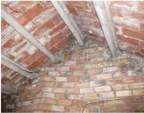
Foto 20_1-13 Muros del edificio y estructura del techo
