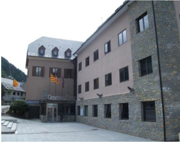
Foto 1_2-2 Fachada de la ampliación
