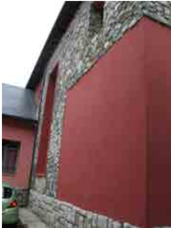
Foto 35_1-3 Fachada del edificio
