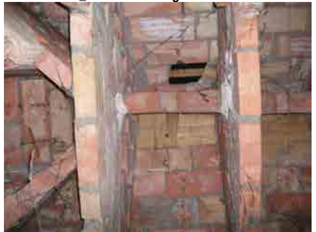
Foto 27_1-12 Estructura del techo y muros del edificio
