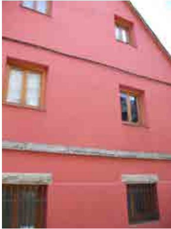
Foto 33_1-1 Fachada del edificio
