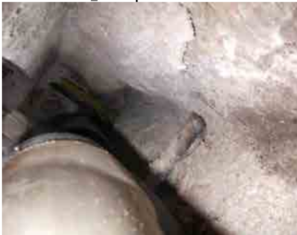
Foto 22_1-11 Inspección de muros
