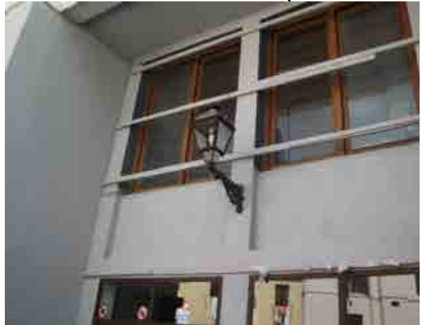
Foto 18_1-12 Detalle de muros y forjados de la zona de oficinas
