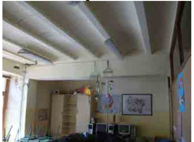
Foto 26_1-18 Forjados - Viguetas y Bóvedillas hormigón armado
