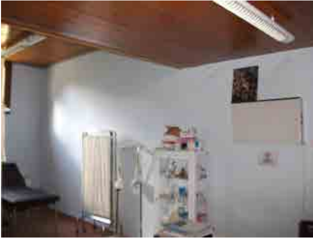
Foto 33_1-7 Muros del edificio
