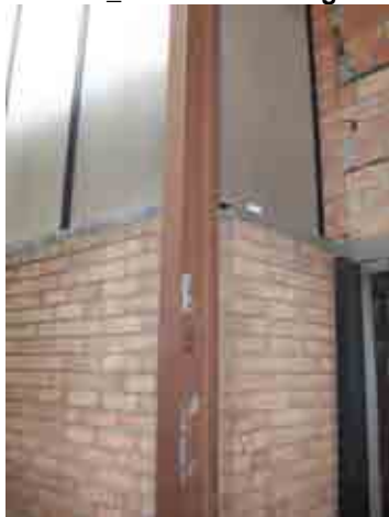
Foto 8_1-11 Pilares metálicos exteriores
