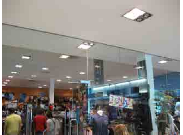
Foto 12_1-8 Pilares metálicos (centro comercial)
