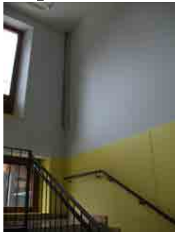
Foto 9_1-5 Muros de las escaleras
