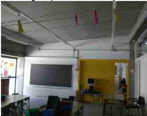
Foto 15_1-28 Forjados, vigas, pilares y tabiquería
