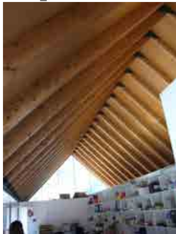
Foto 31_1-3 Detalle de la estructura del techo
