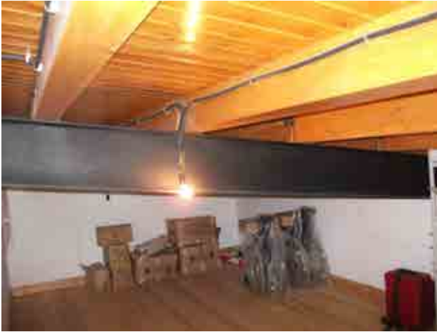
Foto 33_1-13 Detalle de la estructura del techo
