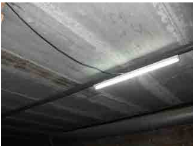
Foto 32_1-6 Detalle del forjado
