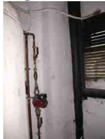
Foto 20_1-10 Muros interiores del edificio
