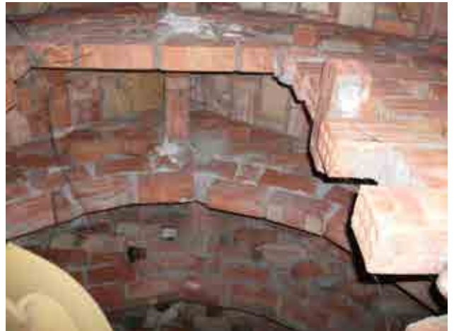
Foto 27_1-14 Estructura del techo y muros del edificio
