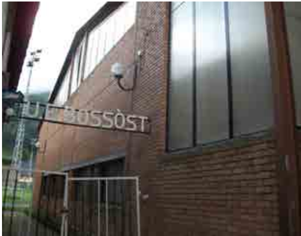
Foto 8_1-1 Fachada del edificio
