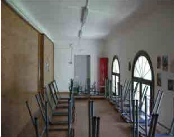
Foto 23_1-19 Detalles del techo y fisuras
