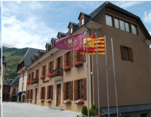
Foto 1_1-2 Vista de la fachada del edificio antiguo
