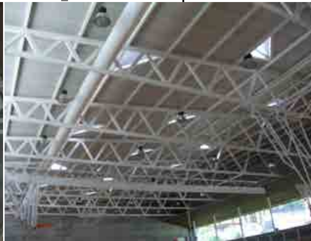
Foto 17_1-4 Detalle de cerchas
