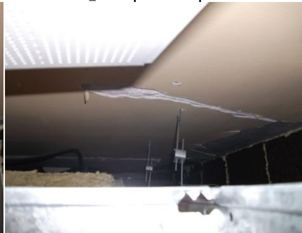
Foto 1_2-5 Inspección de forjados y pilares
