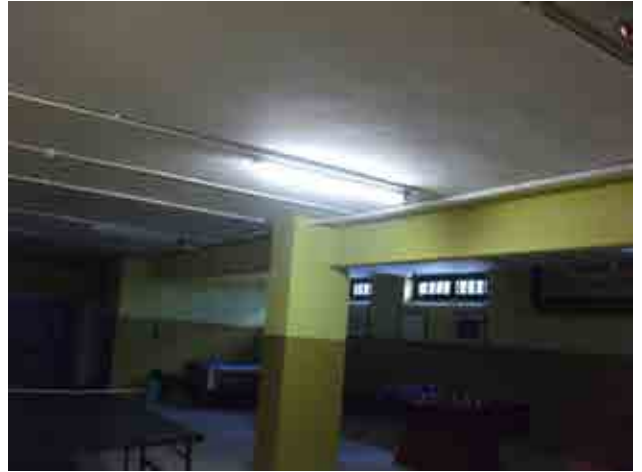
Foto 25_1-14 Columnas de planta baja
