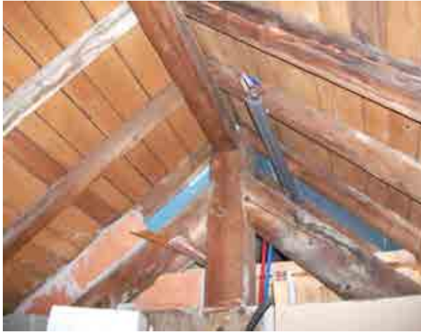
Foto 19_1-7 Estructura del techo
