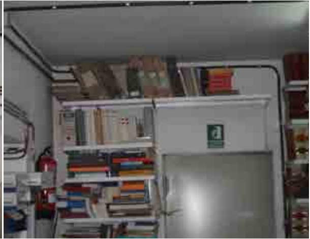
Foto 22_1-8 Inspección de muros
