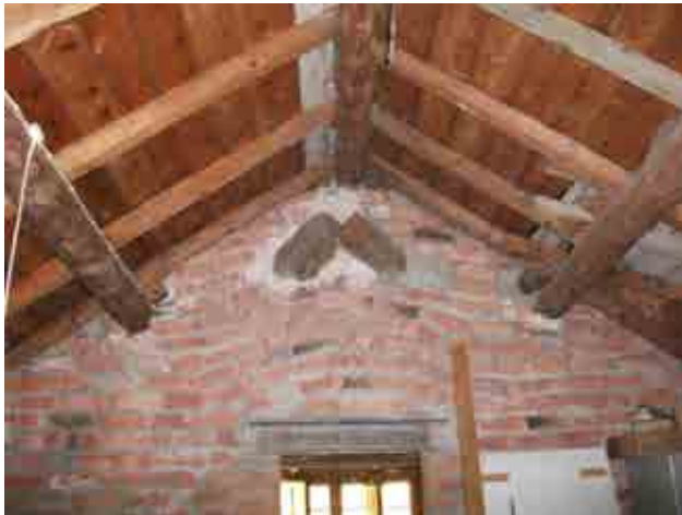
Foto 11_1-13 Inspección del techo del edificio
