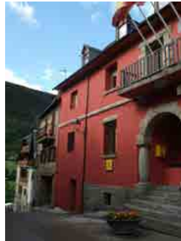
Foto 22_1-2 Fachada del edificio
