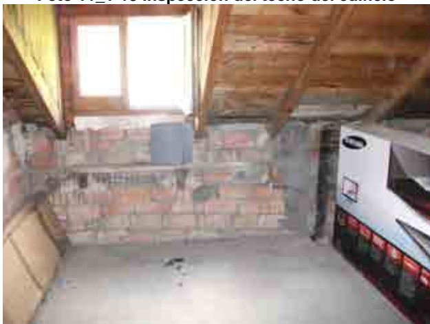
Foto 11_1-15 Inspección del techo del edificio
