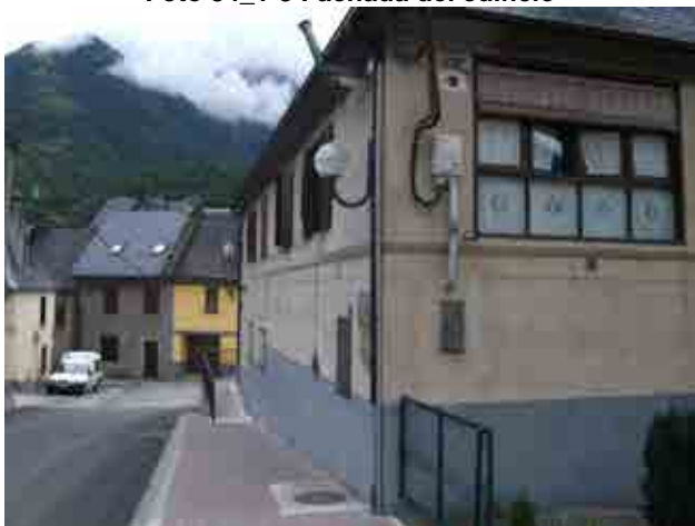
Foto 34_1-5 Fachada del edificio
