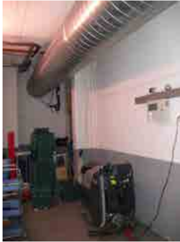
Foto 13_1-7 Muros de la sección de oficina
