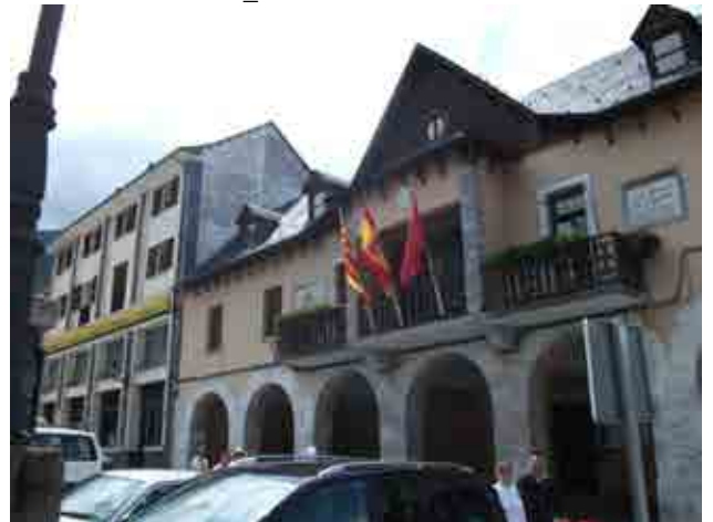
Foto 14_1-4 Fachada del edificio
