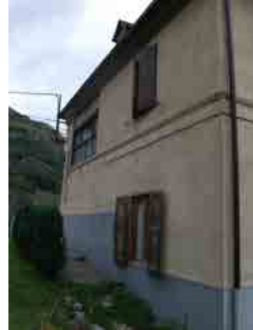
Foto 34_1-4 Fachada del edificio
