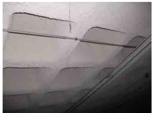
Foto 32_1-7 Detalle del forjado
