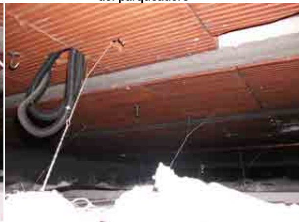
Foto 19_1-16 Reformas realizadas a los forjados del parqueadero
