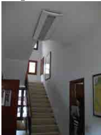
Foto 3_1-3 Inspección del forjado
