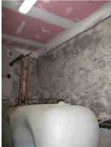
Foto 6_1-7 Revisión de entresijos (Zona de almacenamiento de combustible)
