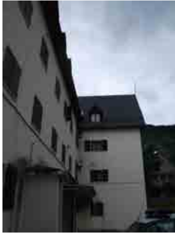
Foto 5_1-1 Fachada del edificio
