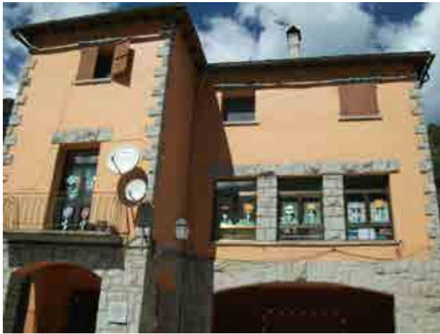
Foto 28_1-1 Fachada del edificio
