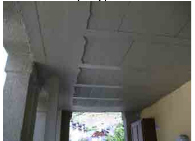
Foto 26_1-6 Forjados primera planta-Viguetas y laminas de hormigón armado
