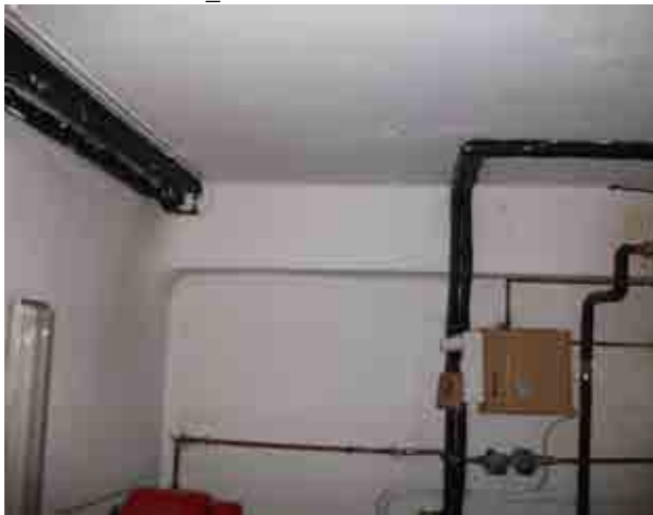
Foto 20_1-9 Muros interiores del edificio
