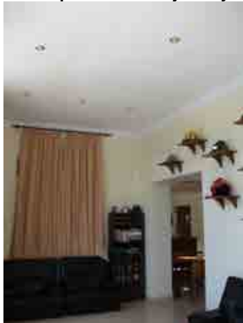
Foto 11_1-11 Muros internos del edificio
