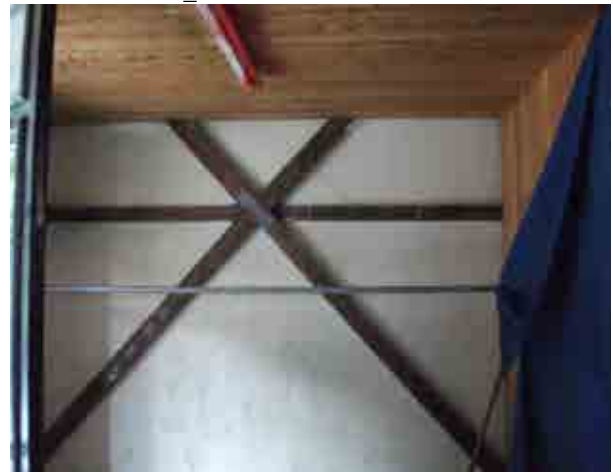
Foto 10_1-4 Detalle de las cerchas
