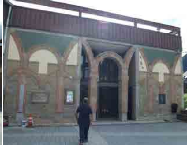
Foto 24_1-2 Fachada del edificio
