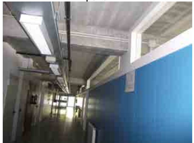
Foto 15_1-4 Detalle de vigas y forjados, primera planta
