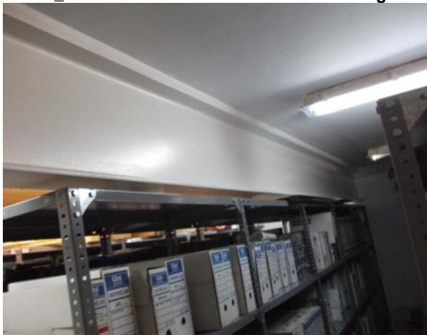
Foto 1_1-5 Reformas en el edificio: Vigas metálicas en techos
