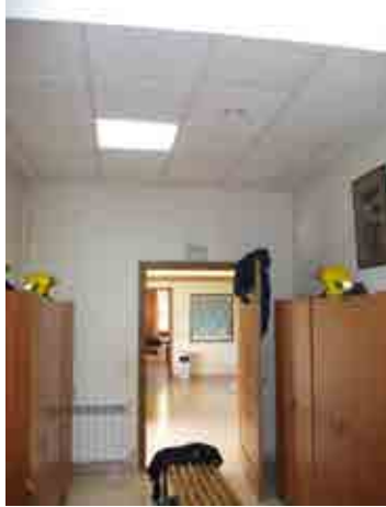
Foto 11_1-9 Inspección de forjados y de muros
