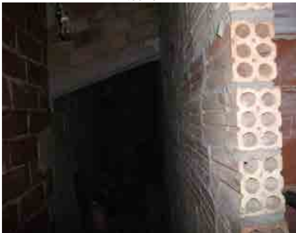
Foto 20_1-15 Muros del edificio y estructura del techo
