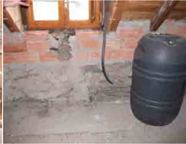
Foto 19_1-8 Inspección de los muros
