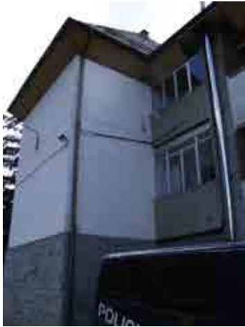
Foto 20_1-5 Fachada del edificio
