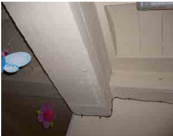
Foto 26_1-21 Detalle las vigas y los forjados
