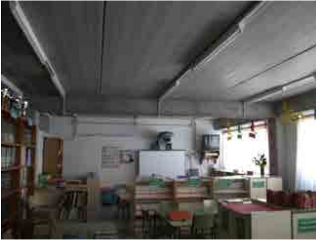
Foto 15_1-7 Conexiones viga pilar, forjados y muros interiores
