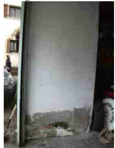
Foto 5_1-6 Identificación de materiales de los muros
