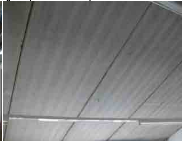
Foto 15_1-29 Detalle de los forjados (segunda planta)
