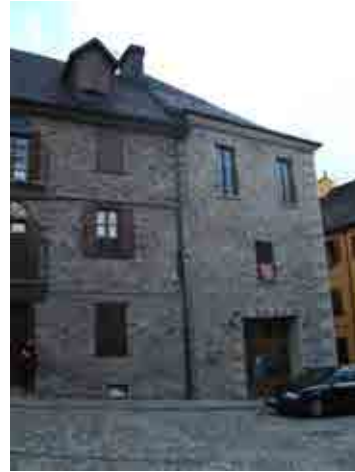
Foto 6_1-2 Fachada del edificio
