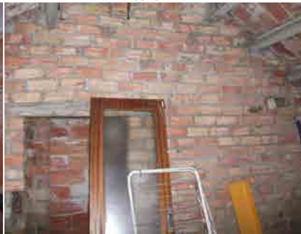
Foto 20_1-16 Muros del edificio y estructura del techo
