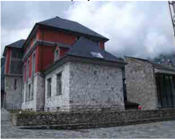
Foto 2_2-2 Fachada del edificio
