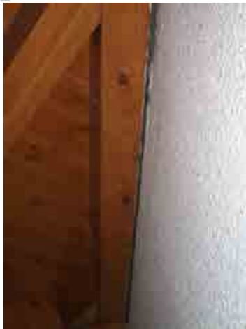
Foto 33_1-15 Detalle de la estructura del techo
