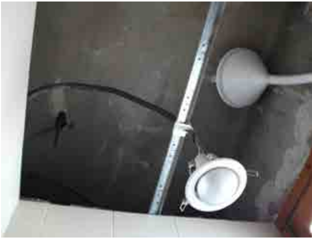
Foto 14_1-15 Inspección de materiales de muros y forjados
