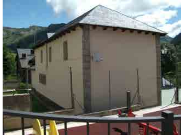
Foto 27_1-2 Fachada del edificio
