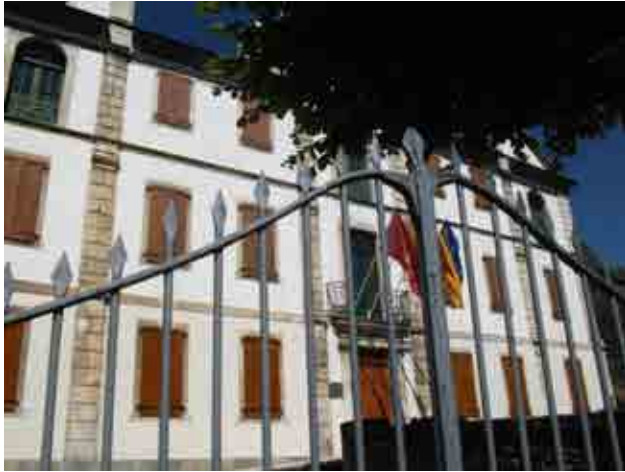
Foto 30_1-1 Fachada del edificio
