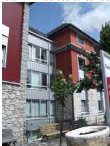
Foto 2_2-4 Fachada del edificio: conexión de la ampliación de la residencia
