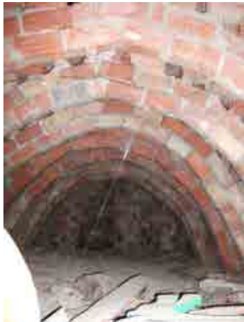
Foto 27_1-13 Estructura del techo y muros del edificio
