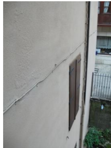
Foto 1_1-4 Vista de la fachada del edificio antiguo
