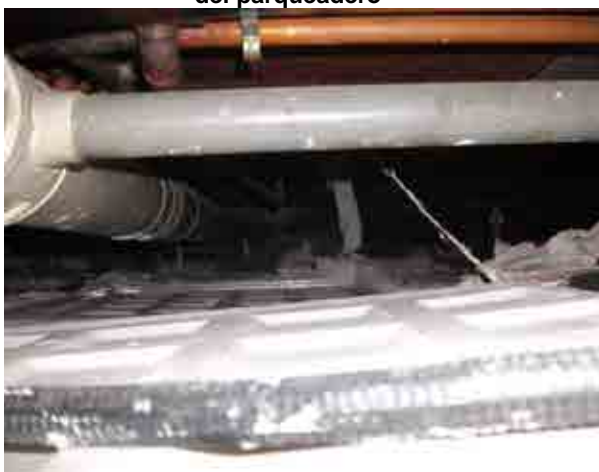
Foto 19_1-17 Reformas realizadas a los forjados del parqueadero
