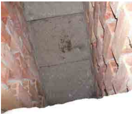
Foto 28_1-21 Estructura del techo y muros del edificio
