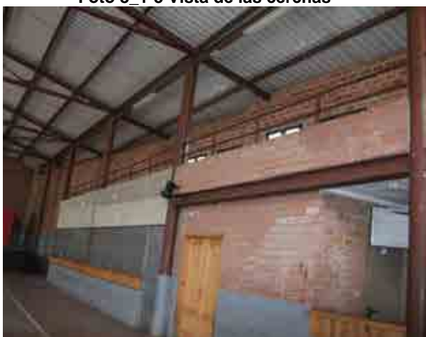
Foto 8_1-5 Vista de las cerchas
