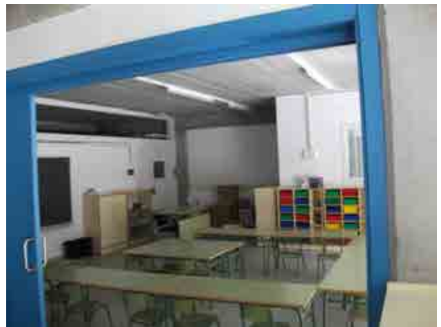
Foto 15_1-6 Detalle de la tabiquería y configuración de salones
