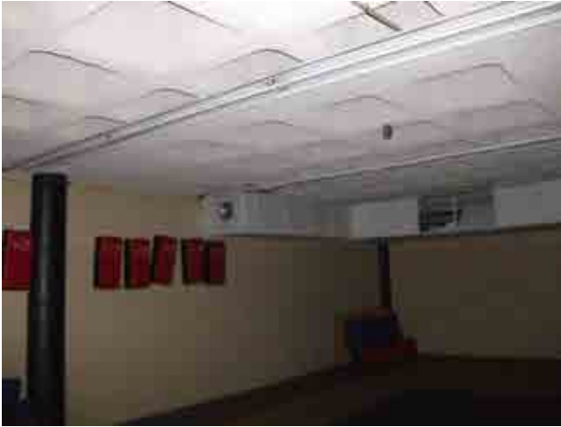
Foto 32_1-8 Detalle del forjado
