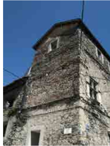
Foto 30_1-14 Fachada del edificio
