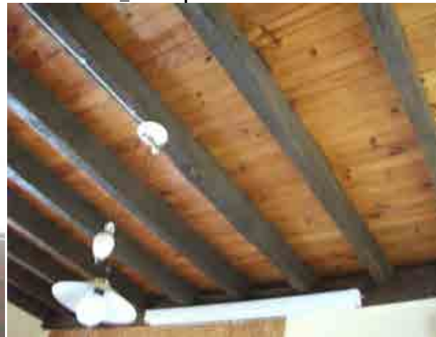
Foto 19_1-10 Reformas realizadas a los forjados - vigas de madera
