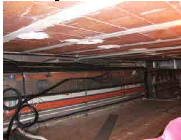
Foto 3_1-4 Inspección del forjado
