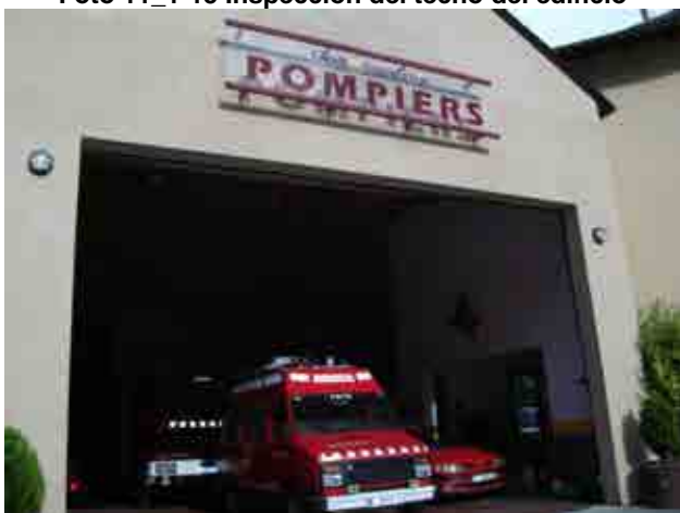
Foto 11_2-1 Fachada del edificio (parqueadero)
