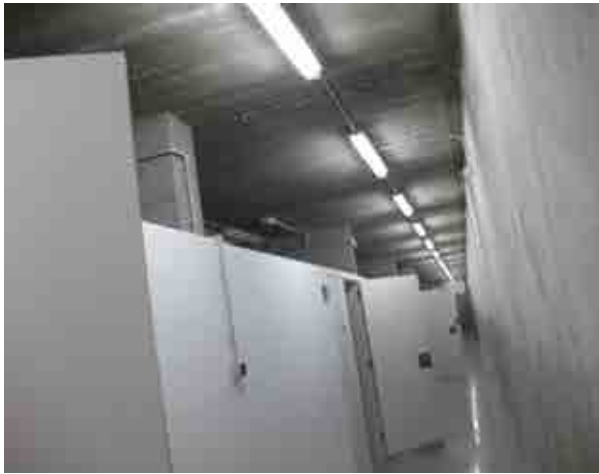
Foto 17_1-9 Forjados de la zona de graderías y muros resistentes
