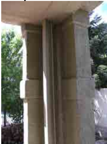
Foto 26_1-5 Forjados primera planta-Viguetas y laminas de hormigón armado
