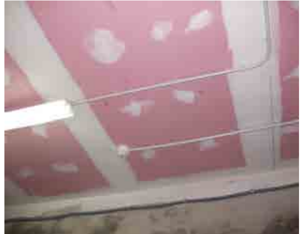
Foto 6_1-8 Revisión de entresijos (Zona de almacenamiento de combustible)
