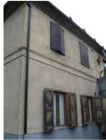
Foto 34_1-2 Fachada del edificio
