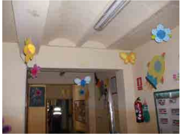
Foto 26_1-14 Forjados - Viguetas y Bóvedillas hormigón armado
