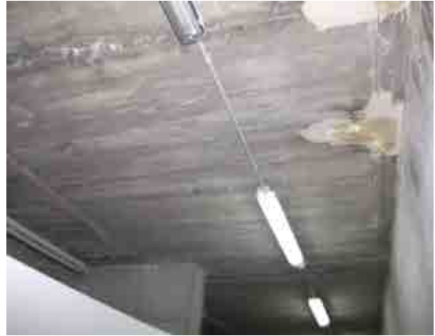
Foto 17_1-8 Forjados de la zona de graderías y muros resistentes
