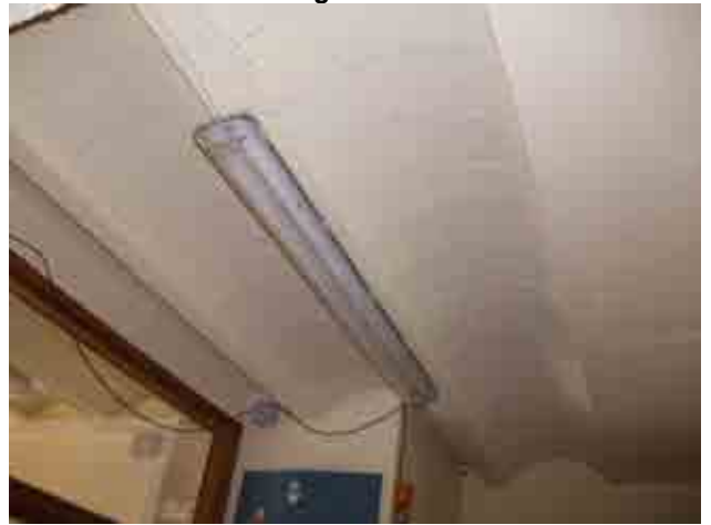
Foto 26_1-16 Forjados - Viguetas y Bóvedillas hormigón armado
