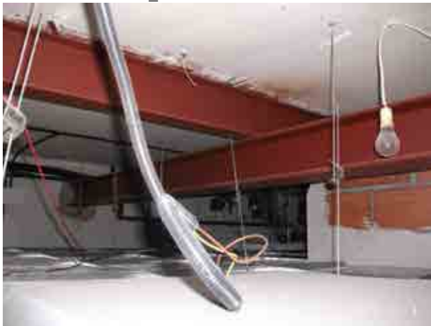
Foto 11_1-5 Inspección de forjados y de muros
