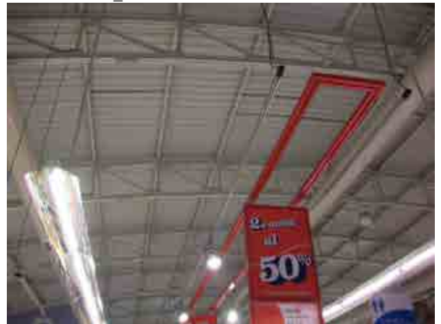
Foto 13_1-12 Cercha del supermercado
