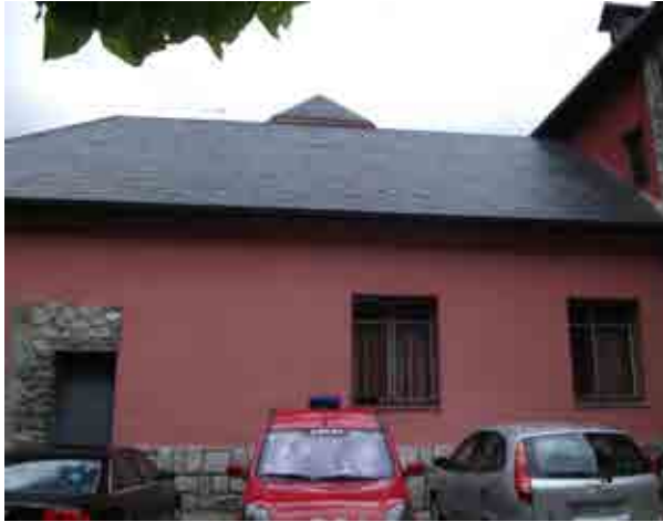
Foto 10_1-1 Fachada del edificio
