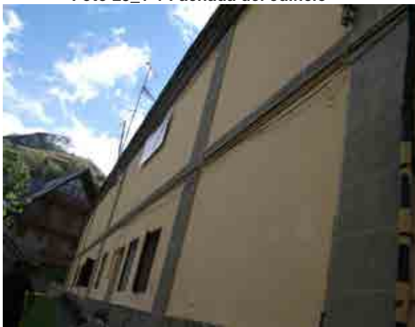
Foto 23_1-3 Fachada del edificio
