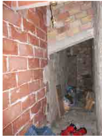
Foto 20_1-14 Muros del edificio y estructura del techo
