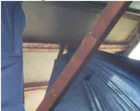
Foto 10_1-5 Detalle de las cerchas
