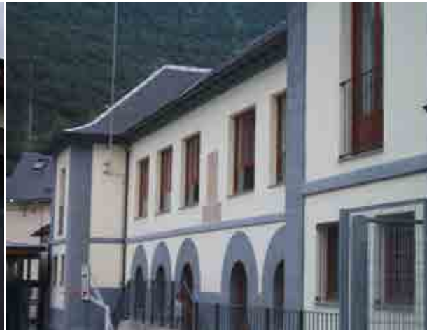
Foto 9_1-2 Fachada del edificio
