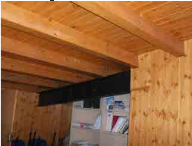
Foto 33_1-11 Detalle de la estructura del techo
