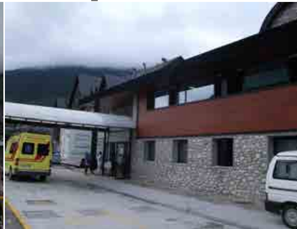
Foto 2_1-4 Fachada del edificio
