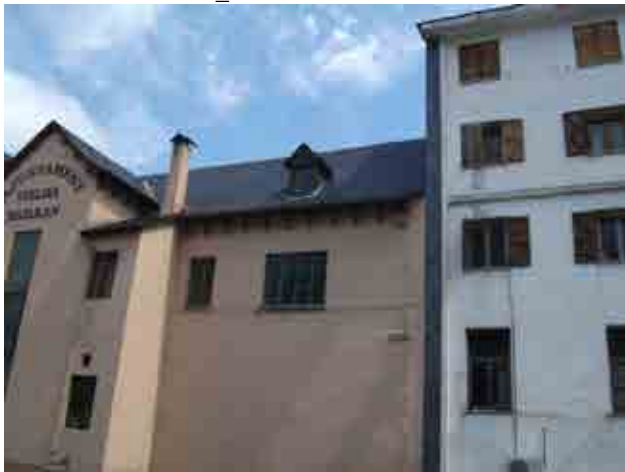
Foto 14_1-3 Fachada del edificio
