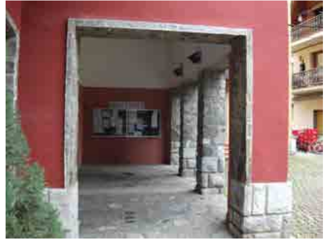
Foto 35_1-2 Fachada del edificio
