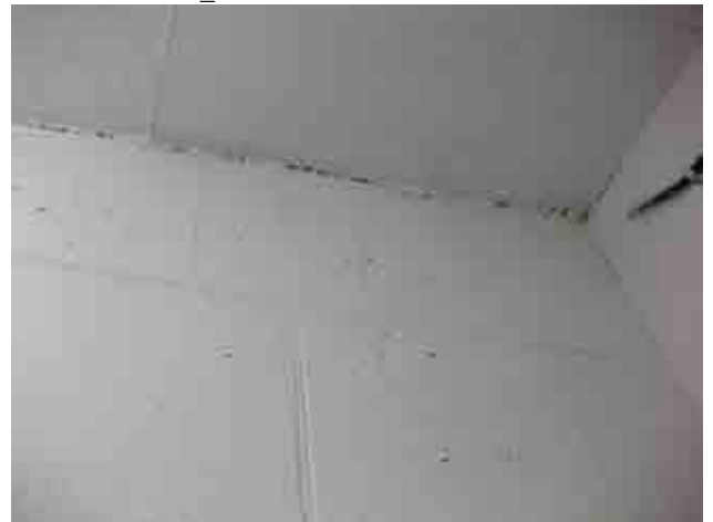
Foto 31_1-10 Detalle de muros interiores
