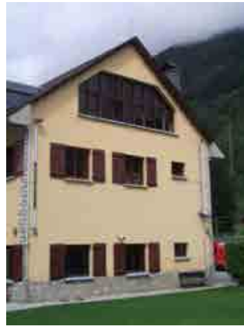
Foto 3_1-2 Fachada del edificio
