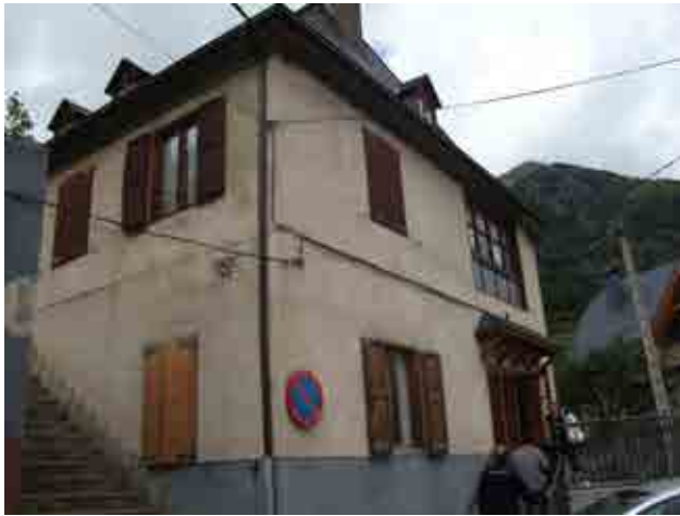
Foto 34_1-1 Fachada del edificio
