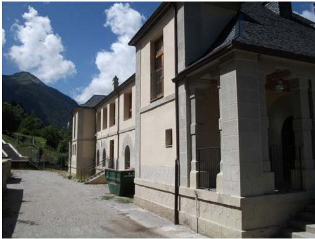
Foto 29_1-1 Fachada del edificio
