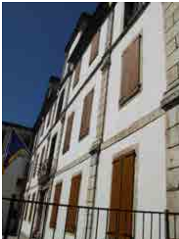
Foto 30_1-5 Fachada del edificio
