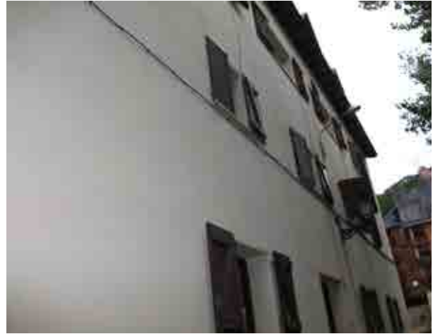
Foto5_1-2 Fachada del edificio
