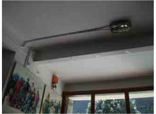
Foto 27_1-8 Reformas en el techo de la primera planta. Adición de vigas metálicas
