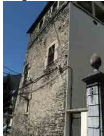
Foto 30_1-12 Fachada del edificio
