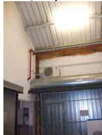
Foto 13_1-6 Muros, techo y cercha de la estructura
