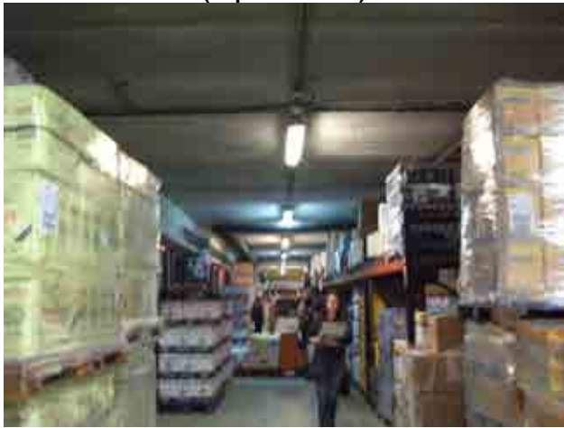
Foto 12_1-3 Pilares, vigas y forjado planta subterránea (supermercado)
