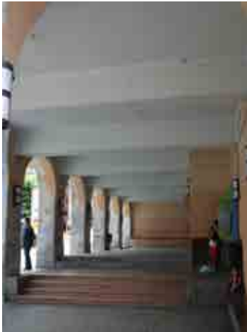
Foto 14_1-9 Detalle de los arcos en la planta baja
