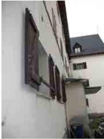
Foto 5_1-3 Fachada del edificio
