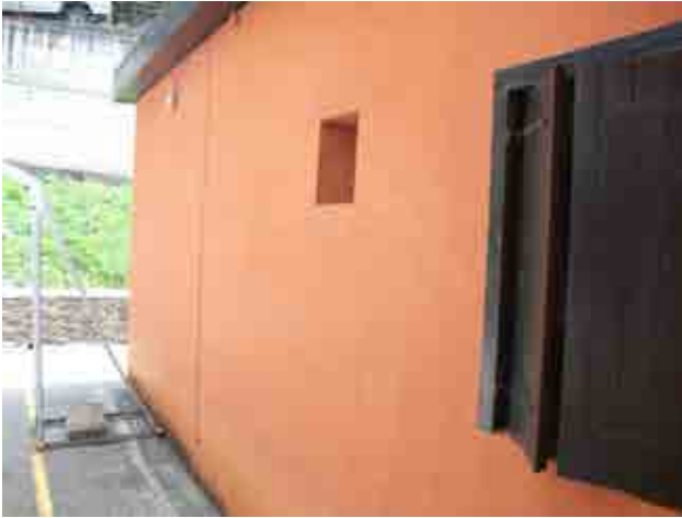
Foto 25_1-13 Fachadas de la zona del apartamento
