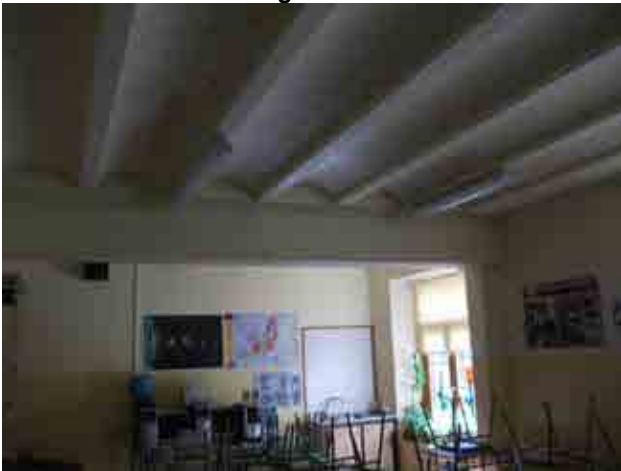
Foto 26_1-17 Forjados - Viguetas y Bóvedillas hormigón armado
