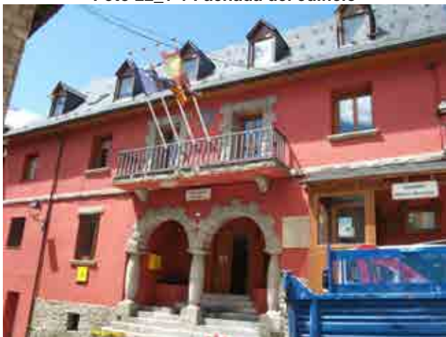
Foto 22_1-3 Fachada del edificio
