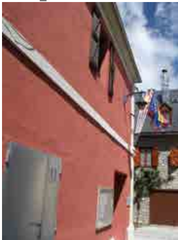
Foto 33_1-5 Fachada del edificio
