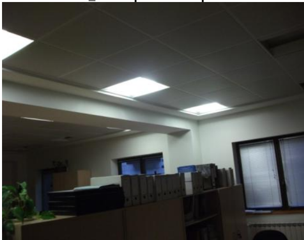
Foto 1_2-6 Inspección de forjados y pilares
