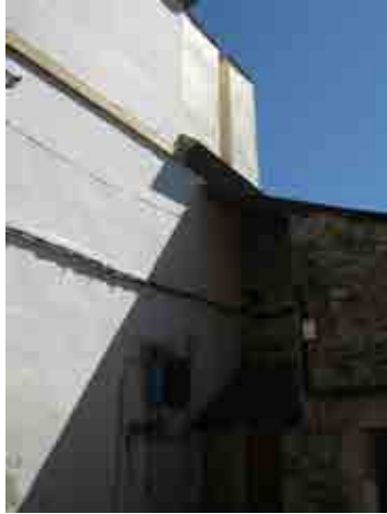
Foto 30_1-9 Fachada del edificio
