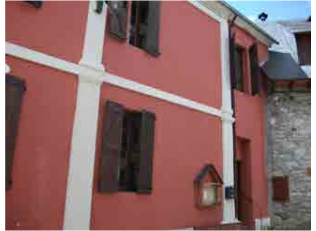
Foto 33_1-2 Fachada del edificio
