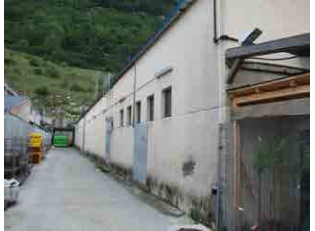
Foto 13_1-2 Fachada del edificio
