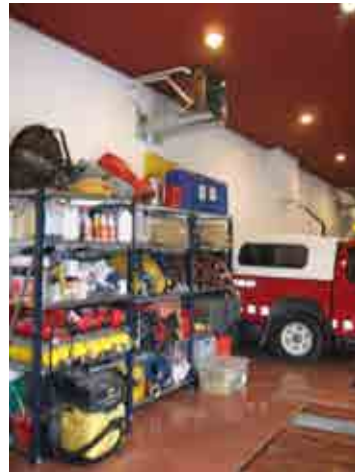
Foto 19_1-14 Reformas realizadas a los forjados del parqueadero
