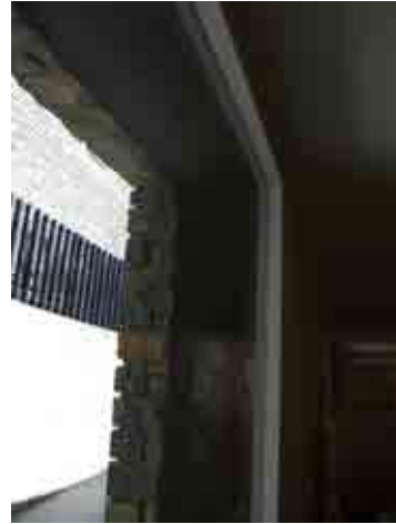
Foto 31_1-8 Detalle de muros interiores
