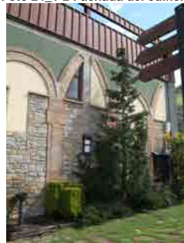
Foto 24_1-4 Fachada del edificio
