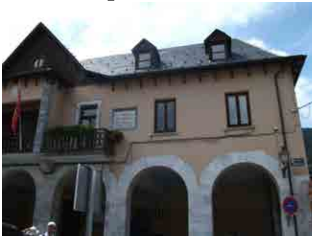
Foto 14_1-5 Fachada del edificio
