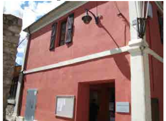
Foto 33_1-4 Fachada del edificio
