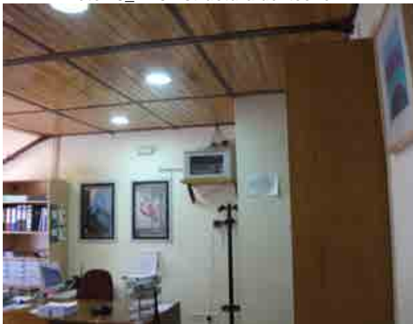
Foto 25_1-30 Estructura del techo
