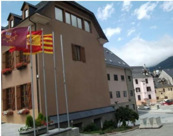
Foto 1_1-1 Vista de la fachada del edificio antiguo
