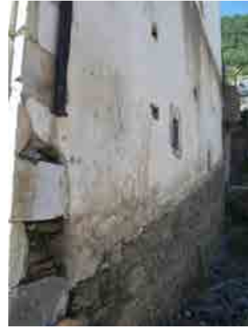
Foto 30_1-2 Fachada del edificio
