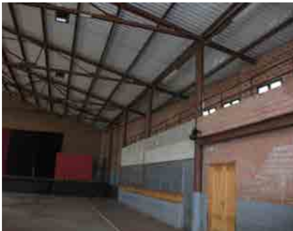
Foto 8_1-3 Vista de las cerchas
