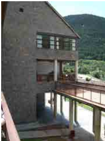
Foto 25_1-3 Fachada del edificio
