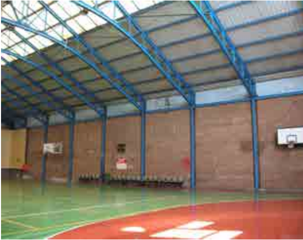
Foto 18_1-7 Distribución de pilares metálicos
