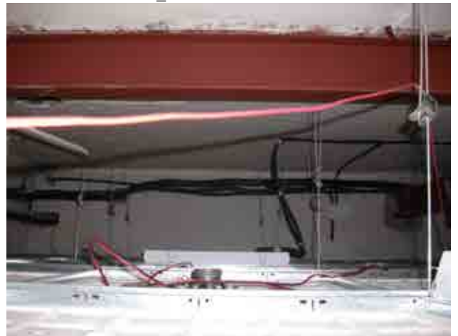
Foto 11_1-6 Inspección de forjados y de muros
