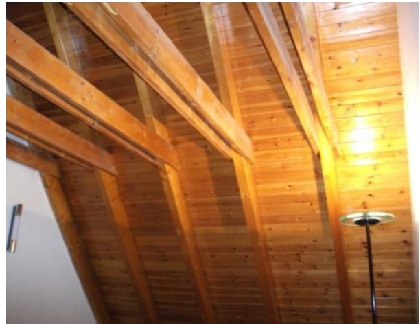
Foto 1_1-8 Estructura de los techos
