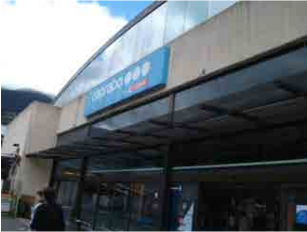
Foto 13_1-1 Fachada del edificio
