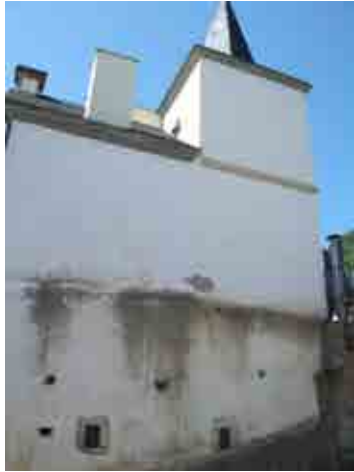
Foto 30_1-7 Fachada del edificio
