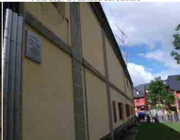
Foto 23_1-4 Fachada del edificio
