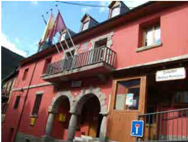
Foto 22_1-1 Fachada del edificio
