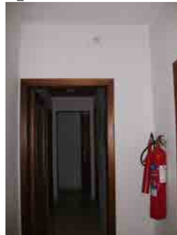
Foto 20_1-12 Muros interiores del edificio
