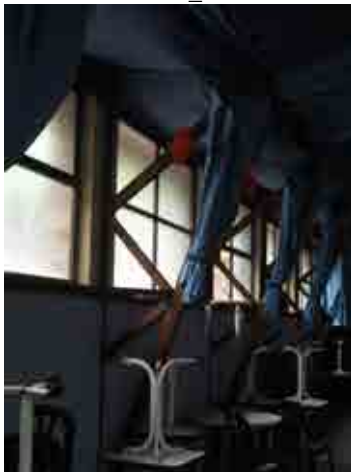
Foto 10_1-3 Detalle de las cerchas
