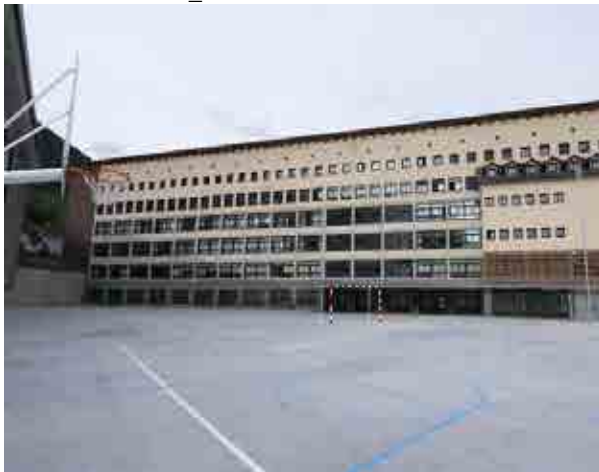
Foto 16_1-5 Fachada del edificio
