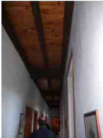
Foto 19_1-13 Reformas realizadas a los forjados - vigas de madera
