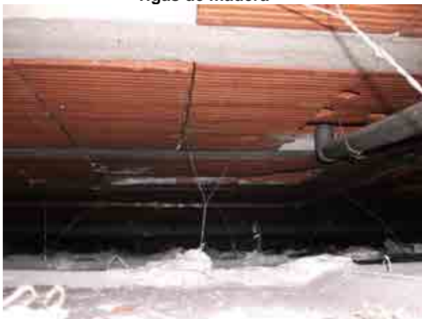
Foto 19_1-15 Reformas realizadas a los forjados del parqueadero
