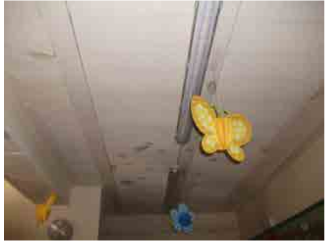
Foto 26_1-8 6 Forjados primera planta-Viguetas y laminas de hormigón armado
