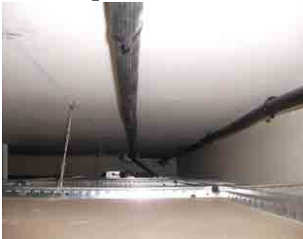
Foto5_1-5 Inspección del forjado
