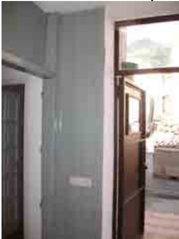
Foto 18_1-11 Detalle de muros
