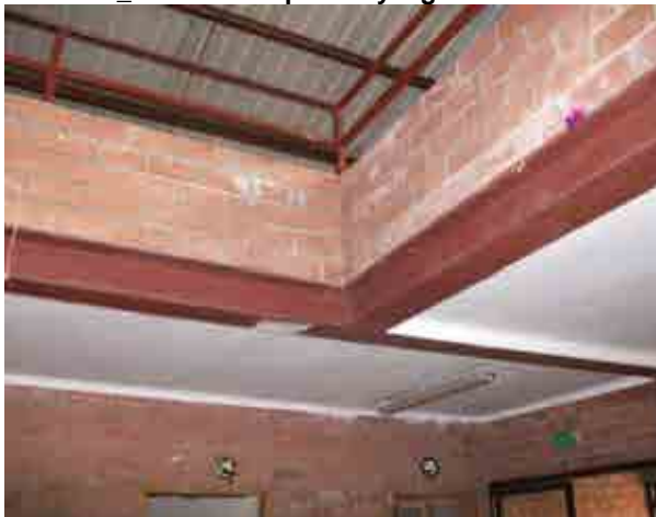
Foto 8_1-9 Detalle de vigas
