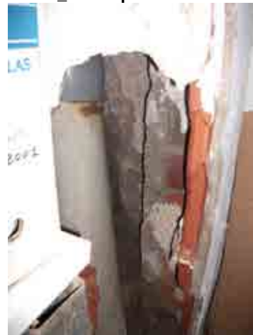
Foto 22_1-10 Inspección de muros
