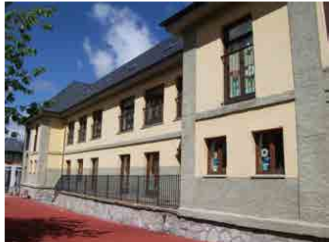
Foto 26_1-2 Fachada del edificio
