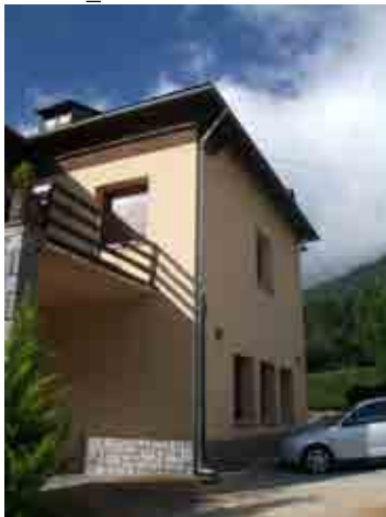
Foto 11_1-3 Fachada del edificio
