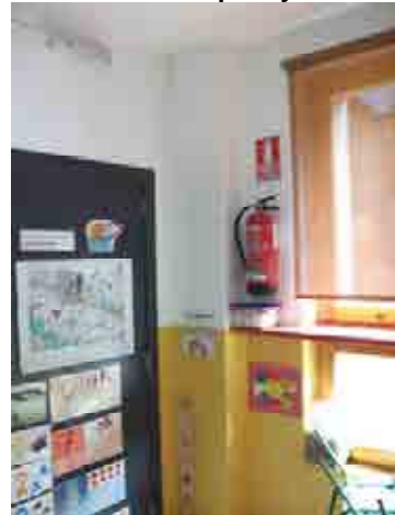
Foto 29_1-10 Inspección de la tabiquería de mampostería
