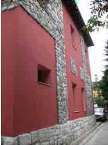
Foto 35_1-1 Fachada del edificio
