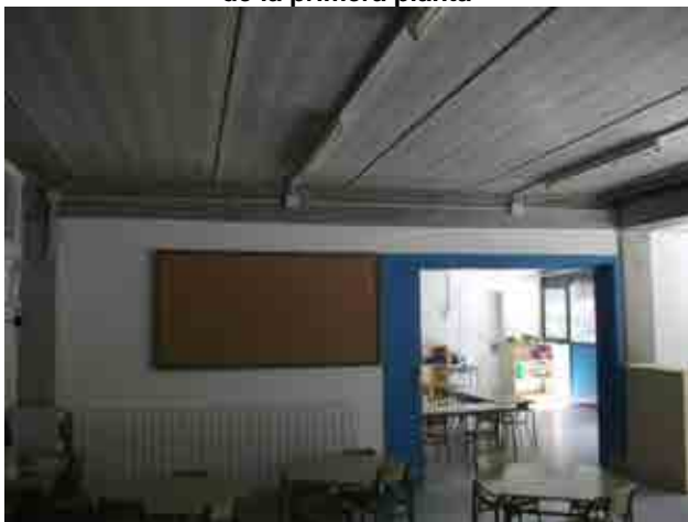
Foto 15_1-5 Detalle de la tabiquería y configuración de salones
