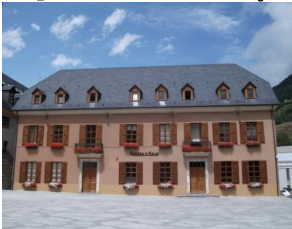
Foto 1_1-3 Vista de la fachada del edificio antiguo
