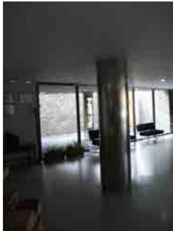
Foto 15_1-1 Detalles de pilares revestidos
