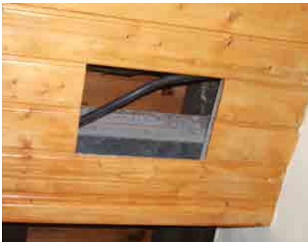
Foto 19_1-11 Reformas realizadas a los forjados - vigas de madera
