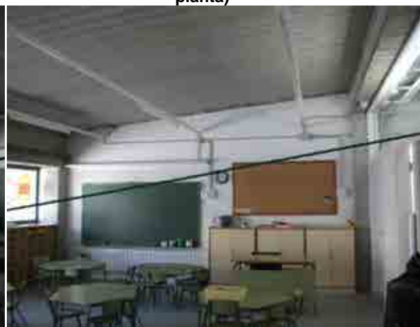
Foto 15_1-31 Distribución de pilares en salones - posibilidad de columna corta
