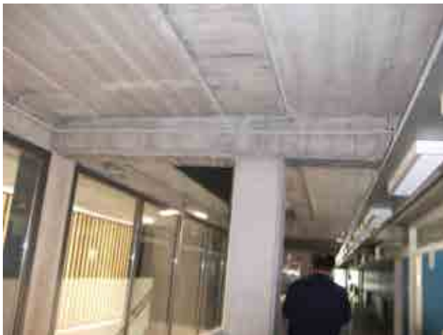
Foto 15_1-3 Detalle de conexiones viga-pilar y forjados de la primera planta
