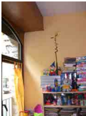
Foto 6_1-12 Vista de los muros (EEI)
