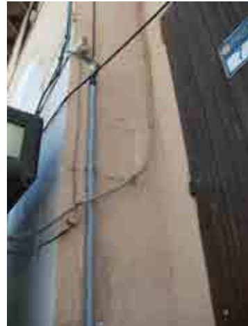
Foto 14_1-10 Detalle de los muros
