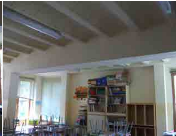
Foto 26_1-20 Forjados - Viguetas y Bóvedillas hormigón armado
