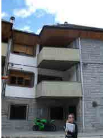
Foto 20_1-7 Fachada del edificio
