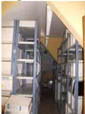
Foto 6_1-5 Techo del edificio
