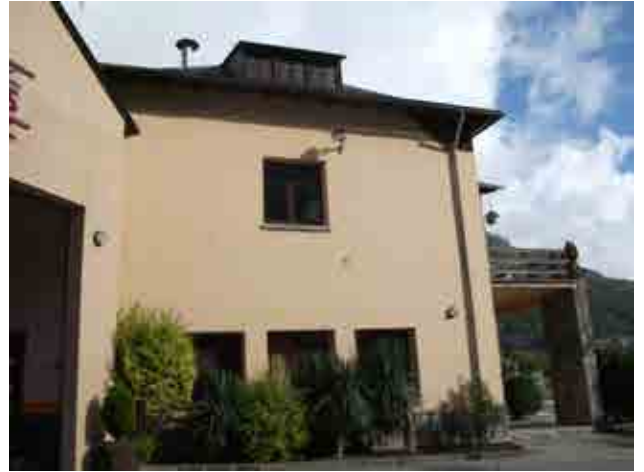
Foto 11_1-2 Fachada del edificio
