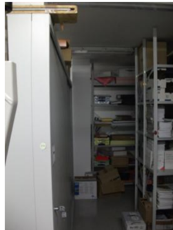
Foto 1_1-6 Reformas en el edificio: Vigas metálicas en techos
