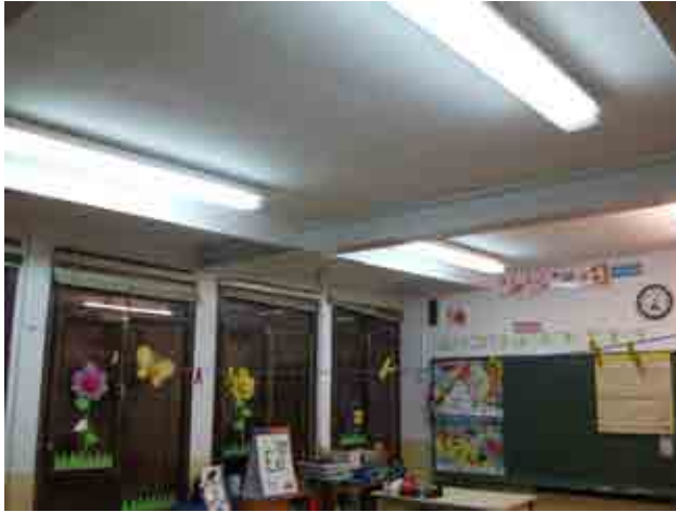
Foto 27_1-7 Reformas en el techo de la primera planta. Adición de vigas metálicas
