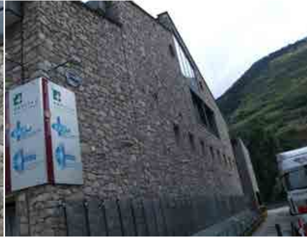
Foto 2_1-2 Fachada del edificio
