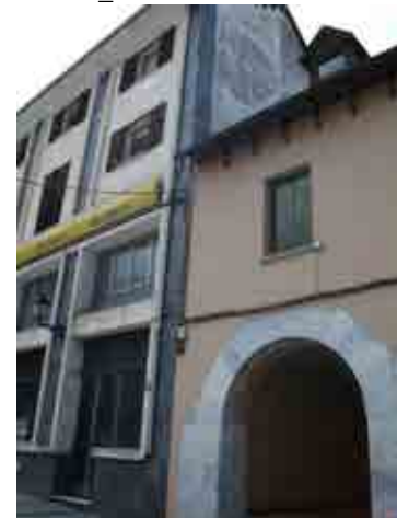
Foto 14_1-6 Fachada del edificio
