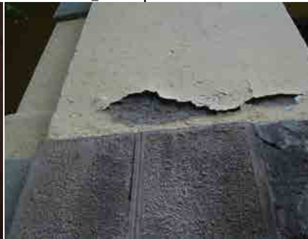
Foto 23_1-12 Inspección de muros
