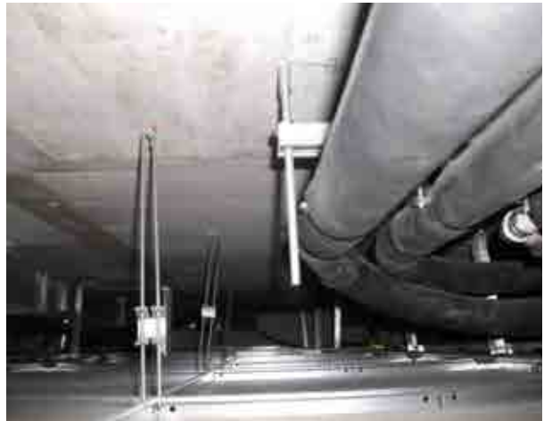
Foto 2_2-7 Vista del tipo de forjado
