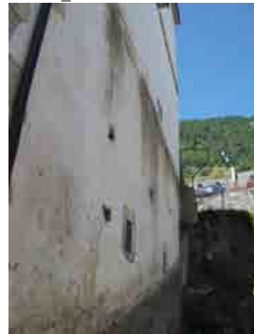
Foto 30_1-4 Fachada del edificio
