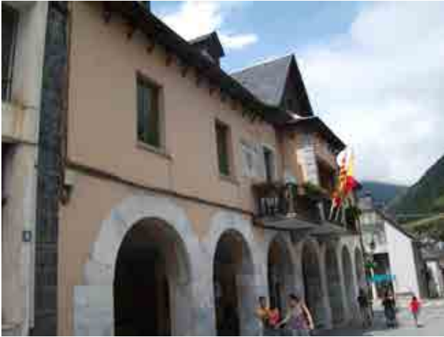
Foto 14_1-7 Fachada del edificio
