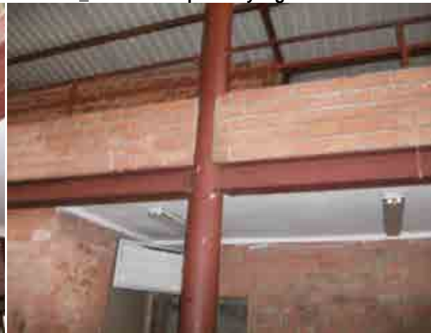
Foto 8_1-10 Detalle de Pilares y vigas
