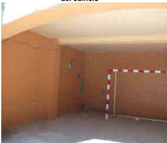
Foto 28_1-23 Detalle de pilares y jácenas para soportar el techo
