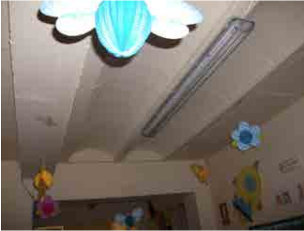
Foto 26_1-13 Forjados - Viguetas y Bóvedillas hormigón armado o
