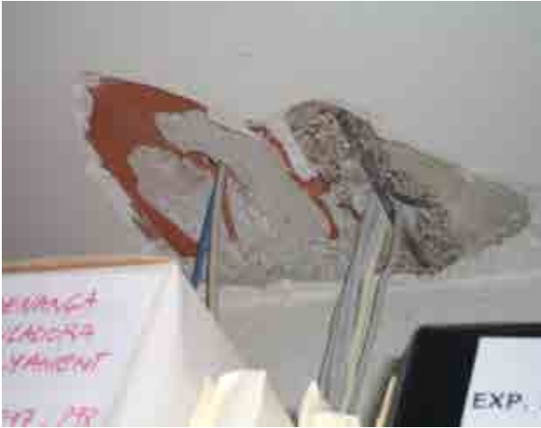
Foto 22_1-13 Inspección de muros
