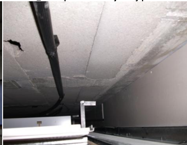
Foto 1_2-7 Inspección de forjados y pilares
