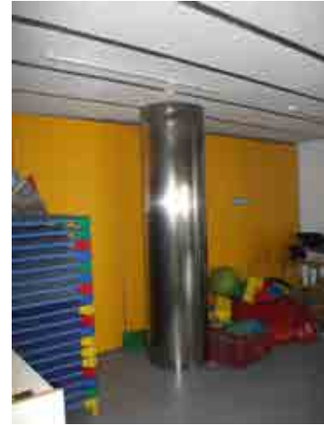
Foto 15_1-27 Detalles de pilares revestidos
