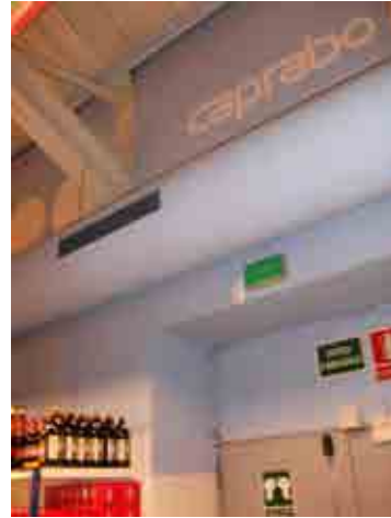
Foto 13_1-14 Detalles de la cercha y muros de la estructura
