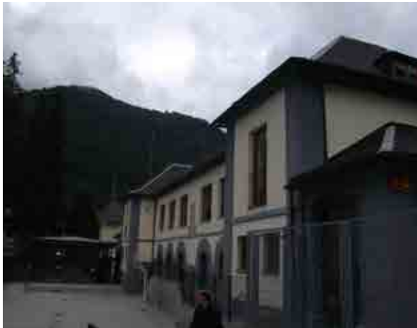
Foto 9_1-1 Fachada del edificio
