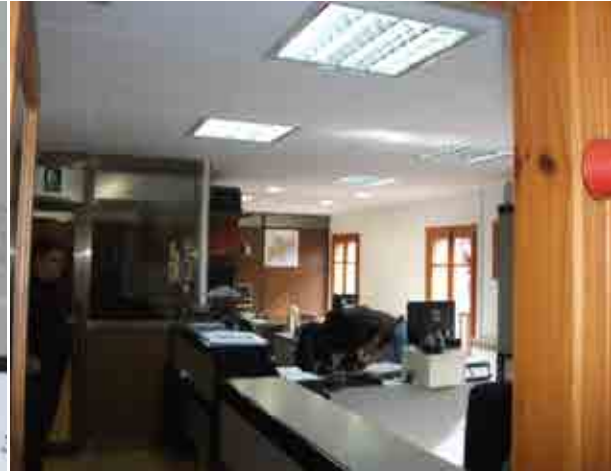
Foto 22_1-14 Inspección de muros
