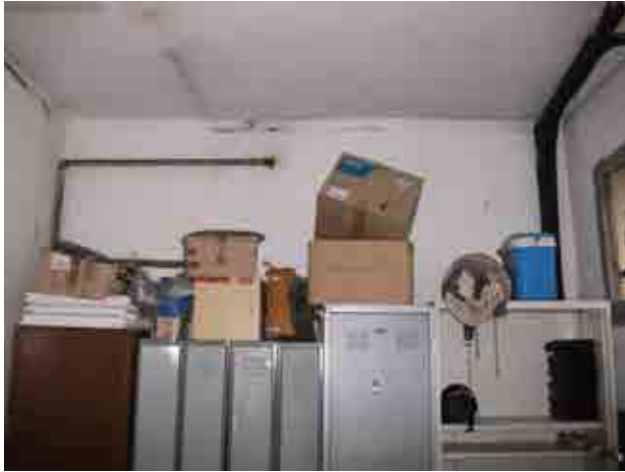
Foto 5_1-7 Muros interiores del edificio
