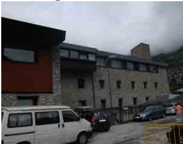
Foto 2_1-3 Fachada del edificio
