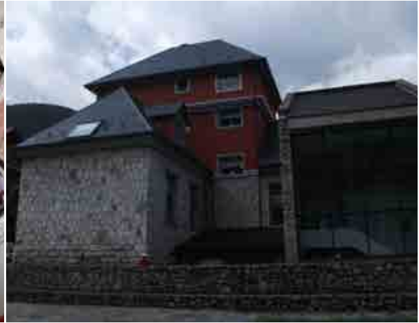
Foto 2_2-1 Fachada del edificio
