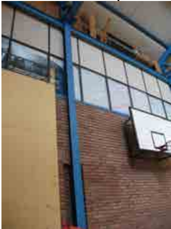
Foto 18_1-9 Detalles de los pilares
