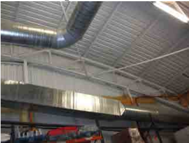
Foto 13_1-5 Muros, techo y cercha de la estructura
