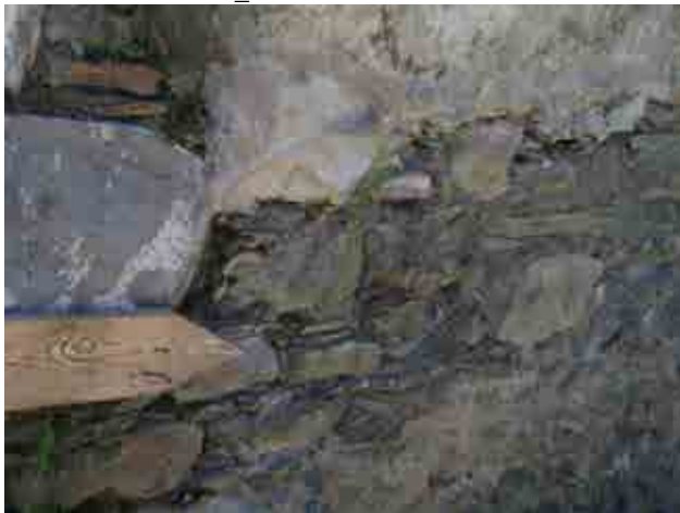
Foto 30_1-3 Detalle de los materiales de los muros
