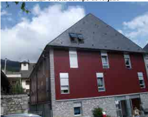
Foto 2_3-2 Fachada del edificio
